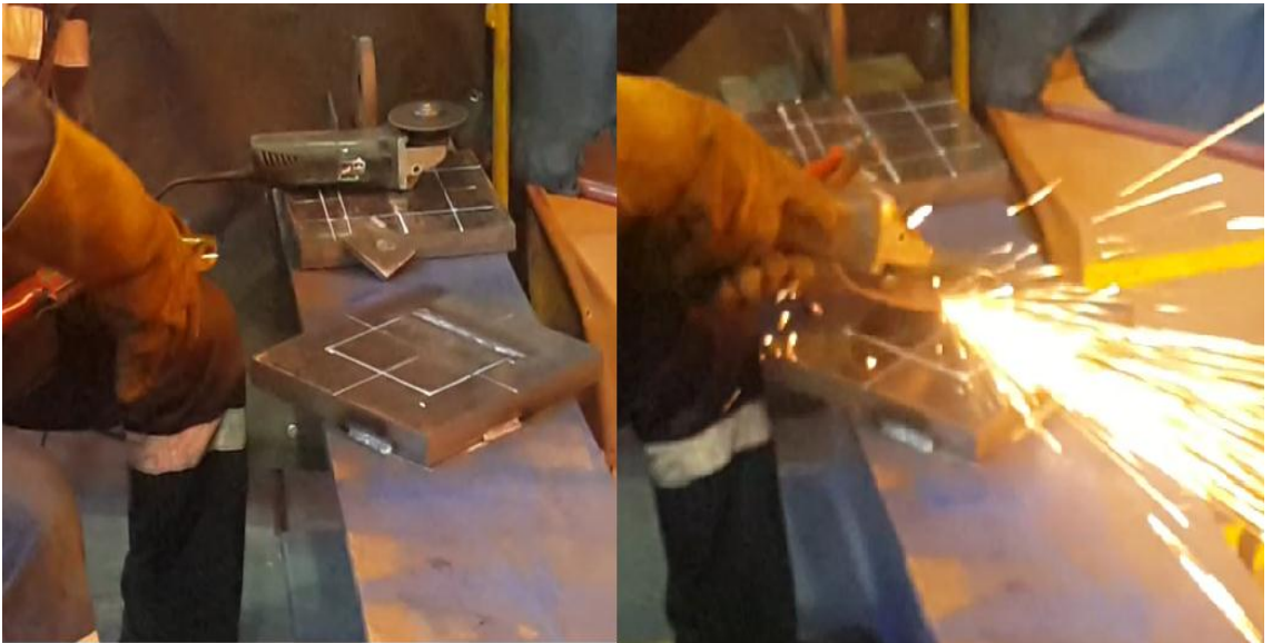
Şekil 7.15 Paso sonrası temizlik işlemleri
