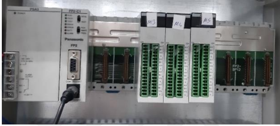
Şekil 3.16 Veri toplama cihazı (PLC)
