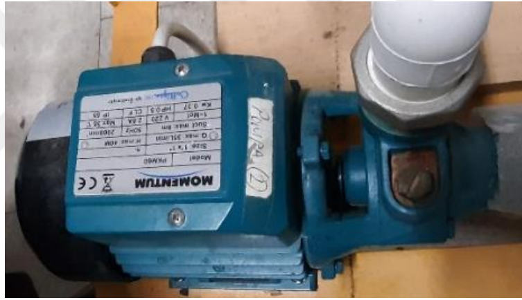
Şekil 3.9 Sirkülasyon pompası
