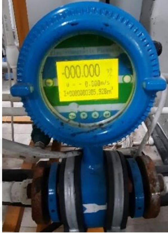
Şekil 3.11 Elektromanyetik debimetre
