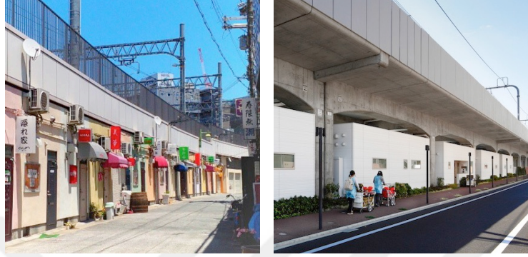
Şekil 3.73 Nioda Köprü Altı Küçük İşletmeler (solda), JR Chou Köprü Altı Anaokulu (sağda) (URL 3, 2021)
