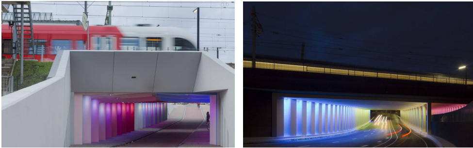
Şekil 3.61 Hollanda, Zutpen köprü altı aydınlatma örnek görseli (URL 3, 2021)
