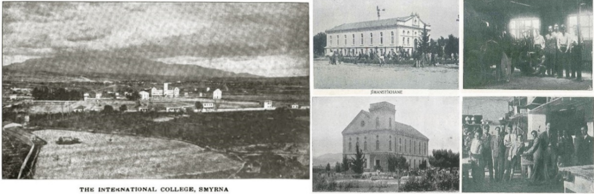
Şekil 4.19 Jimnastik Salonu (Jimnastikhane), Konferans Salonu Binası, Demir Atölyesi ve Marangozhanesiyle kentin dışında olmasından dolayı Paradiso (cennet) denilen İzmir Uluslararası Kolej Yerleşkesi (Missionary Herald, 1922: 68)
