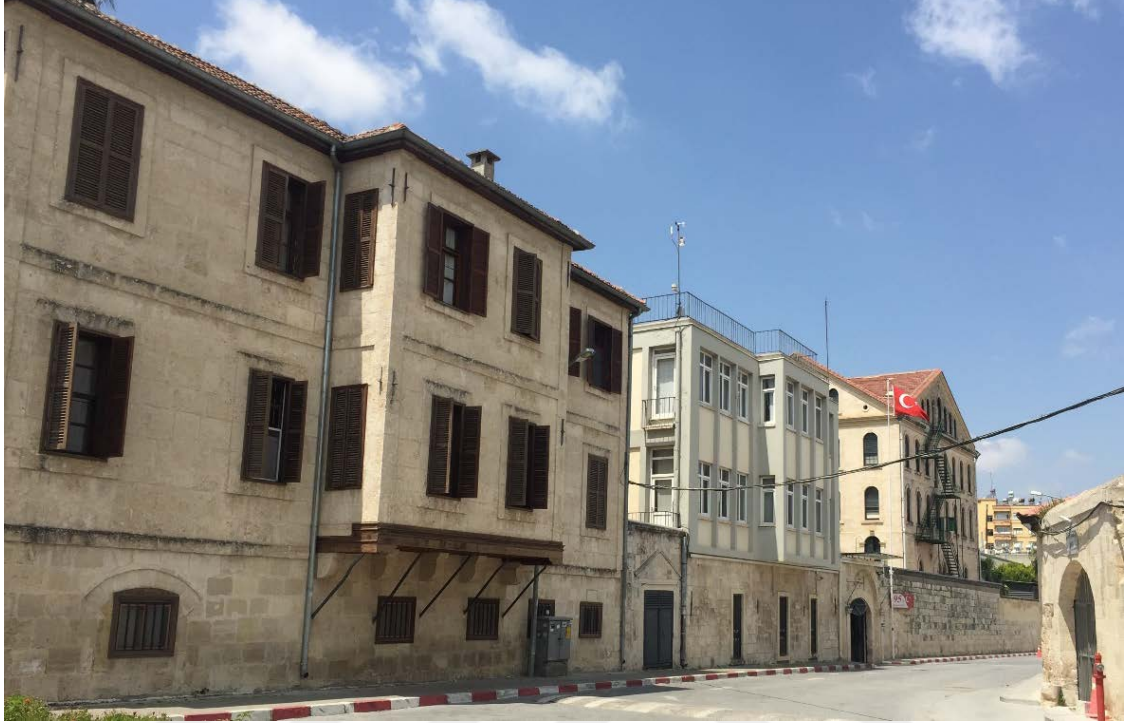
Şekil 4.38 Soldan sağa sırasıyla; ilk haliyle Christe Binası, büyük değişiklikler görmüş olan Shepard Hall ve Stickler Hall, en sağda Sadık Paşa Konağı'nın orijinal giriş kapısı (Ömer Faruk Bayram, 2019)
