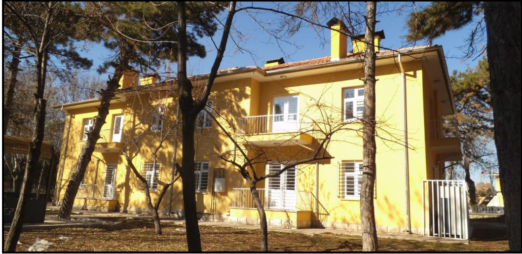
Şekil 4. 78 B yerleşkesi lojmanları güneydoğu cephesi
