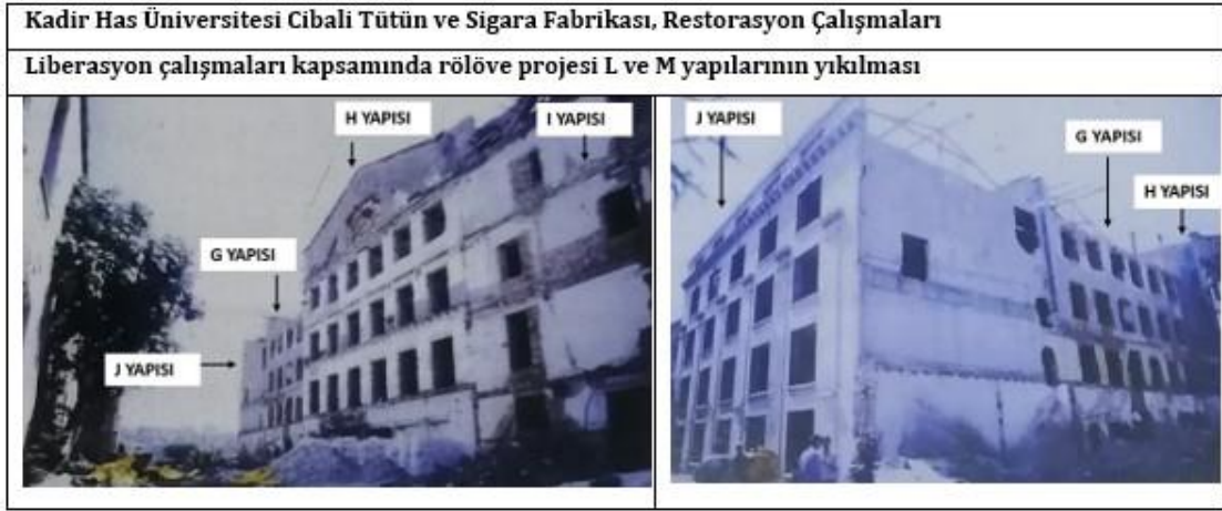
Şekil 4.101 Tarihi fabrika yapıları, liberasyon çalışmalarına ait görünümeler (Alper, 2019 üzerinden hazırlanmıştır.)
