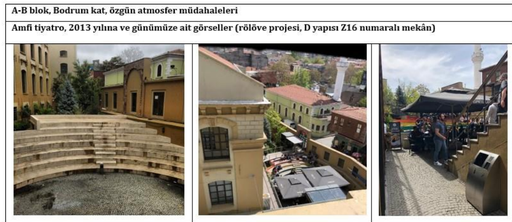
Şekil 4.150 A blok-bodrum kat, arka bahçe, özgün atmosfere yapılan müdahalelere ait görünüm (Kadir Has Üniversitesi, 2021 ve Didem Telli'nin arşivi)
