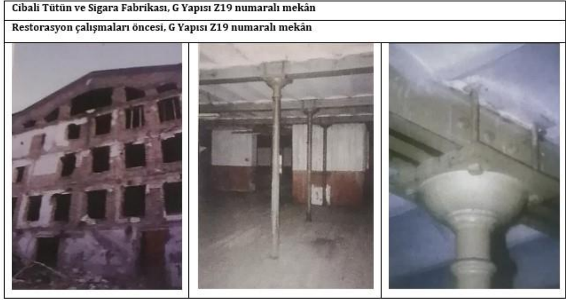
Şekil 5.18 Cibali Tütün ve Sigara fabrikası, G Yapısı Z19 numaralı mekân, restorasyon çalışmaları (Alper, 2019 üzerinden hazırlanmıştır.)
