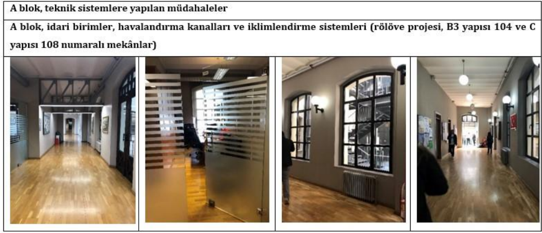
Şekil 4.128 A blok iklimlendirme sistemleriyle ilgili yapılan müdahalelere ait görünüm (Didem Telli'nin arşivi)
