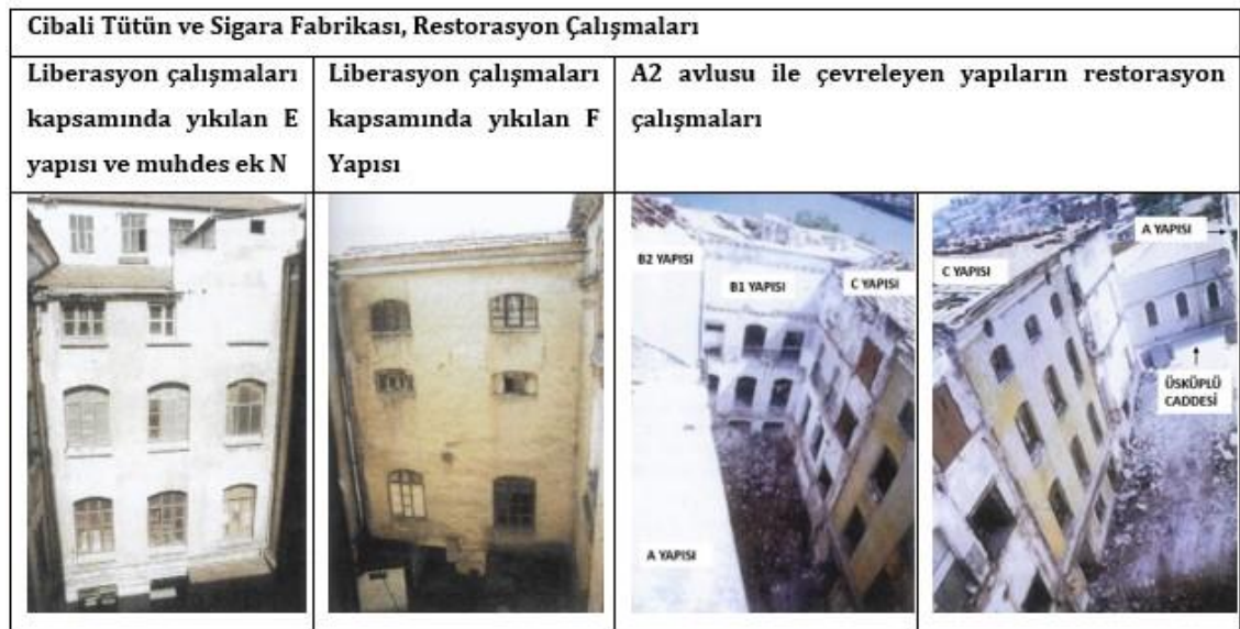
Şekil 4.94 Tarihi fabrika yapıları, liberasyon çalışmalarına ait görünüm (Alper, 2019 üzerinden hazırlanmıştır.)
