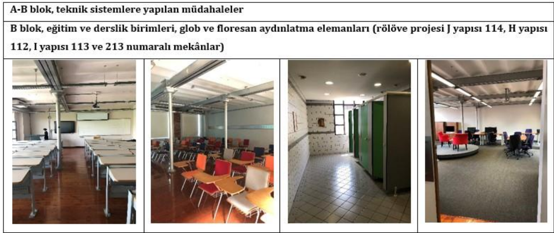
Şekil 4.127 B blok aydınlatma sistemleriyle ilgili yapılan müdahalelere ait görünüm (Didem Telli'nin arşivi)
