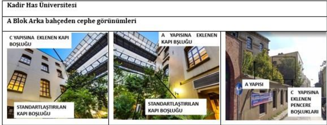
Şekil 4.123 Kadir Has Üniversitesi, A blok arka bahçeden cephe görünümü, mimari bezemelere müdahalelerin analizi (Google Haritalar, 2021 ve Kadir Has Üniversitesi, 2021 üzerinden hazırlanmıştır.)
