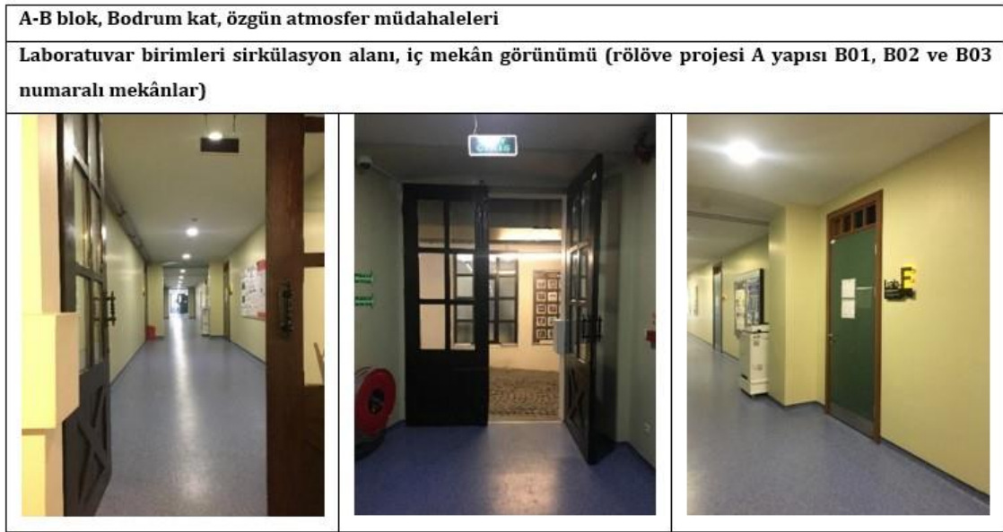
Şekil 4.147 A-B blok bodrum kat özgün atmosfere yapılan müdahalelere ait görünüm (Didem Telli'nin arşivi)
