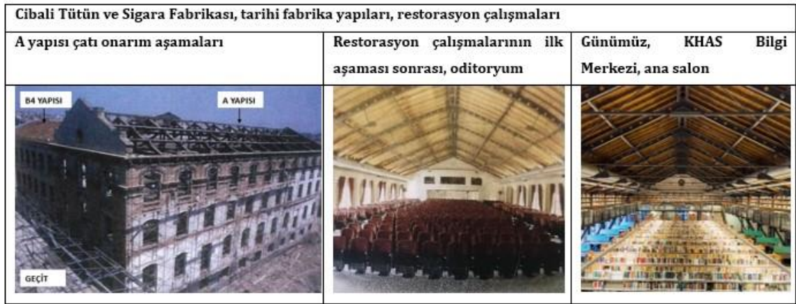
Şekil 4.88 Tarihi fabrika yapıları, rölöve projesi A yapısı çatı onarım ve yenileme çalışmalarına ait görünüm (Alper, 2019 ve Kadir Has Üniversitesi, 2021) üzerinden hazırlanmıştır.)
