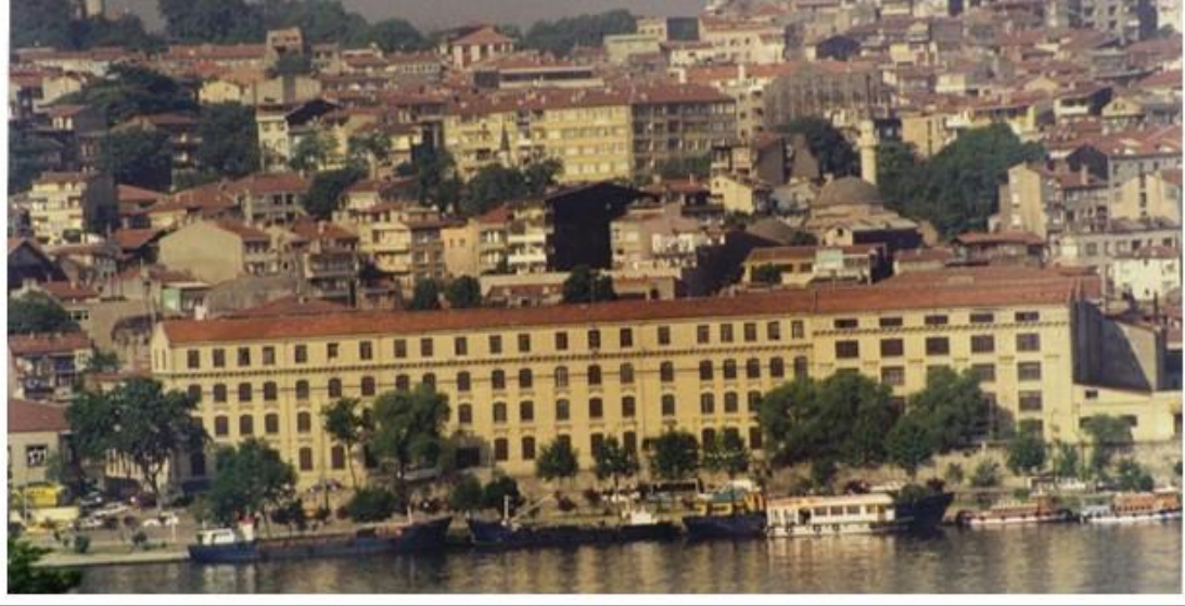
Şekil 4.13 Cibali Tütün ve Sigara Fabrikası, restorasyon çalışmaları öncesine ait görünüm, Haliç silueti (TURES arşivi)
