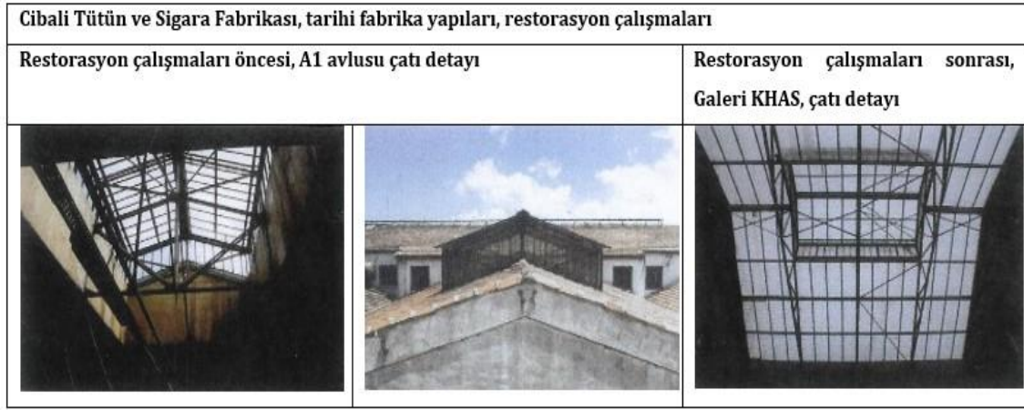
Şekil 4.90 Tarihi fabrika yapıları, rölöve projesi, A1 avlusu çatı onarım ve yenileme çalışmalarına ait görünüm (Alper, 2019)
