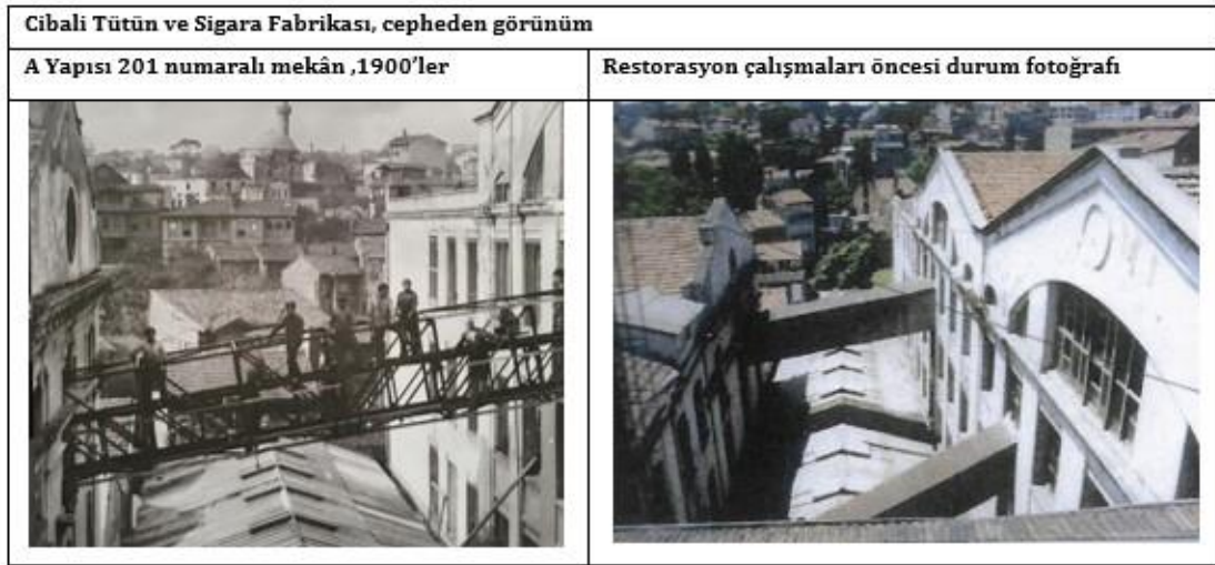
Şekil 5.10 Cibali Tütün ve Sigara fabrikası, A yapısı 201 numaralı mekân, cepheden görünüm (Alper, 2019 ve Yapı, 2021)
