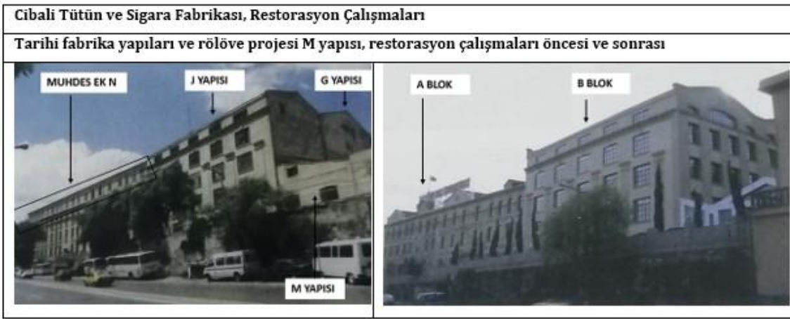
Şekil 4.102 Tarihi fabrika yapıları ve rölöve projesi M yapısı, restorasyon çalışmaları öncesi ve sonrası (Alper, 2019 üzerinden hazırlanmıştır.)
