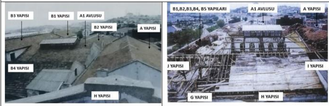
Şekil 4.86 Tarihi fabrika yapıları, çatı onarım ve yenileme çalışmalarına ait görünüm (Alper, 2019 üzerinden hazırlanmıştır.)
