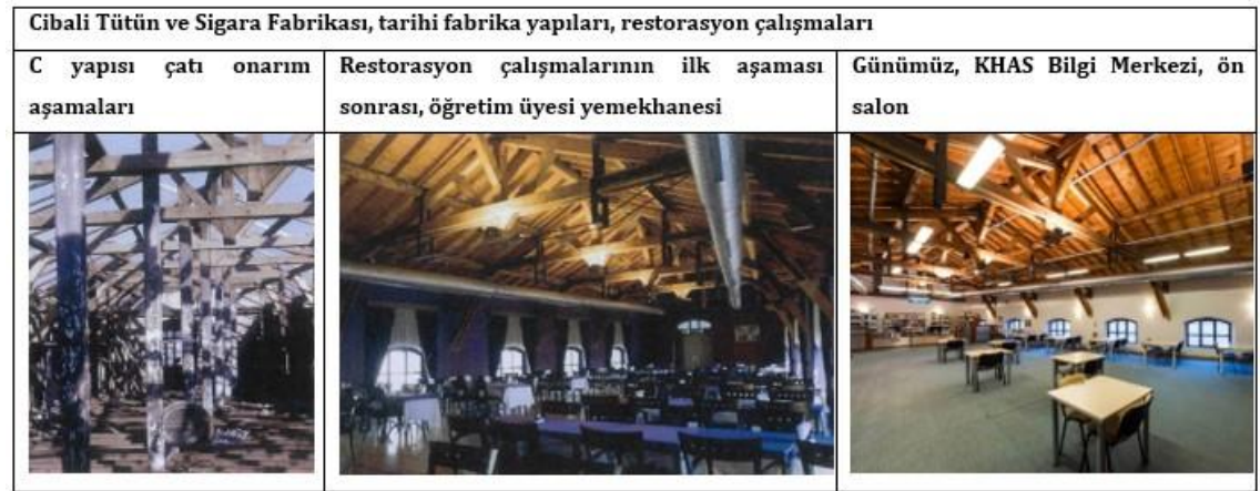
Şekil 4.89 Tarihi fabrika yapıları, rölöve projesi C yapısı çatı onarım ve yenileme çalışmalarına ait görünüm (Alper, 2019 ve Kadir Has Üniversitesi, 2021)
