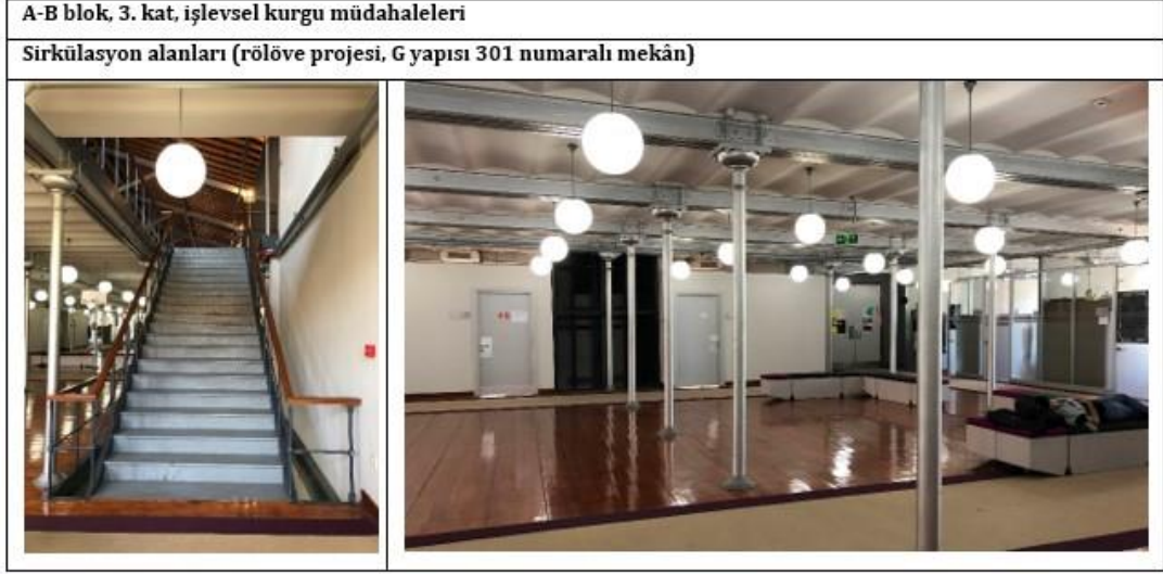
Şekil 4.142 A-B blok, 3. kat işlevsel kurguya yapılan müdahalelere ait görünüm (Didem Telli'nin arşivi)
