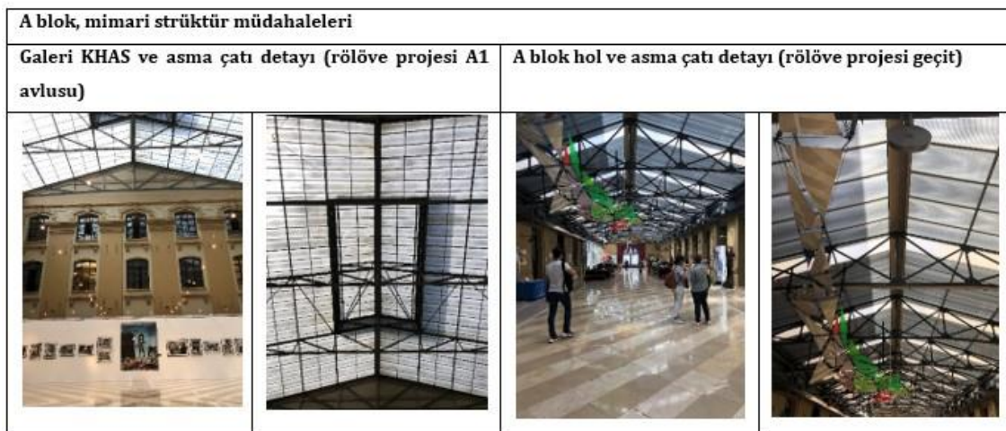
Şekil 4.79 Galeri KHAS ve A blok hole yapılan mimari strüktür müdahalelerine ait görünüm (Didem Telli'nin arşivi)
