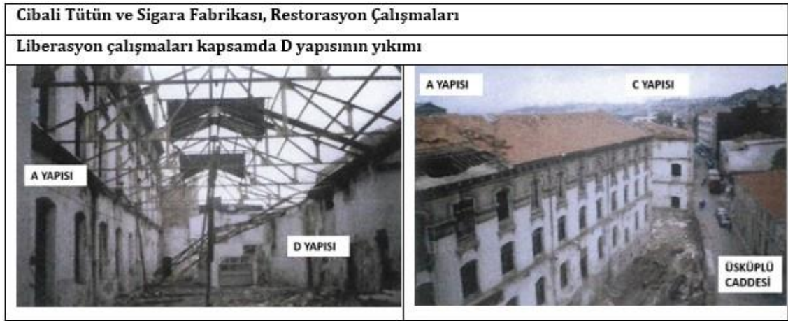
Şekil 4.97 Tarihi fabrika yapıları, liberasyon çalışmalarına ait görünüm (Alper, 2019 üzerinden hazırlanmıştır.)
