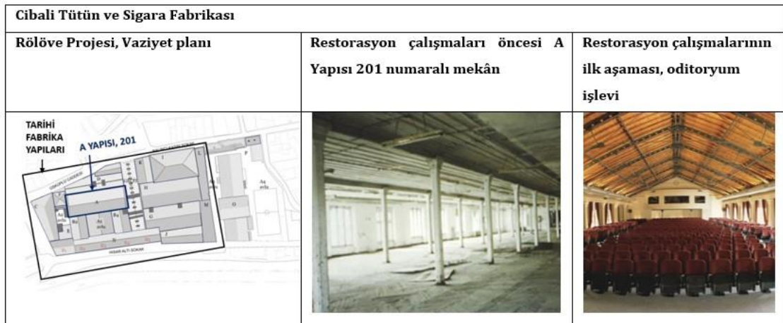
Şekil 5.7 Cibali Tütün ve Sigara fabrikası, A yapısı 201 numaralı mekân, restorasyon çalışmaları (Alper, 2019 üzerinden hazırlanmıştır.)
