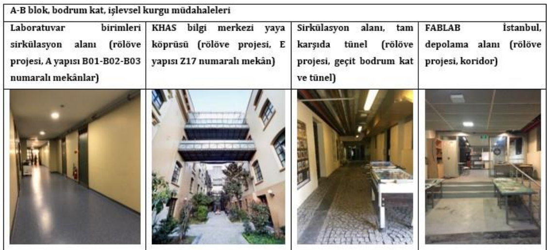
Şekil 4.133 A-B blok, bodrum kat işlevsel kurguya yapılan müdahalelere ait görünüm (Kadir Has Üniversitesi, 2021 ve Didem Telli'nin arşivi)
