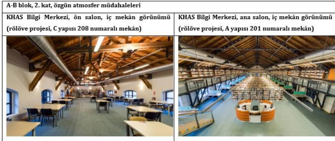
Şekil 4.161 A-B blok-2. kat, özgün atmosfere yapılan müdahalelere ait görünüm (Kadir Has Üniversitesi, 2021)
