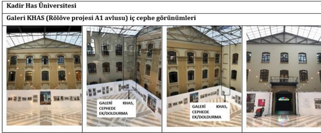
Şekil 4.122 Galeri KHAS (Rölöve projesi A1 avlusu) iç cephede mimari bezemelere müdahalelerin analizi (Didem Telli'nin arşivi üzerinden hazırlanmıştır.)
