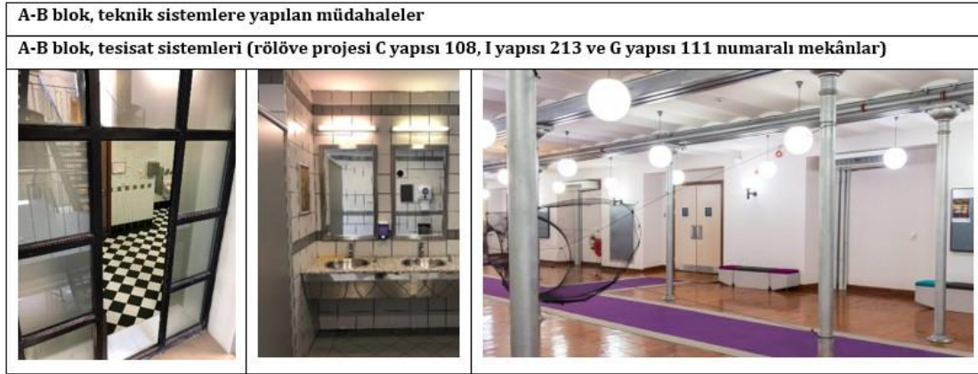
Şekil 4.131 A-B blok tesisat sistemleriyle ilgili yapılan müdahalelere ait görünüm (Didem Telli'nin arşivi)
