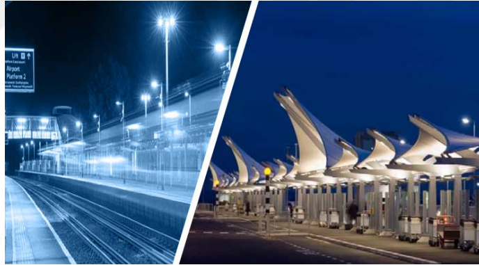
Şekil 3.17 Havalimanı toplu taşıma istasyonları aydınlatma örnekleri
