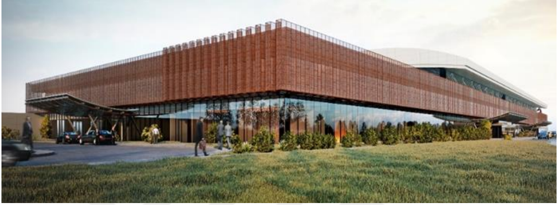
řekil 4.12 Alaatı Havalimanı giriř cephesi için gölgeleme sistemi önerisi [203]
