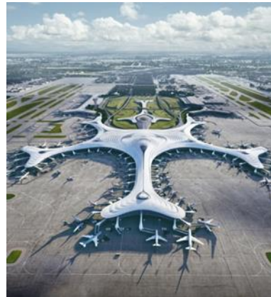
Şekil 3.47 Harbin Taiping Uluslararası Havalimanı [164].
