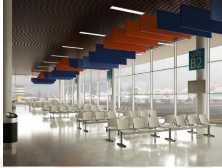
Şekil 3.57 Havalimanı terminalinde akustik tavan panelleri [179].
