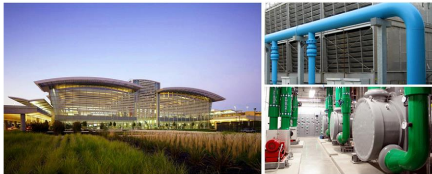
Şekil 3.27 Sacramento Uluslararası Havalimanı merkezi enerji santrali [108]
