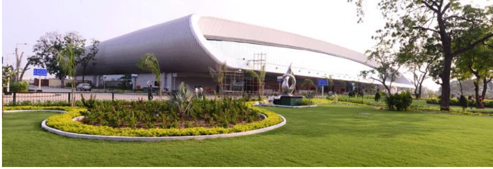
Şekil 3.42 Vodorada Uluslararası Havalimanı Terminali [158]
