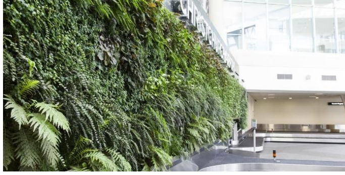
Şekil 3.52 Chiristchurch Havalimanı bagaj karusel alanı yeşil duvar uygulaması [168]
