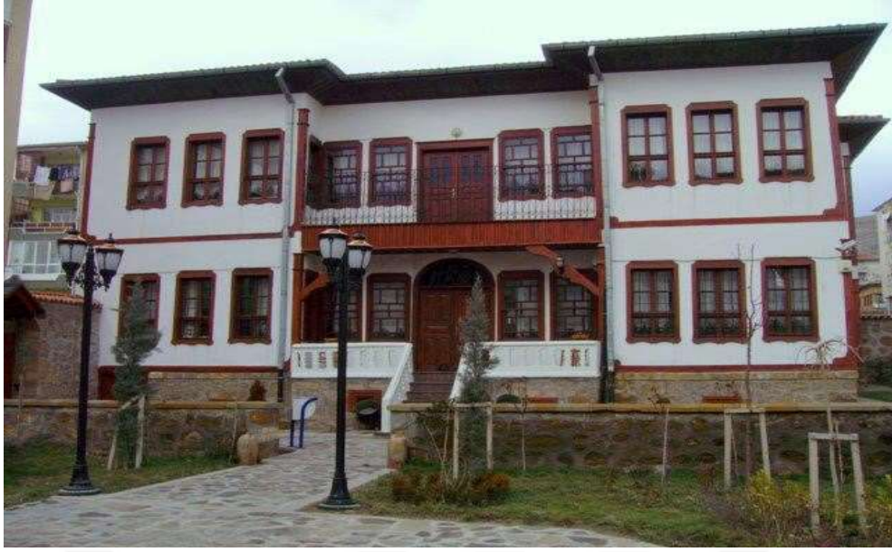
Şekil 3.93 Hayri İnal konağı genel görünüşü [88]
