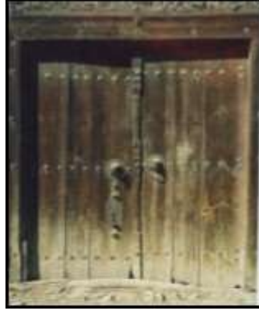
Şekil 2.34 Kayyumlar şehir evinin giriş kapısı [14]
