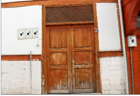
37.f- Giriş kapısı
