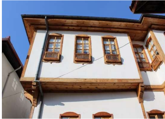
Şekil 6.8 Merkez İlçe katalog no:8'in konutun kıvrımlı ahşap payandaları
