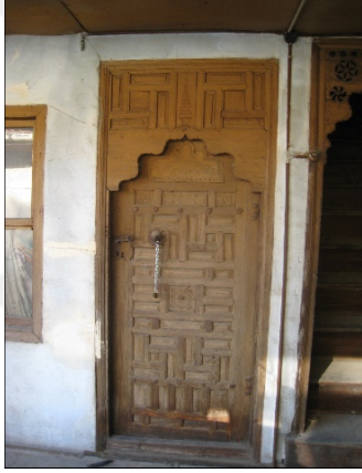
34.c- Kündekâri tekniğinde yapılan kapı
