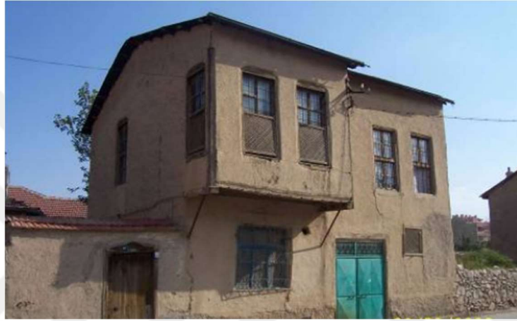
Şekil 2.17 Yediler Mahallesinde bir geleneksel konutta kerpicingin kullanım örneği [52]
