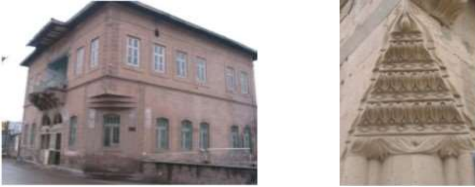
Şekil 3.6 Aksaray konutlarında köşe geçiş görünümleri [67]
