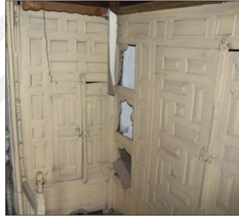
87.h- Künde-kârî tekniği ile yapılan dolaplar
