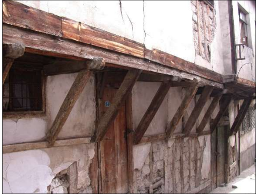
31.c- Üst katı destekleyen ahşap payandalar
