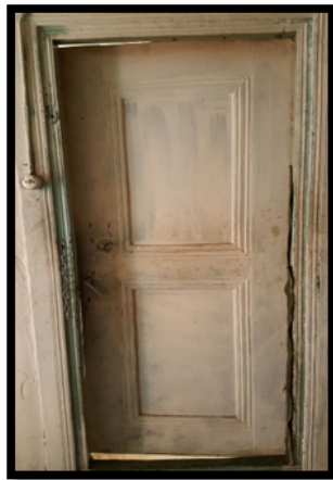
40.t- Oda kapısı görünüşü
