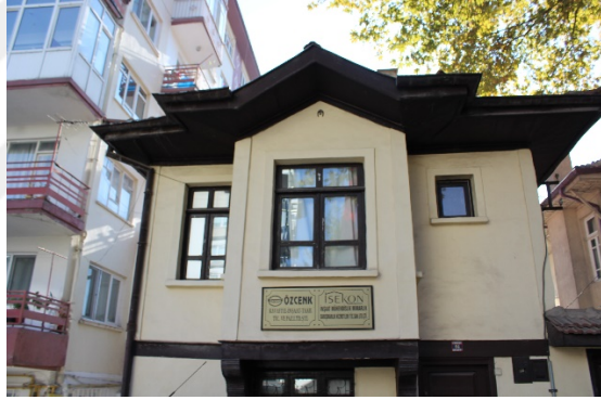
77.c- Pencerelerden görünüş
