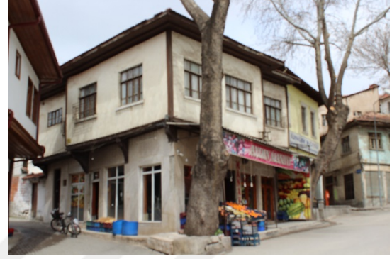
78.b- Üst katı destekleyen kıvrımlı ahşap payandalar
