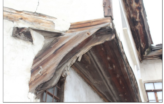
28.b- Üst katı destekleyen kıvrımlı ahşap payandaları
