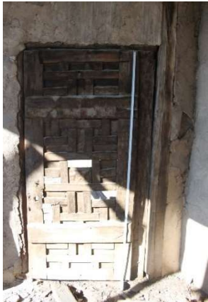
10.p- Künde-kâri tekniği ile yapılan giriş kapısı
