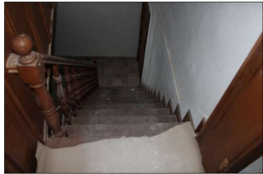
25.p- İç mekandaki merdivenlerden görünüş
