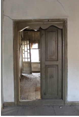
14.k- Çift kanatlı oda kapısı görünüşü
