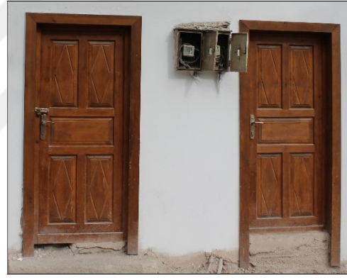
83.d- Dış kapılardan görünüş
