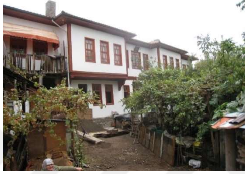
Şekil 5.17 Merkez İlçe katalog no:7'deki konuta bahçeden girilmesi
