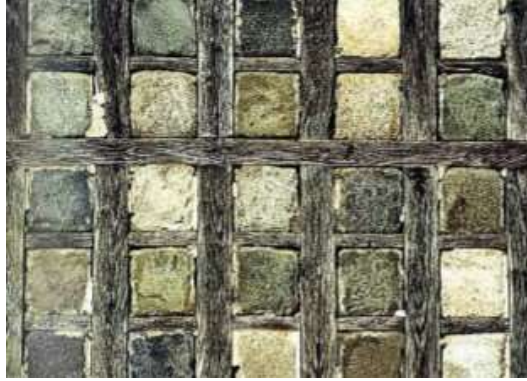
Şekil 2.39 Tek taş dolgu ve ahşap çatki sistemi [14]
