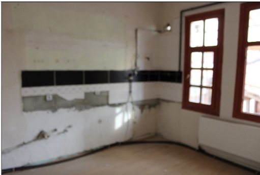
1.ö- Oda görünüşü
