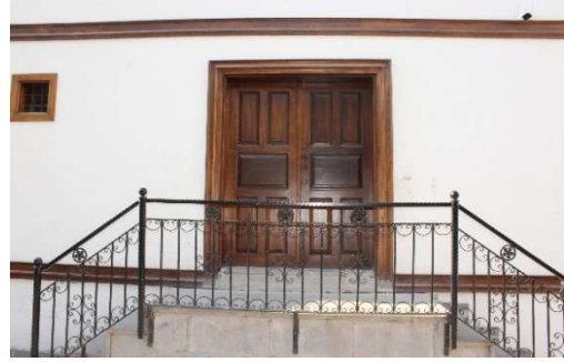
2.j- Giriş kapısının görünüşü
