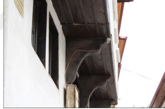
46.h- Üst katı destekleyen kıvrımlı ahşap payandalar
