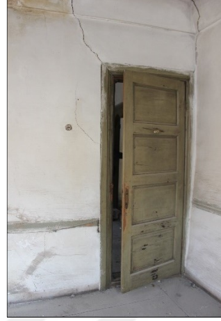
14.l- Tek kanatlı oda kapısı görünüşü
