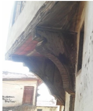
85.d- Üst katı destekleyen kıvrımlı ahşap payandalar
