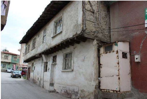
32.e- Köşe dikmelerden görünüş
