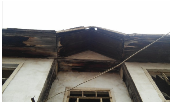
79.d- Saçak görünüşü
