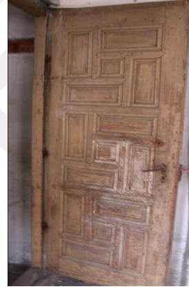
31.i- Künde-kârî tekniğinde yapılan kapı
