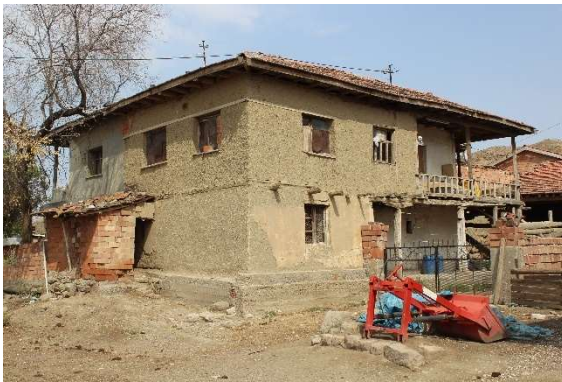
Şekil 6.27 Kızılırmak İlçesi Korçullu Köyü konutlarının ahşap çitasız saçakları
