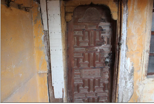
4.c- Kündekâri tekniğinde yapılmış giriş kapısı
