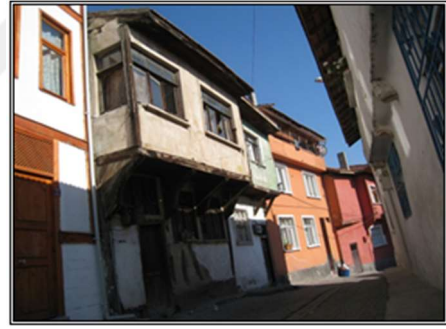
43.p- Restorasyondan önceki görünüşü
