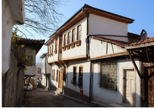
Şekil 5.16 Merkez İlçe katalog no:8'deki konuta sokaktan girilmesi
