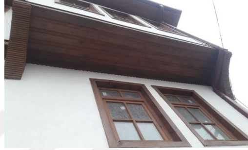
82.b- Çıkma altı görünüşü
