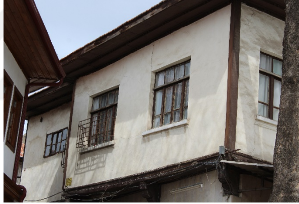
78.c- Köşe dikmelerden görünüş
