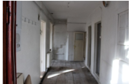
1.p- Duvar görünüşü
