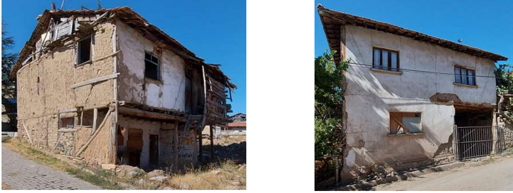
Şekil 5.69 Eldivan İlçesi konutlarının ahşap çatkı arası kerpiç dolgulu konutları
