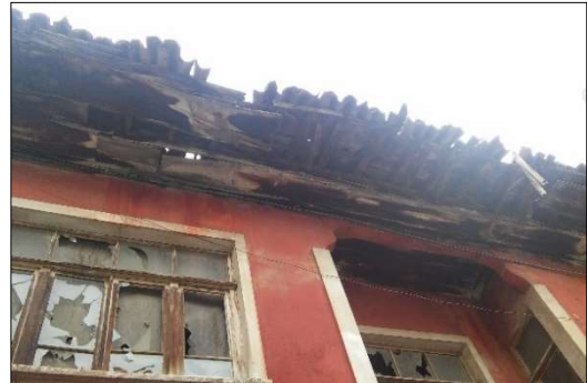
75.e- Ahşap çitasız kaplamasız saçaklar
