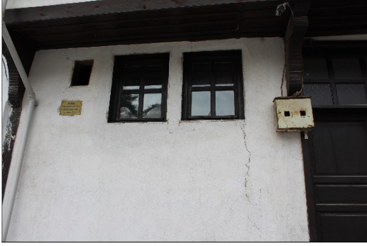
46.j- Pencerelerden görünüş
