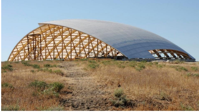
Şekil 3. 47 Çatalhöyük Kuzey Koruganı [168]
