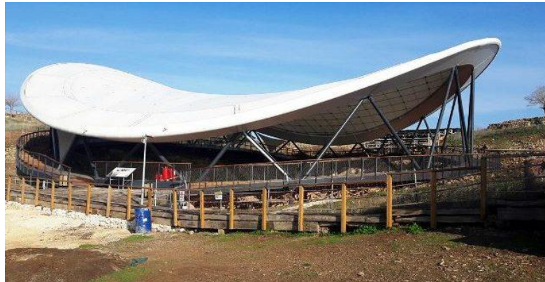
Şekil 3. 4 Göbeklitepe'nin koruyucu çatı sistemi [114]
