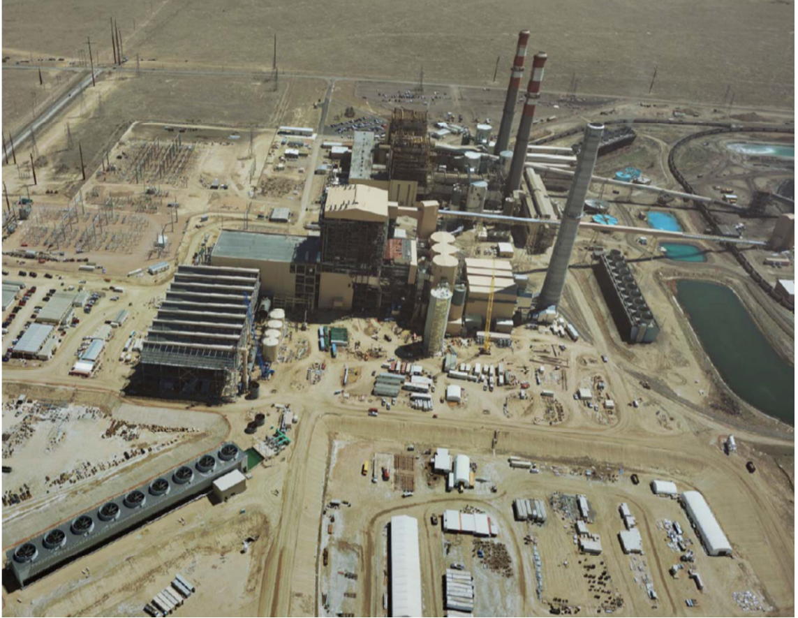
Şekil 3.10 Hibrit Soğutma Sistemli Comanche Santrali [8]
