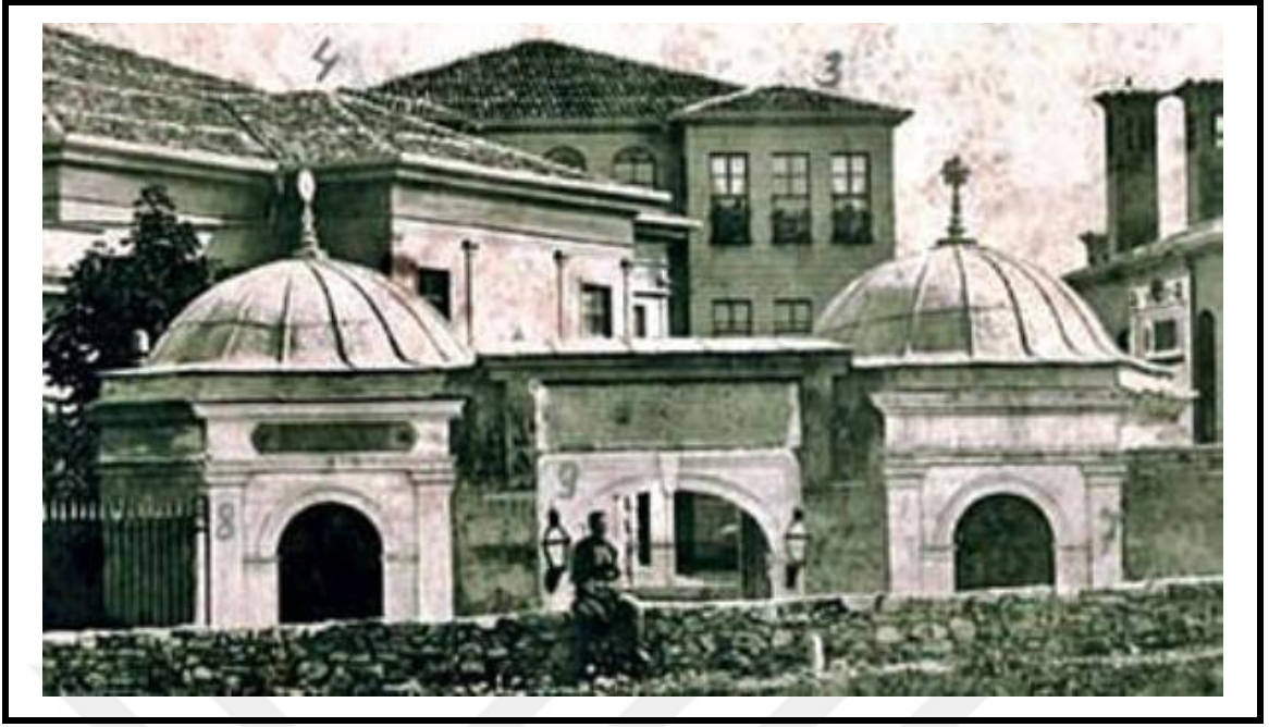
Şekil 3.101 Yenikapı Mevlevîhânesi muvakkithane–cümle kapısı-sebil grubu [110]
