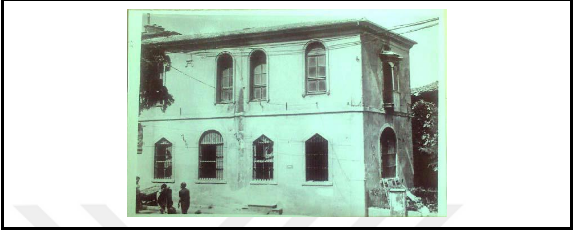
Şekil 3.222 Üsküdar Mevlevîhânesi Semahane-Türbe Binası Doğu Cephesi [127]
