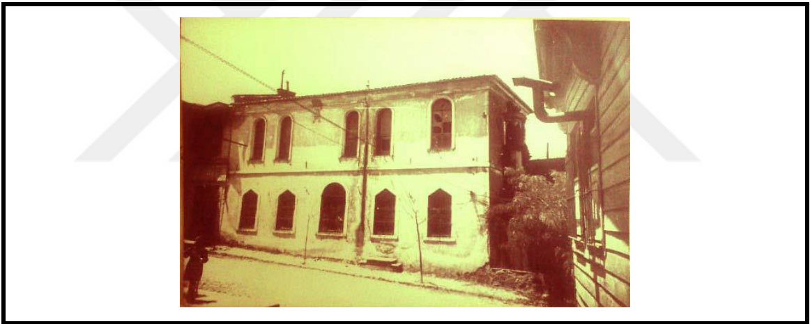
Şekil 3.223 Üsküdar Mevlevîhânesi Semahane-Türbe Binası Doğu Cephesi [114]
