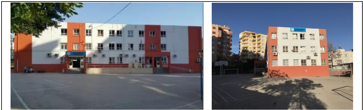
Şekil 5. 4 Ramazanoğlu Ortaokulu (RO)
