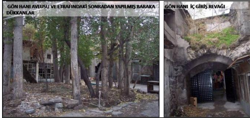
Şekil 3.41 Gön Hanı iç avlu ve iç avlu kısmından giriş revağı (Fernaz Öncel)
