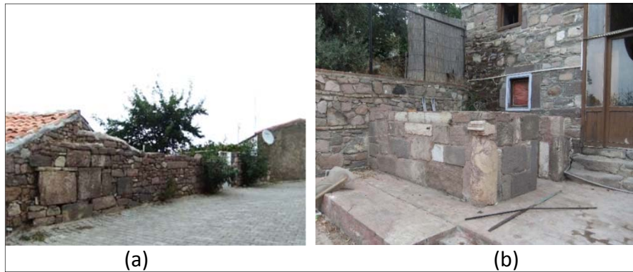
Şekil 3. 96 (a), (b) Ildırı geleneksel dokusunda devşirme malzeme kullanımı
