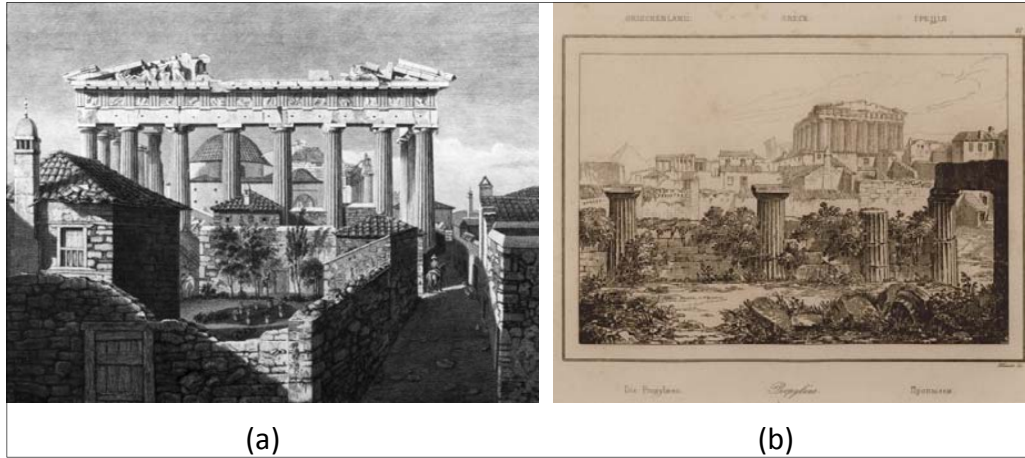
Şekil 2. 2 (a) Osmanlı evleri ve cami yıkılmadan önce Atina Akropolü [18]. (b) 19. yüzyılın ilk yarısında Parthenon ve çevresindeki Osmanlı yapıları [19].
