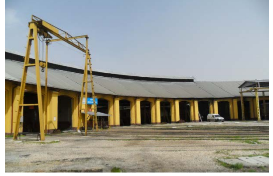
Şekil 5. 145 Lokomotif giriş cephesi, 3, 4, 5, 6, 7, 8, 9, 10, 11, 12, 13 nolu hattın bulunduğu bölümler
