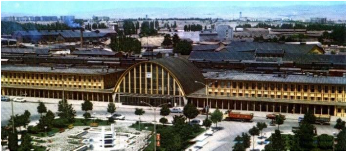
Şekil 5. 341 Eskişehir Garı Giriş Cephesi [169].
