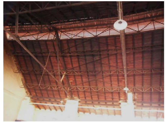
Şekil 5. 101 İç mekân, 10, 11, 12, 13 ve 14 nolu hattın bulunduğu bölüm, çift yönde eğimli kırma çatı ve aydınlık pencereleri
