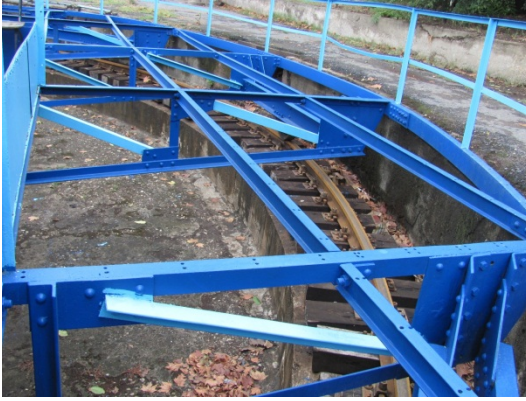
Şekil 5. 33 Krupp marka dönerköprü, beton çukur duvarı, döner köprü döndürme ünitesi, taşıyıcı kirişler
