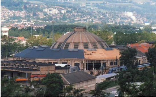
Şekil 4. 50 Chambéry Dairesel Planlı Lokomotif Deposu, çatı onarımı [89].
