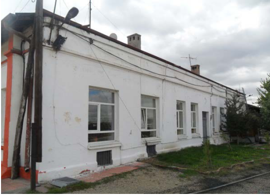
Şekil 5. 285 Yan cephe, ofis bölümü, PVC olarak imal edilmiş yeni pencereler
