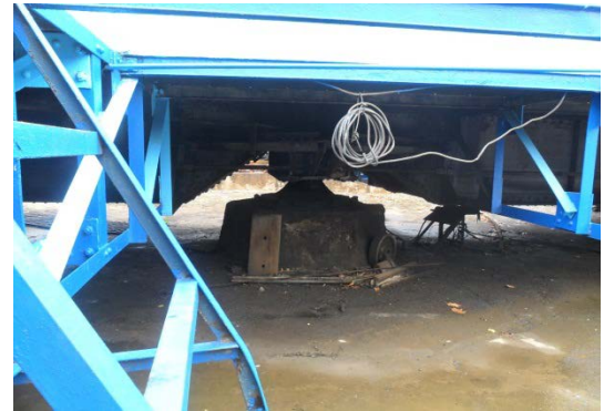
Şekil 5. 36 Krupp marka dönerköprü, beton çukur duvarı merkezindeki destek ünitesi, taşıyıcı kirişler
