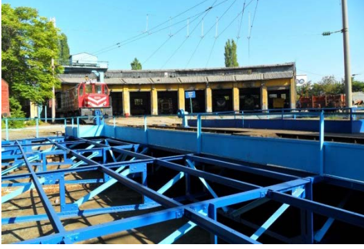
Şekil 5. 31 Krupp marka dönerköprü, lokomotifin taşındığı raylar ve taşıyıcı kirişler
