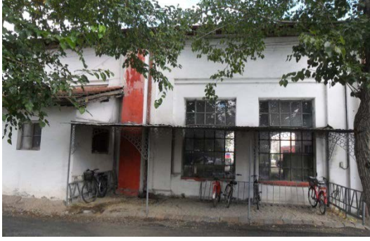
Şekil 5. 295 Arka cephe, 8 ve 9 nolu hattın bulunduğu bölüm, 9 nolu hattın bulunduğu bölümde orijinal pencereler, sonradan imal edilmiş gölgelik ve 8 nolu hattın arka cephesindeki ek
