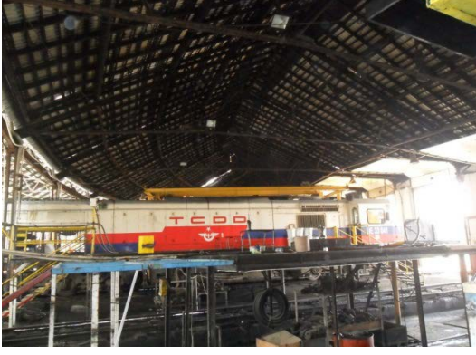
Şekil 5. 174 İç mekân, ana mekânın çatısı
