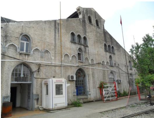
Şekil 5. 218 Yan cephe, 1 nolu hattın bulunduğu bölüm
