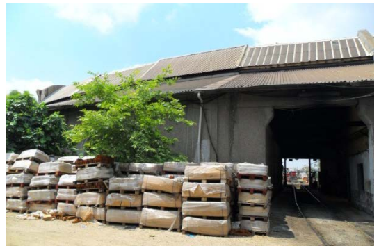
Şekil 5. 213 Arka cephe, 3, 4 nolu hattın bulunduğu bölüm
