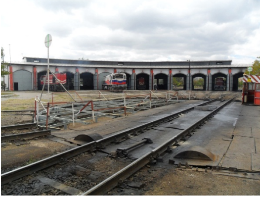
Şekil 5. 277 Ön cephe, 1 - 12 nolu hattın bulunduğu bölüm, lokomotif giriş – çıkış kapıları, ana mekânın çatısı ve çatı aydınlığı, dönerköprü
