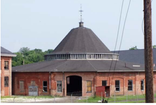
Şekil 4. 68 Martinsburg Dairesel Planlı Lokomotif Deposu. Restorasyon öncesi [93].
