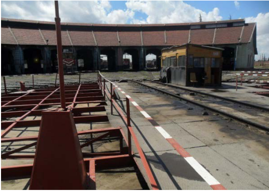
Şekil 5. 70 Lokomotif Giriş Cephesi ve dönerköprü
