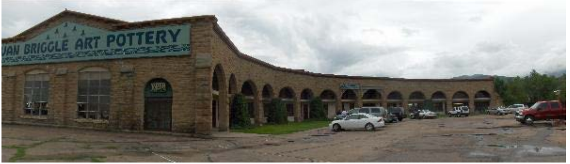
Şekil 4. 73 Midland Terminal Dairesel Planlı Lokomotif Deposu [95].
