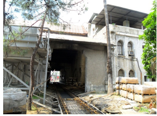
Şekil 5. 215 Arka cephe, 1, 2 nolu hattın bulunduğu bölüm
