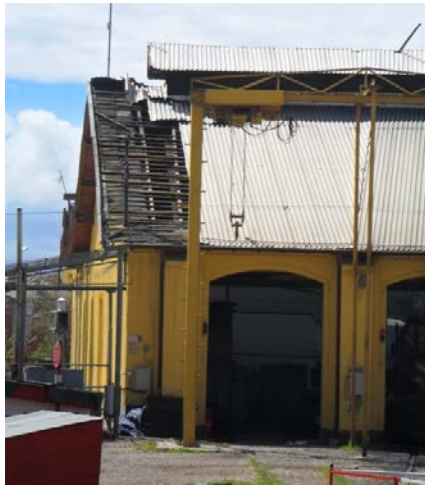
Şekil 5. 160 Giriş Cephesi, 13, 14, nolu hattın bulunduğu bölüm, çatı kaplama malzemesindeki kayıplar, çatı aydınlığı
