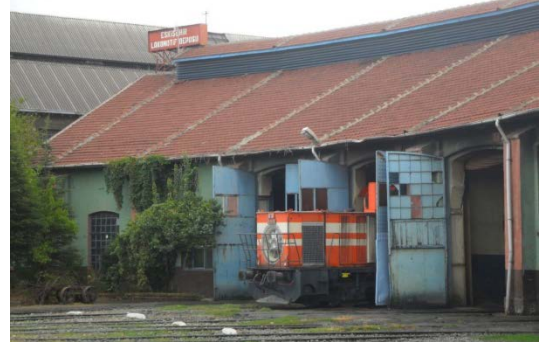
Şekil 5. 67 Lokomotif Giriş Cephesi, 13, 14, 15, nolu hatların kapıları ve çatı aydınlığı, 16, 17, nolu hatların pencereleri
