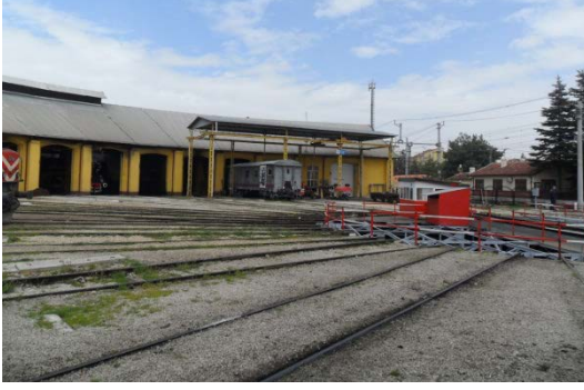
Şekil 5. 156 Lokomotif Giriş Cephesi, 1, 2, 3, 4, 5, 6, 7 nolu hattın bulunduğu bölümler, dönerköprü
