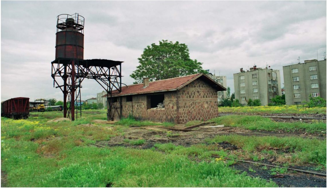
Şekil 5. 274 Kayseri İstasyonu'ndaki dairesel planlı lokomotif deposu arka bölümünde yer alan, bugün mevcut olmayan kum yükleme tesisatı [160].
