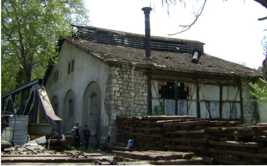
Şekil 3. 19 Lokomotif deposu yığma duvar detayı [58].
