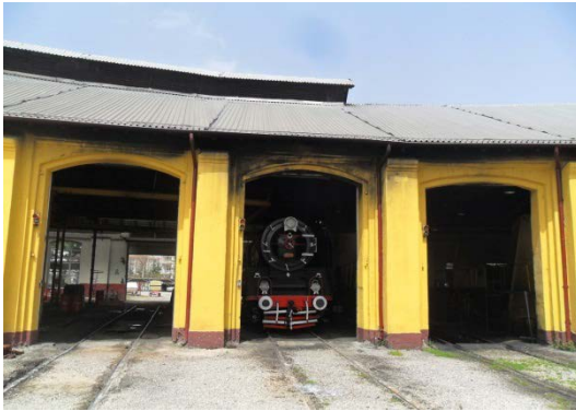
Şekil 5. 154 Lokomotif Giriş Cephesi, 5, 6, 7 nolu hattın bulunduğu bölümler
