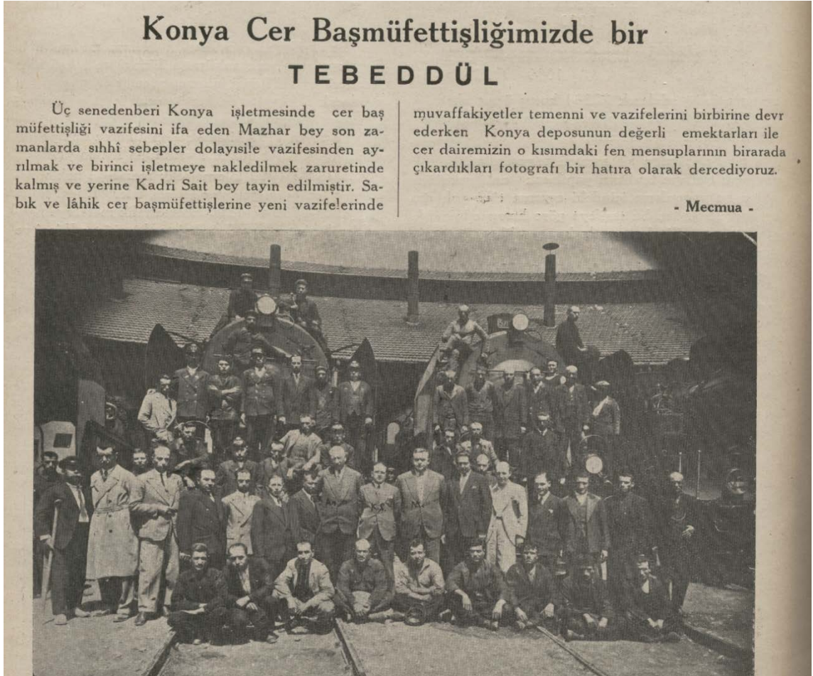
Şekil 5. 125 Konya İstasyonu'ndaki dairesel planlı lokomotif deposu [137].
