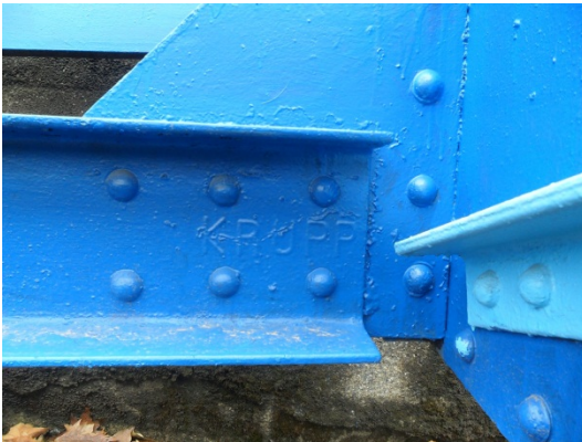
Şekil 5. 35 Krupp marka dönerköprü, taşıyıcı kirişler üzerindeki üretici firma ismi
