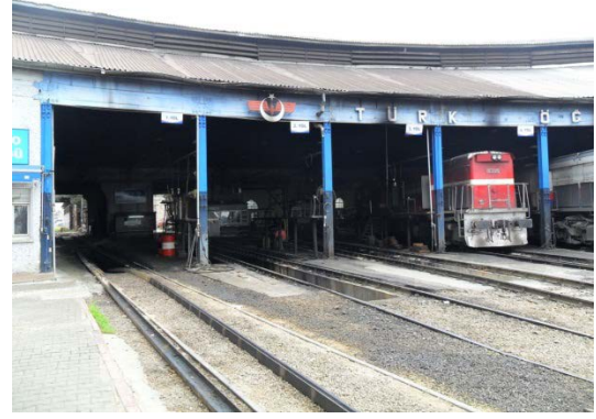
Şekil 5.224 Ön cephe, 1 ve 2, 3, 4, 5 nolu hattın bulunduğu bölüm
