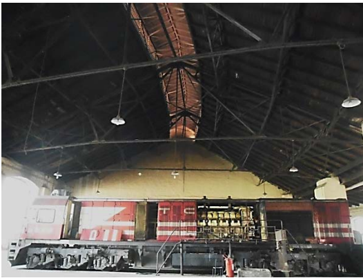
Şekil 5. 100 İç mekân, 10, 11, 12, 13 ve 14 nolu hattın bulunduğu bölüm, çift yönde eğimli kırma çatı ve aydınlık pencereleri
