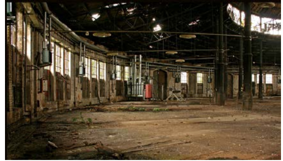
Şekil 4. 84 Düsseldorf Dairesel Planlı Lokomotif Deposu. Restorasyon öncesi [103].
