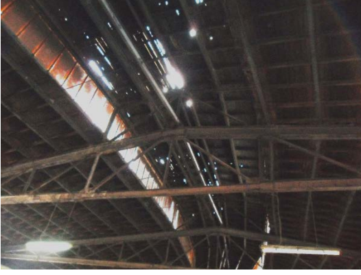
Şekil 5. 307 İç mekân, çatı ve çatı aydınlığı detaylar
