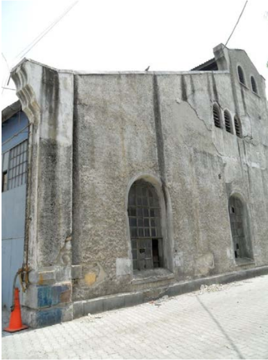
Şekil 5. 231 Yan cephe, 15 nolu hattın bulunduğu bölüm
