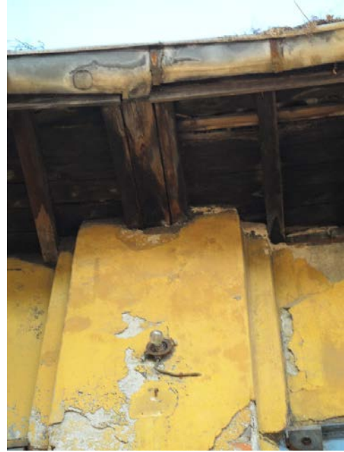
Şekil 5. 20 Ön cephe, kapı açıklıkları aralarındaki taşıyıcı kolonlar üst ölüm, saçak detayı
