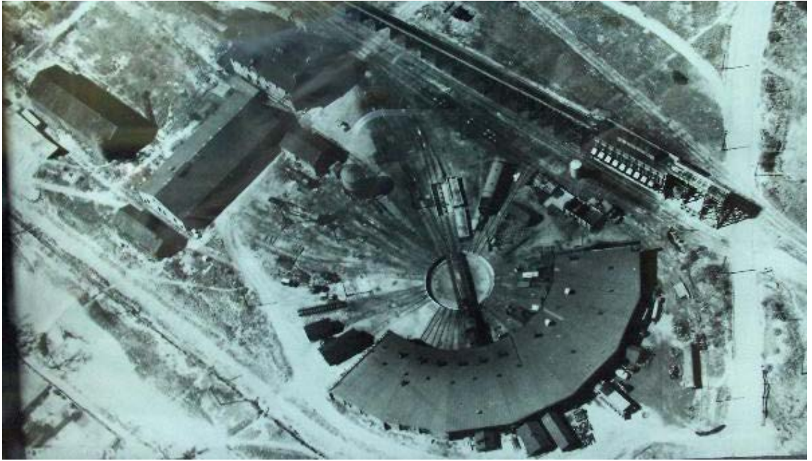
Şekil 4. 74 Midland Terminal Dairesel Planlı Lokomotif Deposu [95].
