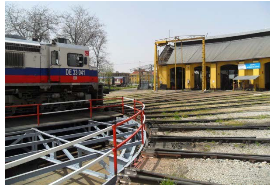
Şekil 5. 149 Lokomotif Giriş Cephesi, 1, 2, 3, 4, 5, 6, 7, 8, 9, 10, 11, 12, 13, 14 nolu hattın bulunduğu bölümler
