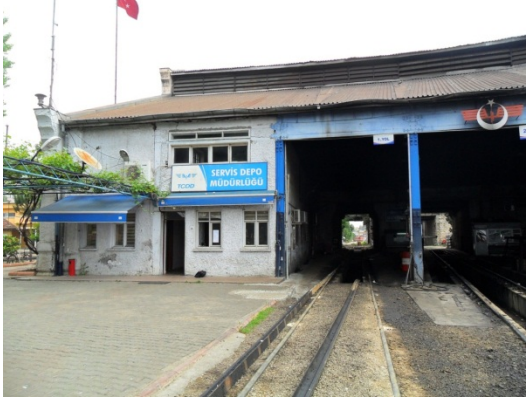
Şekil 5. 223 Ön cephe, 1 ve 2 nolu hattın bulunduğu bölüm
