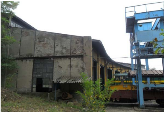
Şekil 5. 29 Ön ve yan cephe, 5, 6, 7, 8, 9 nolu hatların bulunduğu bölümler, kapı açıklıkları, metal iskelet - tuğla duvar örgüsü şeklinde imal edilmiş duvar
