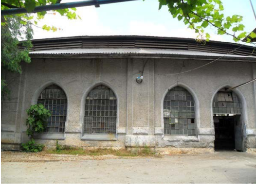
Şekil 5. 238 Adana Dairesel Planlı Lokomotif Deposu arka cephesi
