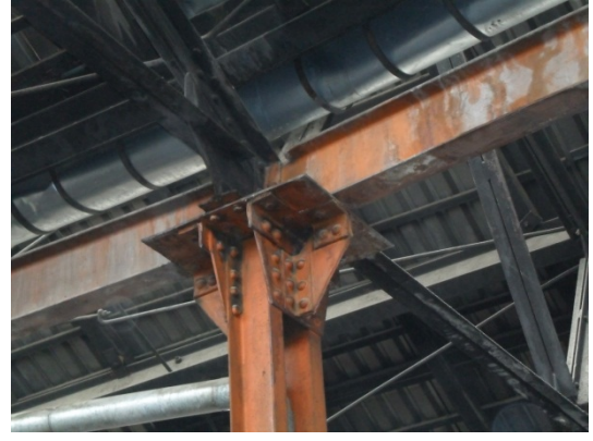
Şekil 5. 189 İç mekân, 12, 13 ve 14 nolu hatların bulunduğu bölüm, çatılara ait konstrüksiyon ve birleşme detayları
