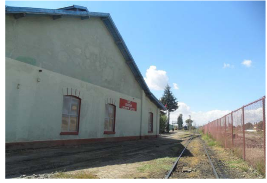
Şekil 5. 71 Yan Cephe, deponun ana mekânını örten ana çatı ve arka cephedeki ikincil mekân ve bu mekânı örten ikincil çatı, değiştirilmiş pencereler.
