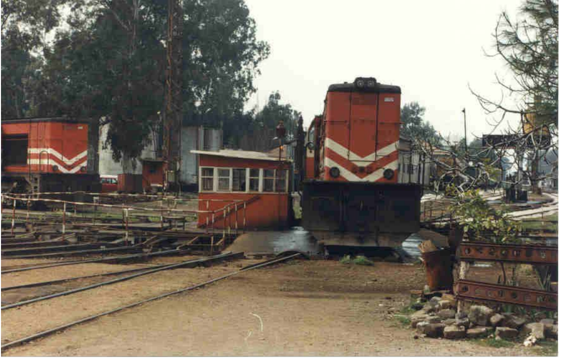
Şekil 5. 204 Adana İstasyonu'ndaki dairesel planlı lokomotif deposu dönerköprüsü [152].
