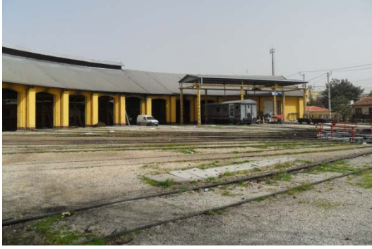
Şekil 5. 146 Lokomotif giriş cephesi, 1, 2, 3, 4, 5, 6, 7, 8, 9, 10 nolu hattın bulunduğu bölümler
