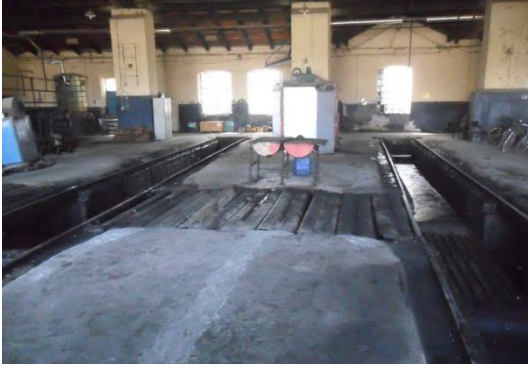
Şekil 5. 102 İç mekân, 11, 12, nolu hattın bulunduğu bölüm, lokomotif bakım çukurları
