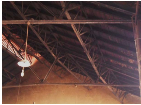
Şekil 5. 107 Çatı ve aydınlık pencerelerinin detayları
