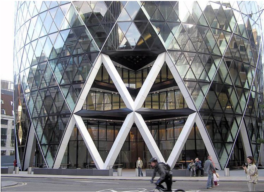
Şekil 3. 7 Swiss-Re merkez ofis binası, Londra[87]
