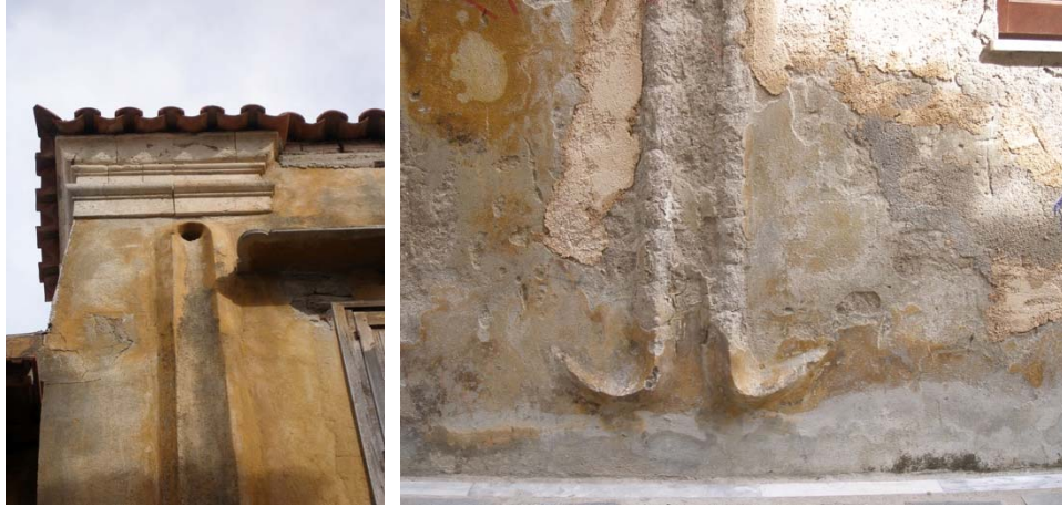
Şekil 2.22 Yerel mimaride görülen yağmur oluğu detayı (2013)
