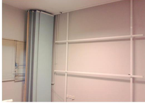
Şekil 4.8 Üzeri boyalı panellerin görünüşü
