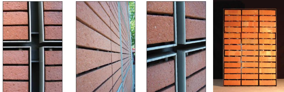
Şekil 5.3 Tuğlanın mekanik bağlantılarla bir araya getirilme uygulaması [177]
