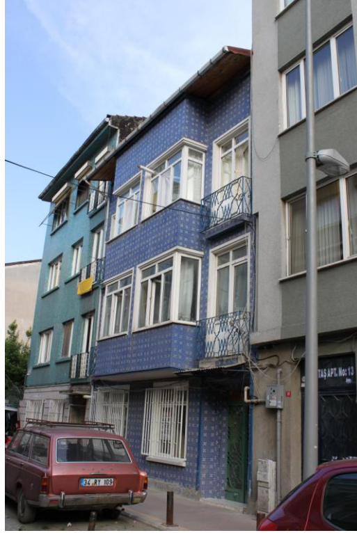
Şekil 5.3 Cephe kaplaması değiştirilmiş kat apartmanı
