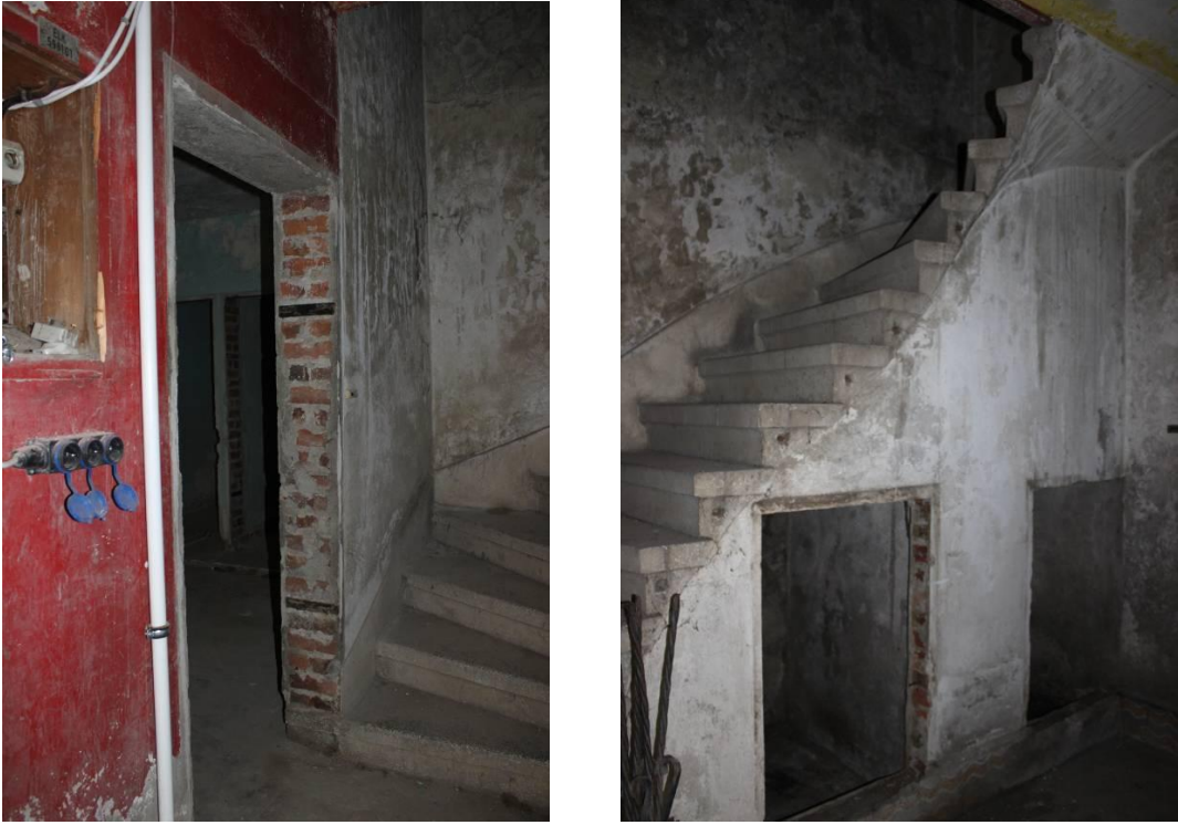
Şekil 3.47 Kat apartmanlarında yağma duvar ve merdiven kesitleri
