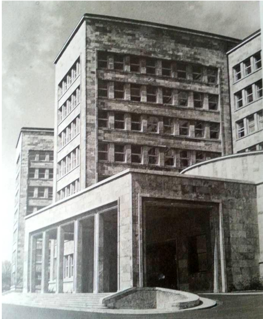
Şekil 3.11 AG Yönetim Binası, Hans Poelzig, Frankfurt, 1931 [102].
