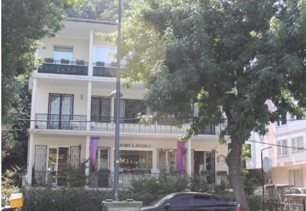
Şekil 3.44 Taşıyıcı sistemin cepheye yansıdığı örnekler
