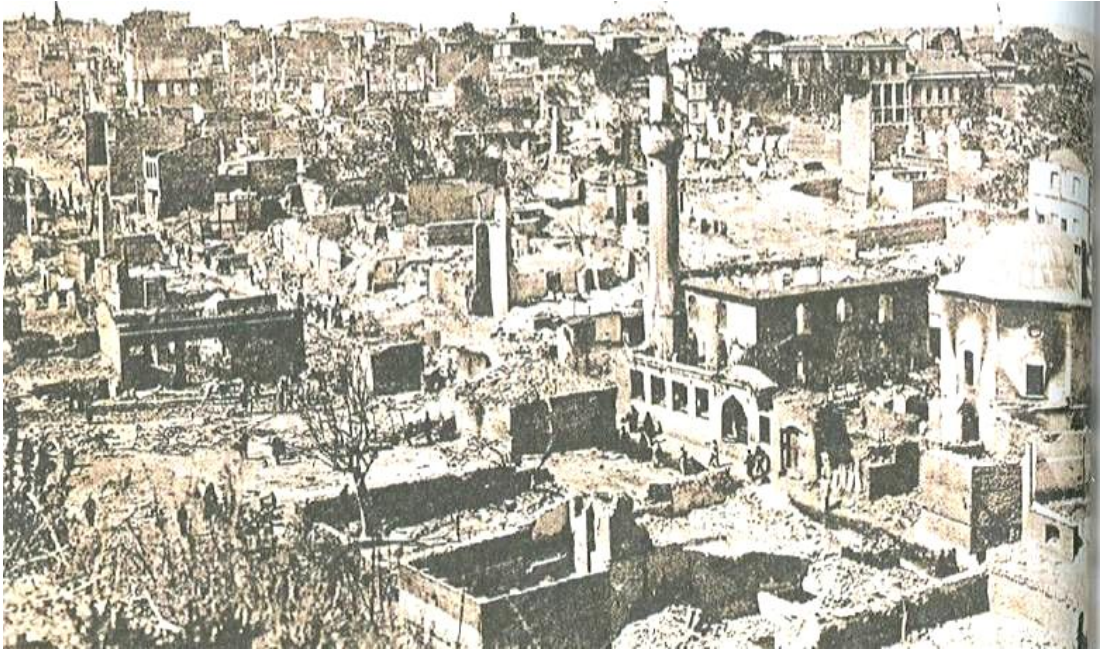
Şekil 2.5 1908 yılında Saraçhane yangınının yarattığı hasar [47].
