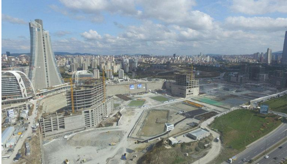
Şekil 3.22 İstanbul Finans Merkezi inşaatı
