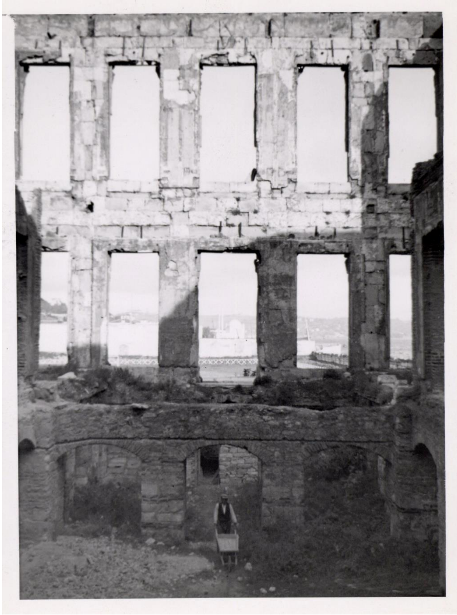
Ek 10: ıraęan Sarayı'nın duvar enkazı.
