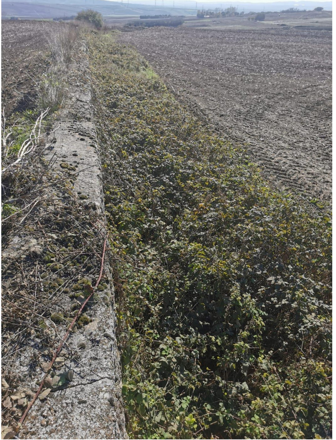
Şekil 19: Çatalca bölgesinde bulunan betonla duvarla desteklenmiş hendek
