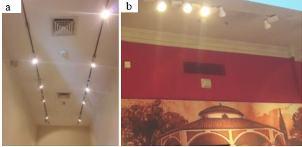
Resim 30: Koşullandırılmış havanın sergi salonlarına servis edildiği hava kanalları
