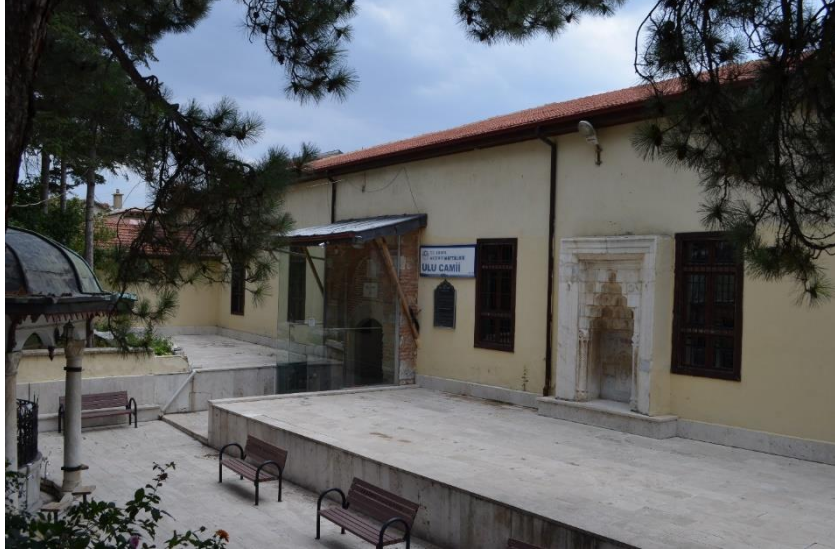
Ek-2. Fotoğraf 15. Akşehir Ulu Camiinden Bir Görünüş
