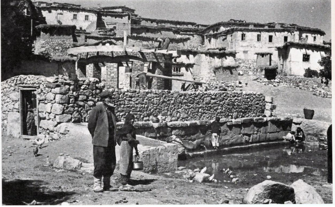
Şekil 3: Hasanoğlan Köyündeki Çeşmenin Hasanoğlan Köy Enstitülü Öğrenciler Tarafından Yapılmadan Önceki Hali
