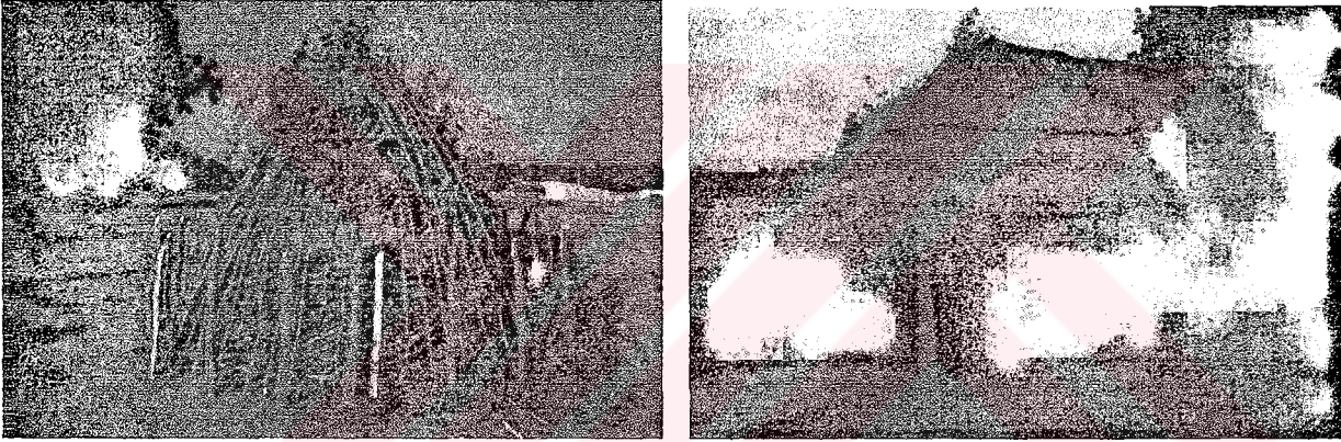
Resim 3.2.4.1.3 Aşağı Pınar Höyüğü yapılarının yapım şekli, çitin yapılması ve yapının üzerine çavdar saplarının yerleştirilmesi (Aşağı Pınar Höyüğü Kazı Arşivi).
