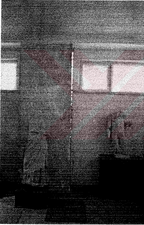
Resim 3.2.2.2.1–1: Edirne Müzesi Arkeoloji Salonu / Duvar-Kolon Birleşimlerinde Ayrılmalar Olmuştur (Haziran 2001)
