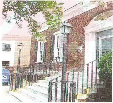
Resim 2 : Girişine rampa konmuş belediye binası
