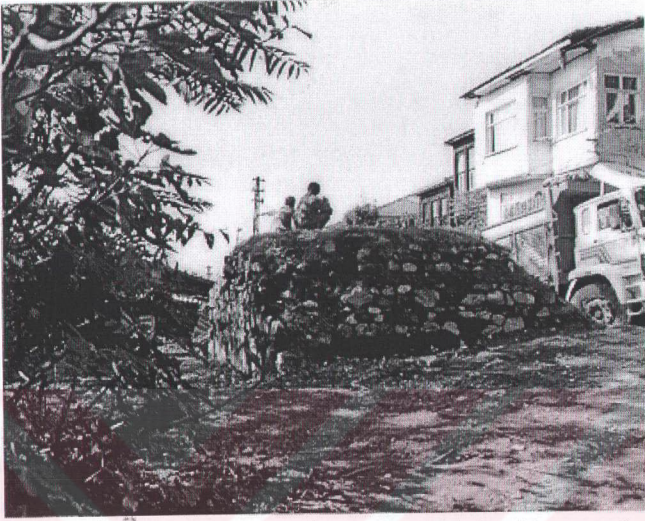
Resim 43. Kapanca sokak, 62 pafta, 190 ada, 13 parsel Sarnıç
