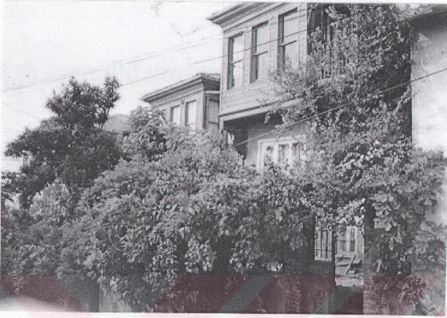
Resim 57. Kapanca Sokak, 62 pafta, 189 ada, 16-15 parseller, restorasyon sırasında
