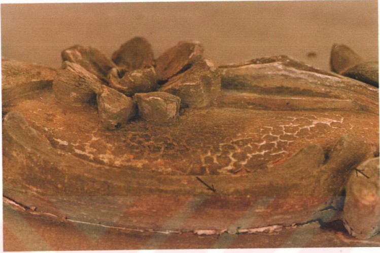
Şekil 20. III. Ahmed Çeşmesi ahşap saçaklarının renk değişikliği bulunan (ok) kısımlarından ayrıntı
