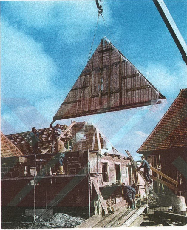
RESİM 3: Yapı nakil işlemi
