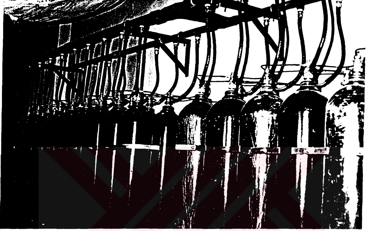
ŞEKİL 30 Otomatik Yangın Söndürme Cihazları
