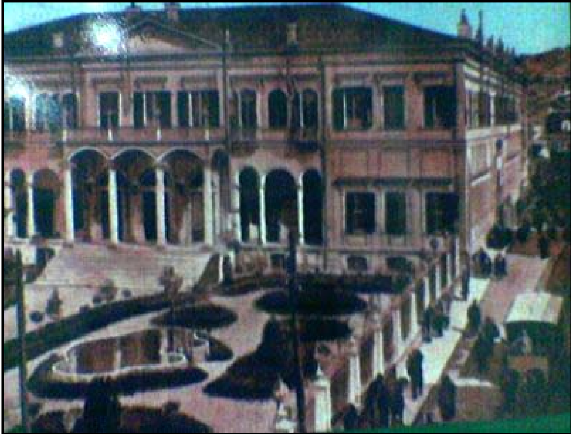
Şekil 4.6.5: Hükümet Konağı Bahçesi, (Atay, Ç. 1997)
