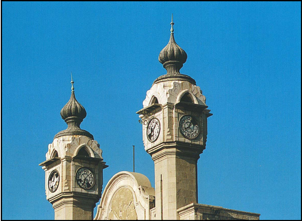
Şekil 4.1.10: Haydarpaşa Mekteb-i Şahane Binası Saat Kulesi, (Özdemir, K. 1993)
