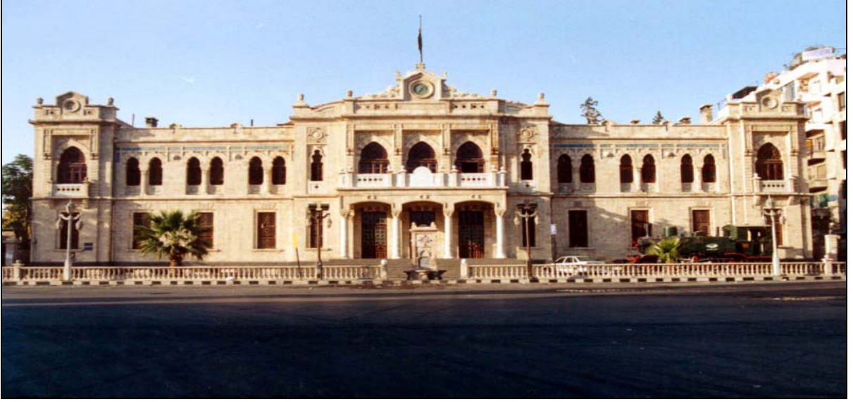
Şekil 3.3.3.3: Şam'daki Hicaz Demiryolu İstasyon Binası, ( http://nabataea.net/hejaz1.html )
