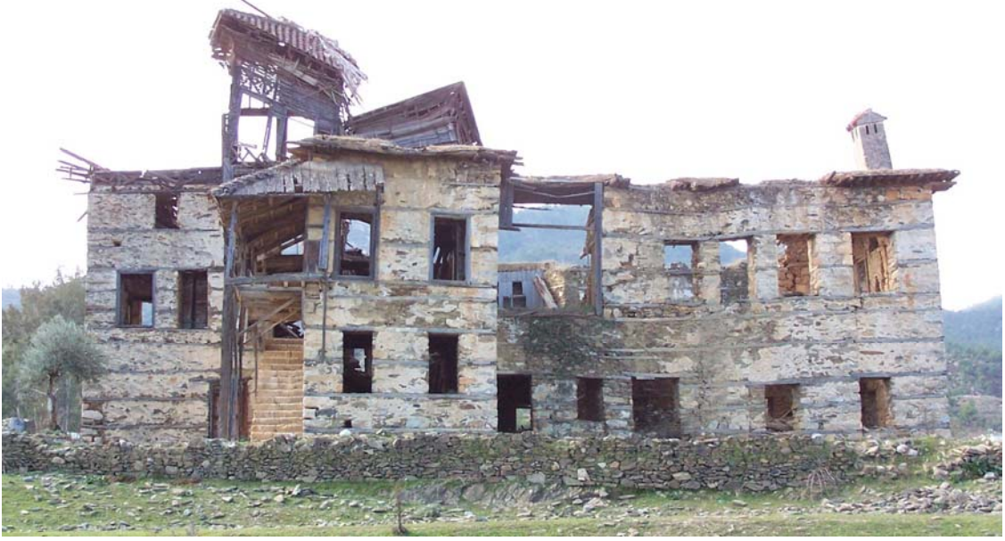
Resim 20.13. Doğu Cephesi (Ocak 2007)
