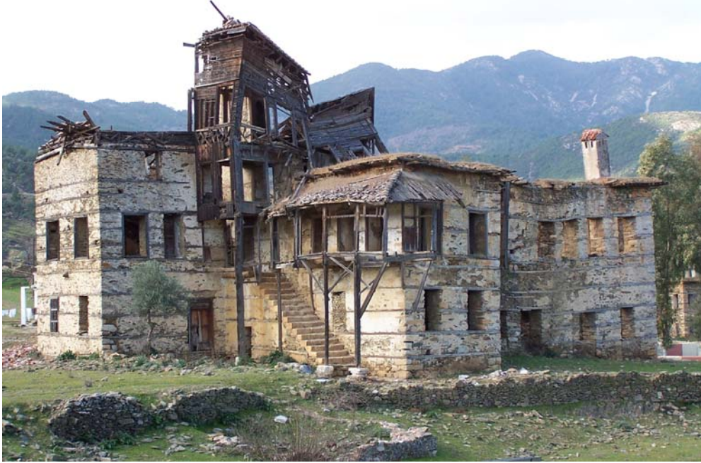
Resim 20.12. Güneydoğu Cephesi (Ocak 2007)
