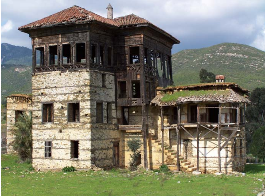
Resim 20.2. Güneydoğu Cephesi (Şubat 2004)
