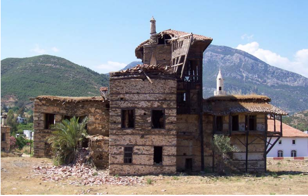
Resim 20.7. Güney Cephesi (Mayıs 2006)
