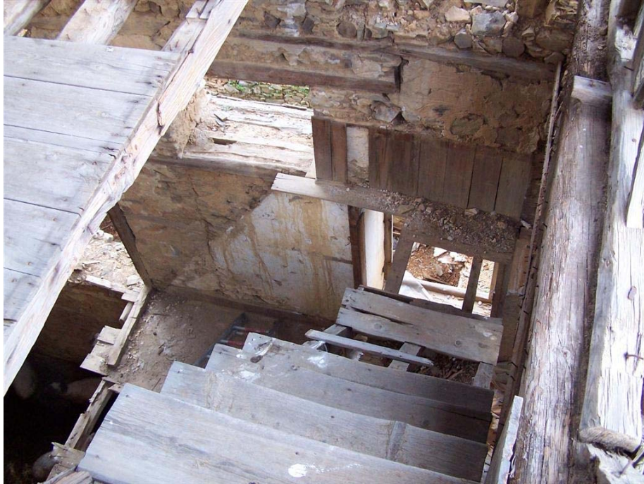
Resim 22.4. Ara Katta Yer Alan Merdiven Görünüşü
