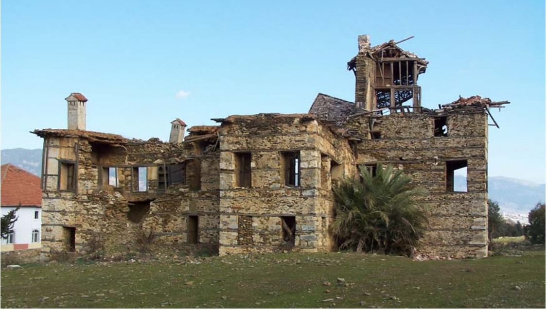
Resim 20.15. Batı Cephesi (Ocak 2007)
