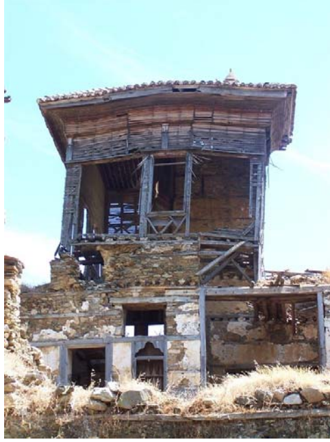
Resim 23.3. Köşk Katı Kuzey Bölümü, Ahşap-Taş Birleşimi
