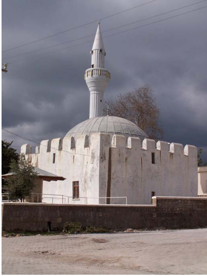
Şekil 3.2 Akcamî Güneydoğu Görünüşü (2006)
