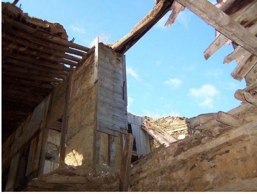
Resim 22.3. 102 nolu odanın yıkılmış toprak damı ve K14 nolu kapı
