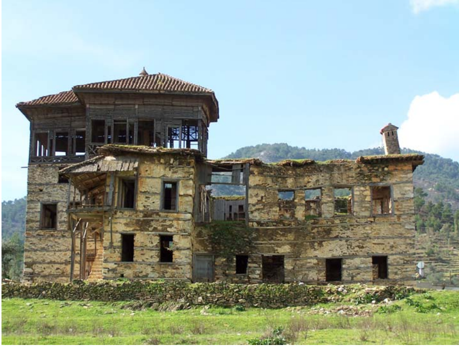
Resim 20.3. Doğu Cephesi (Şubat 2004)
