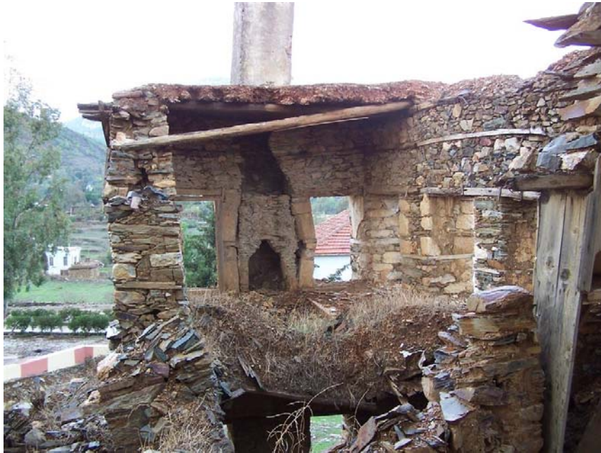
Resim 22.2. 106 nolu Odanın Batı Duvarı ve Girişi
