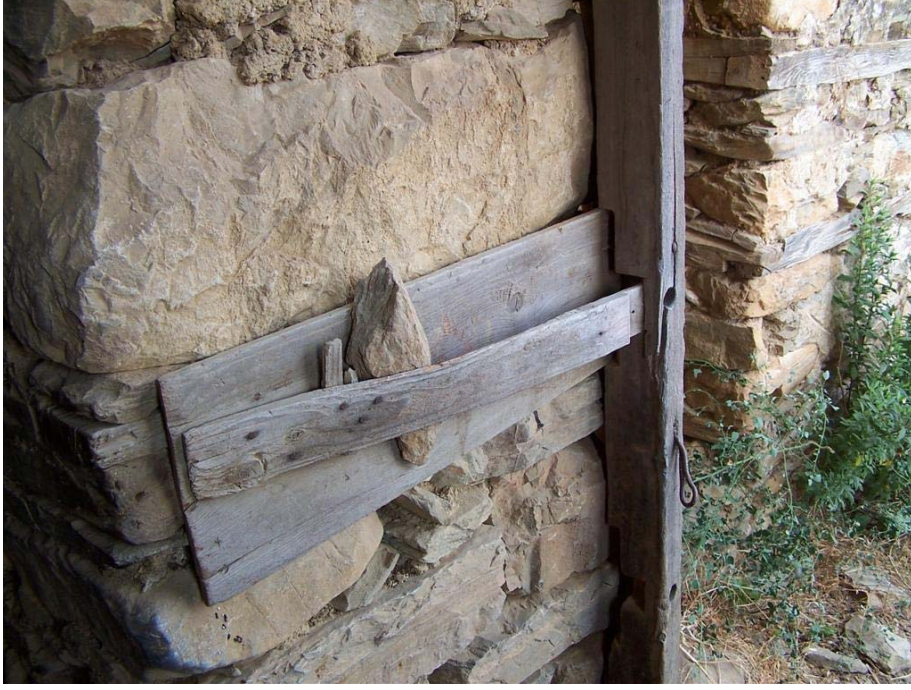
Resim 23.5. Tokmaklı (Kösüklü) Kapı Sistemi
