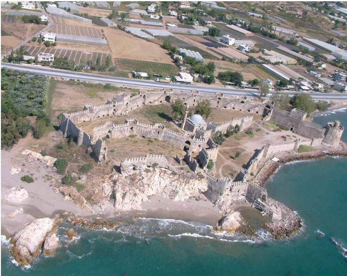
Şekil 2.9 Mamure Kalesi Havadan Görünümü (2006)
