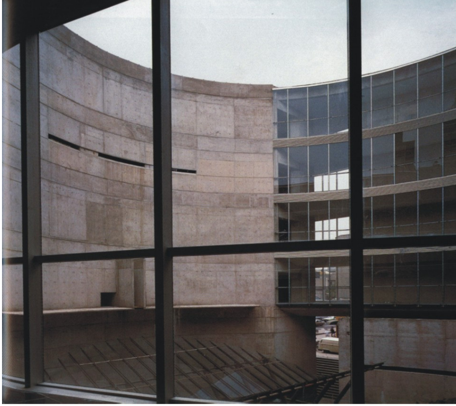
Şekil 4.40 Metro İstasyonu ve Kent Binası, Mexico City, Meksika, Kalach+Alvarez.
