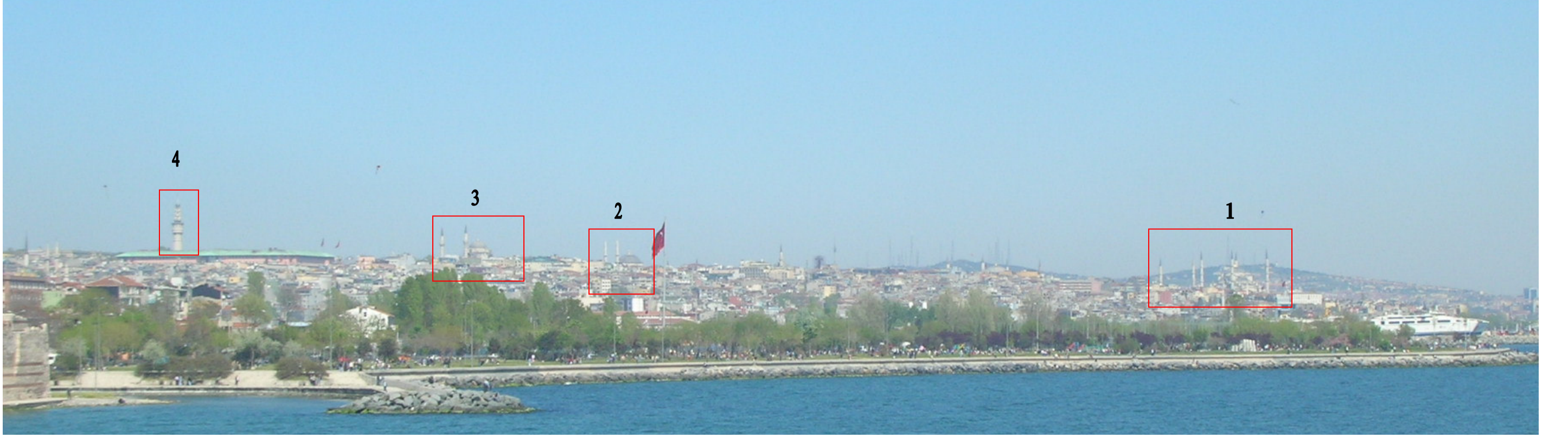
Şekil 5.6 Zeytinburnu Sahil Yolundan Tarihi Yarımada'nın Görünümü Ve Önemli Yapılar
