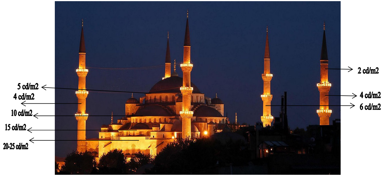
Şekil 6.12 Sultanahmet Cami Aydınlatması
