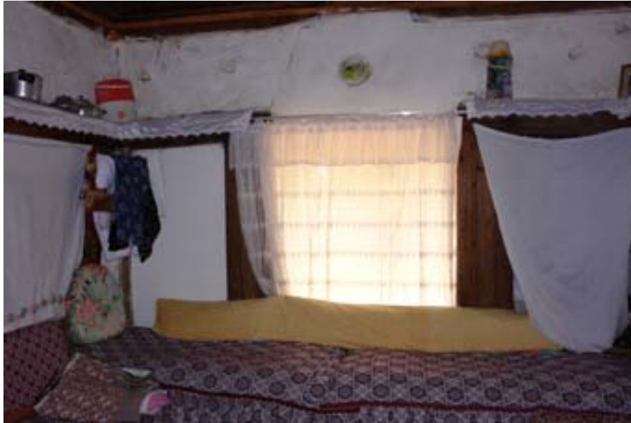
Şekil 6.32 202 nolu odanın batı duvarında davlumbazlı ocak kaldırılarak yerine konan çift kanatlı pencere
