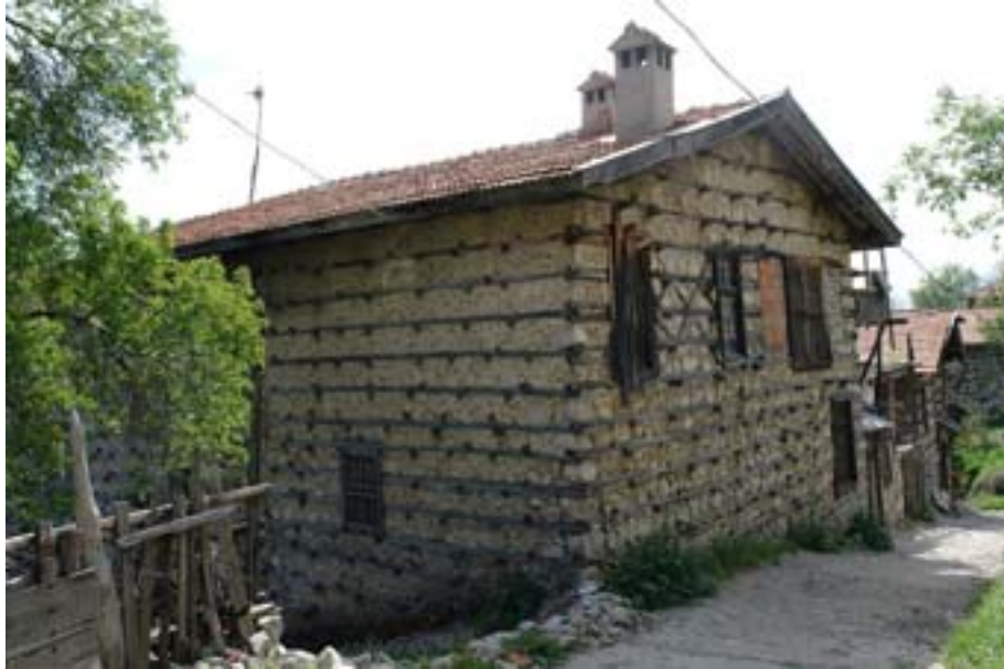
Şekil 6.45 Yapının batı cephesi
