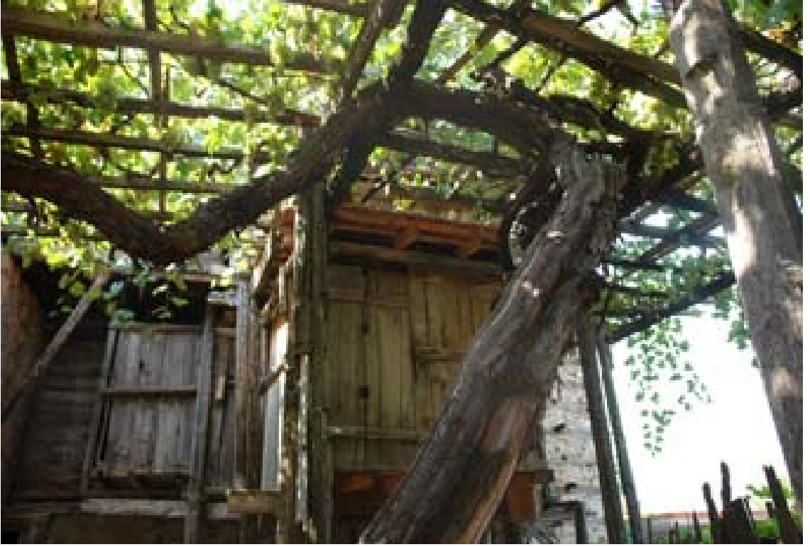
Şekil 6.39 Giriş cephesi 1. katta bulunan banyo ve wc
