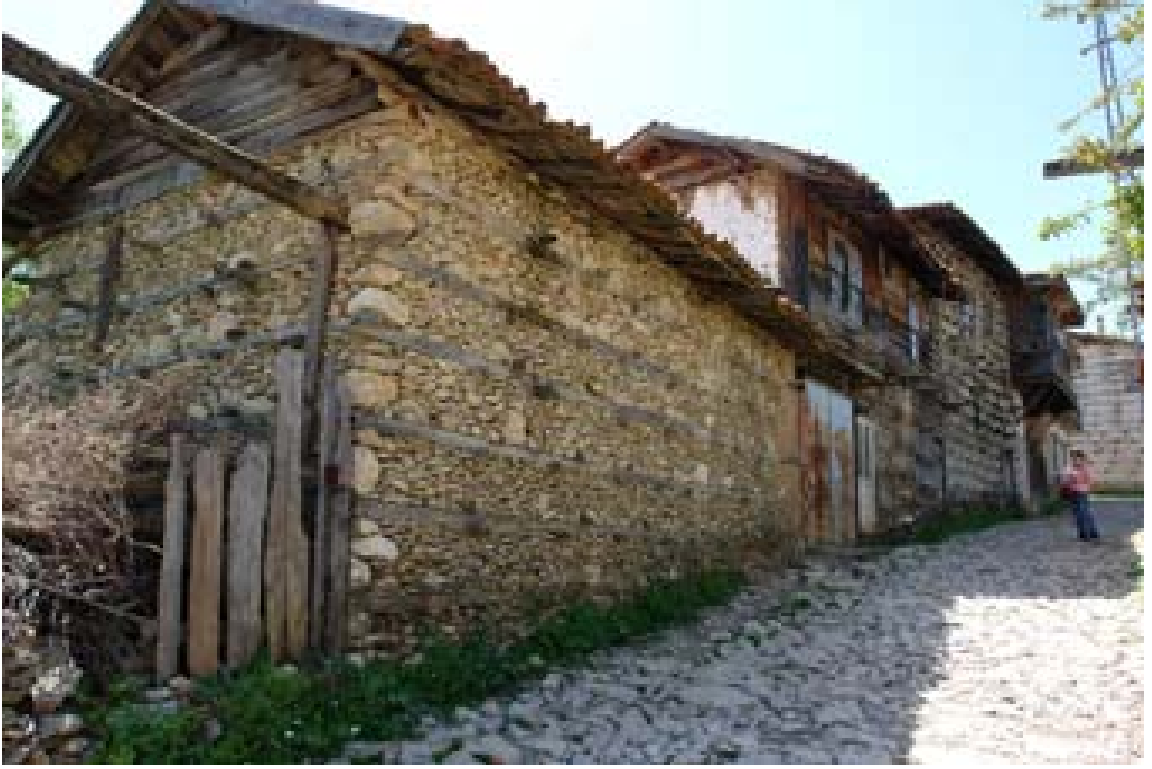
Şekil 6.2 Silüeti çıkarılan sokağın 1 nolu fotoğrafı
