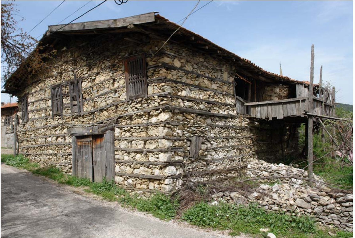
Şekil 4.26 Ürnlü evinde cephe
