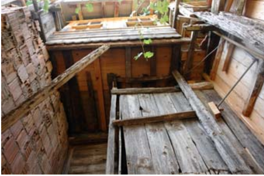
Şekil 6.41 Müdahale görmüş şahnişin
