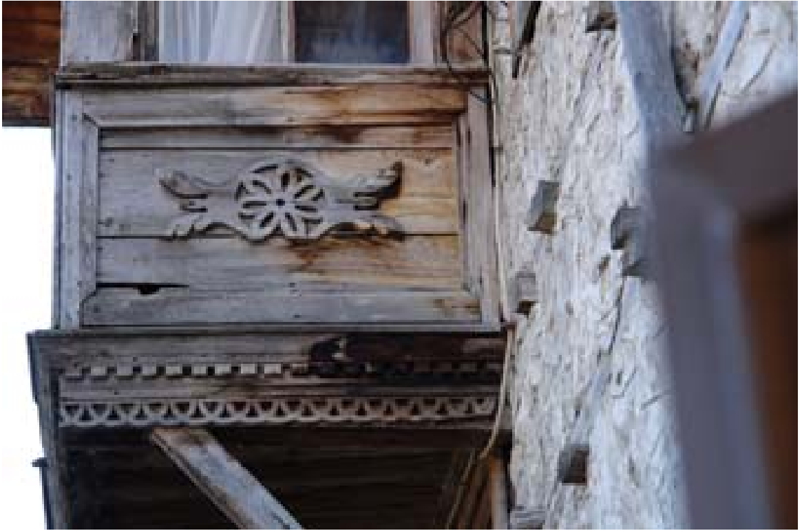
Şekil 4.59 Ahşap işçiliğini gördüğümüz çıkma örneği
