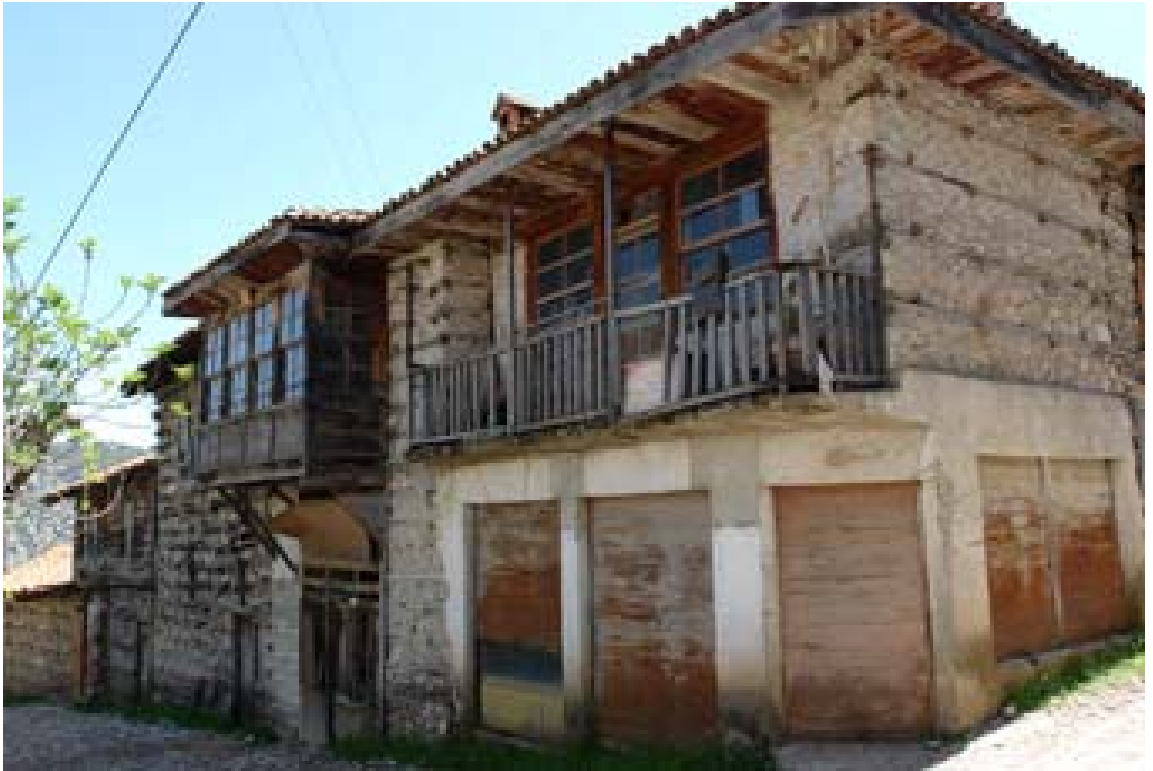
Şekil 6.5 Silüeti çıkarılan sokağın 4 nolu fotoğrafı
