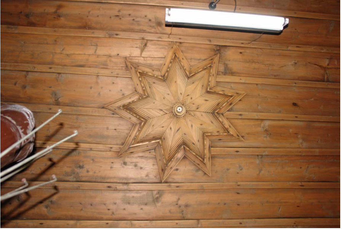
Şekil 4.61 Yıldız göbekli alttan çakmalı düz ahşap tavan
