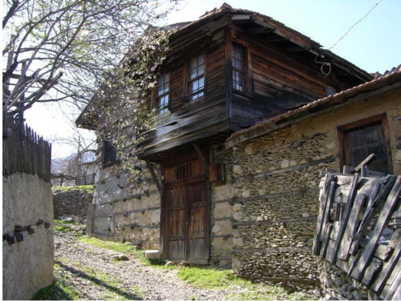
Şekil 4.1 Sokaktan girilen yapılara örnek
