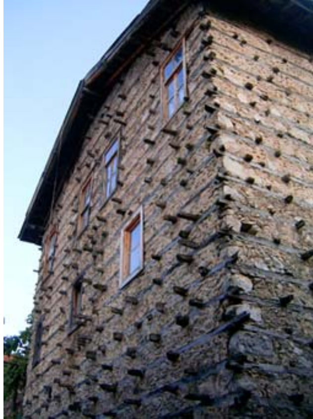
Şekil 6.43 Yapının doğu cephesi
