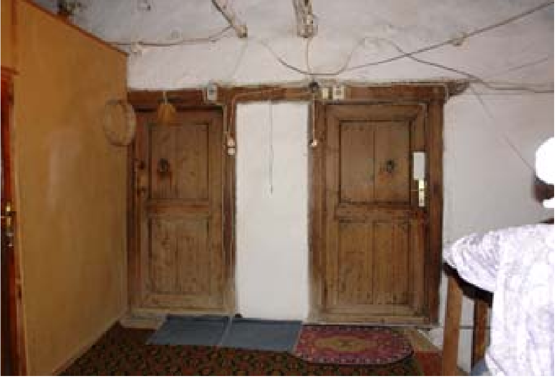
Şekil 4.36 Ahşap oda kapıları
