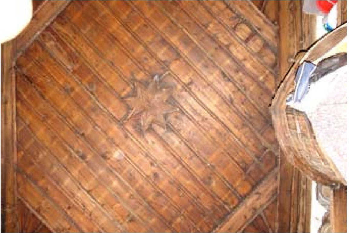
Şekil 4.62 Ahşap çıtalarla birbirini dik kesen karelere ayrılmış tavan ortasına ise sekiz kollu yıldız formu göbek
