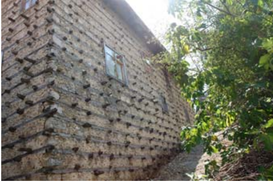
Şekil 6.42 Yapının kuzey cephesi
