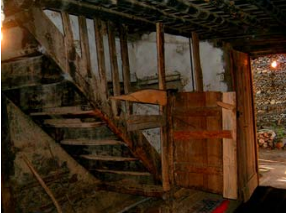
Şekil 6.9 Zemin kat merdiveni
