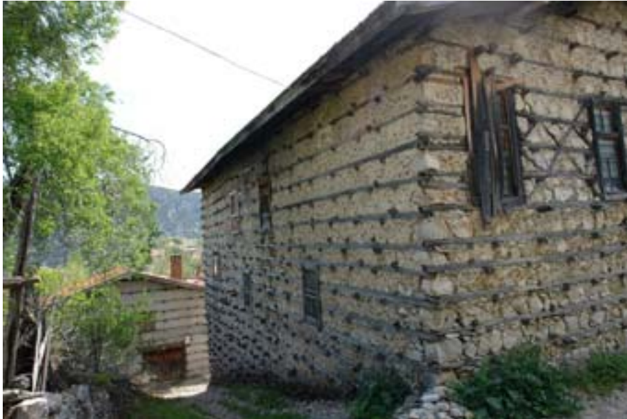
Şekil 6.42 Yapının kuzey cephesi
