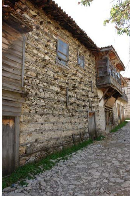
Şekil 6.4 Silüeti çıkarılan sokağın 3 nolu fotoğrafı
