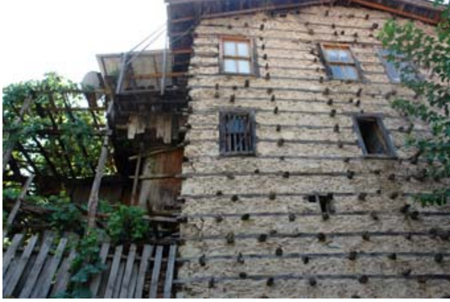
Şekil 6.44 Yapının doğu cephesi
