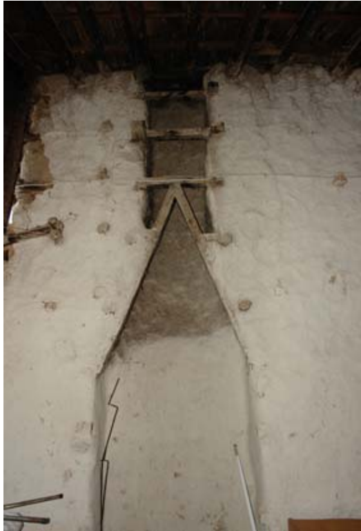
Şekil 4.69 Duvarda bırakılan ocak yeri
