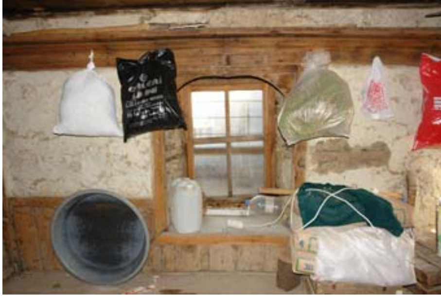
Şekil 6.19 102 nolu oda pencere ve raf silmesi
