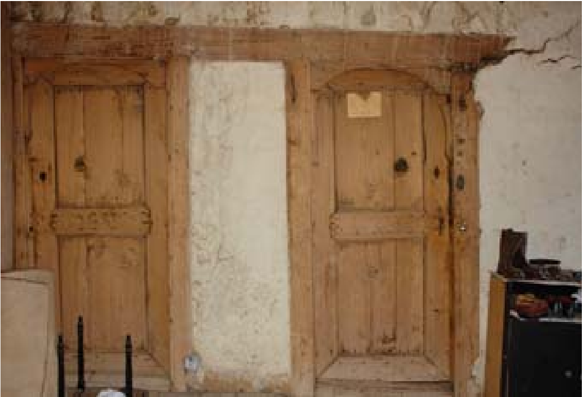
Şekil 4.37 Ahşap oda kapıları
