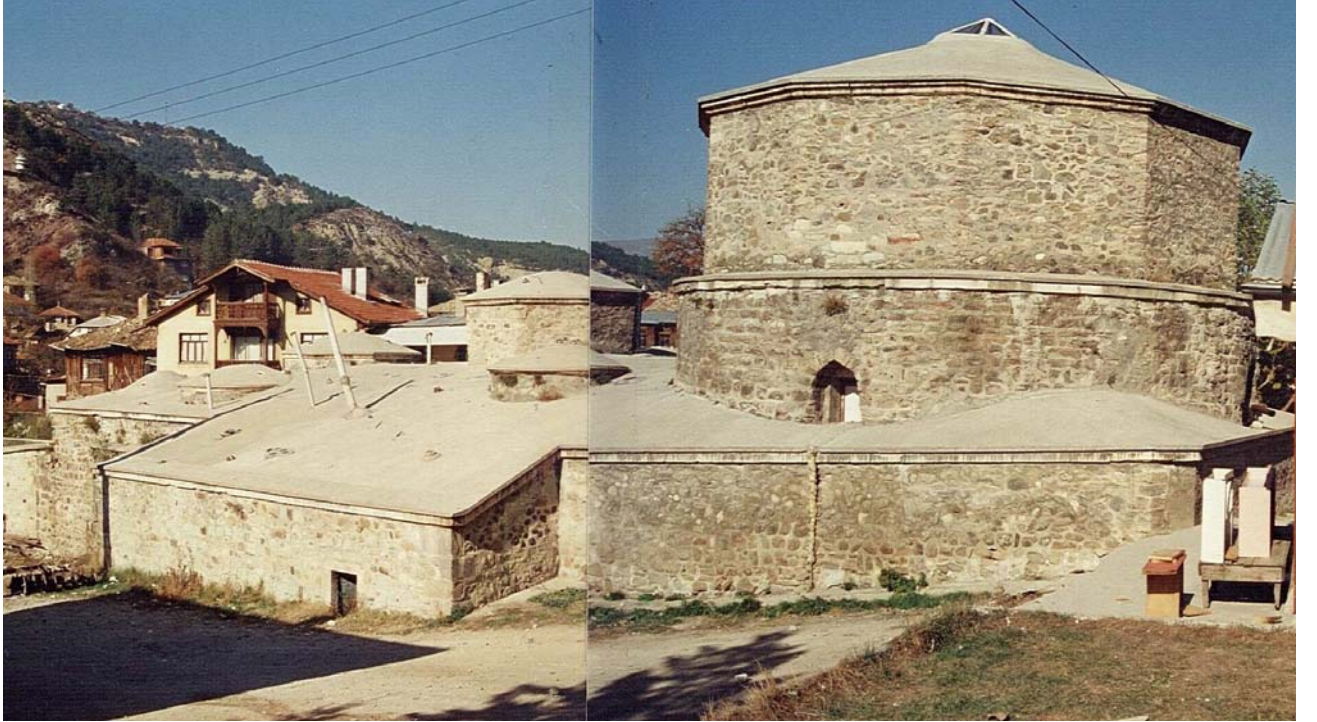
Fotoğraf 3.26 Yıldırım Hamamı, Arka cephesi
