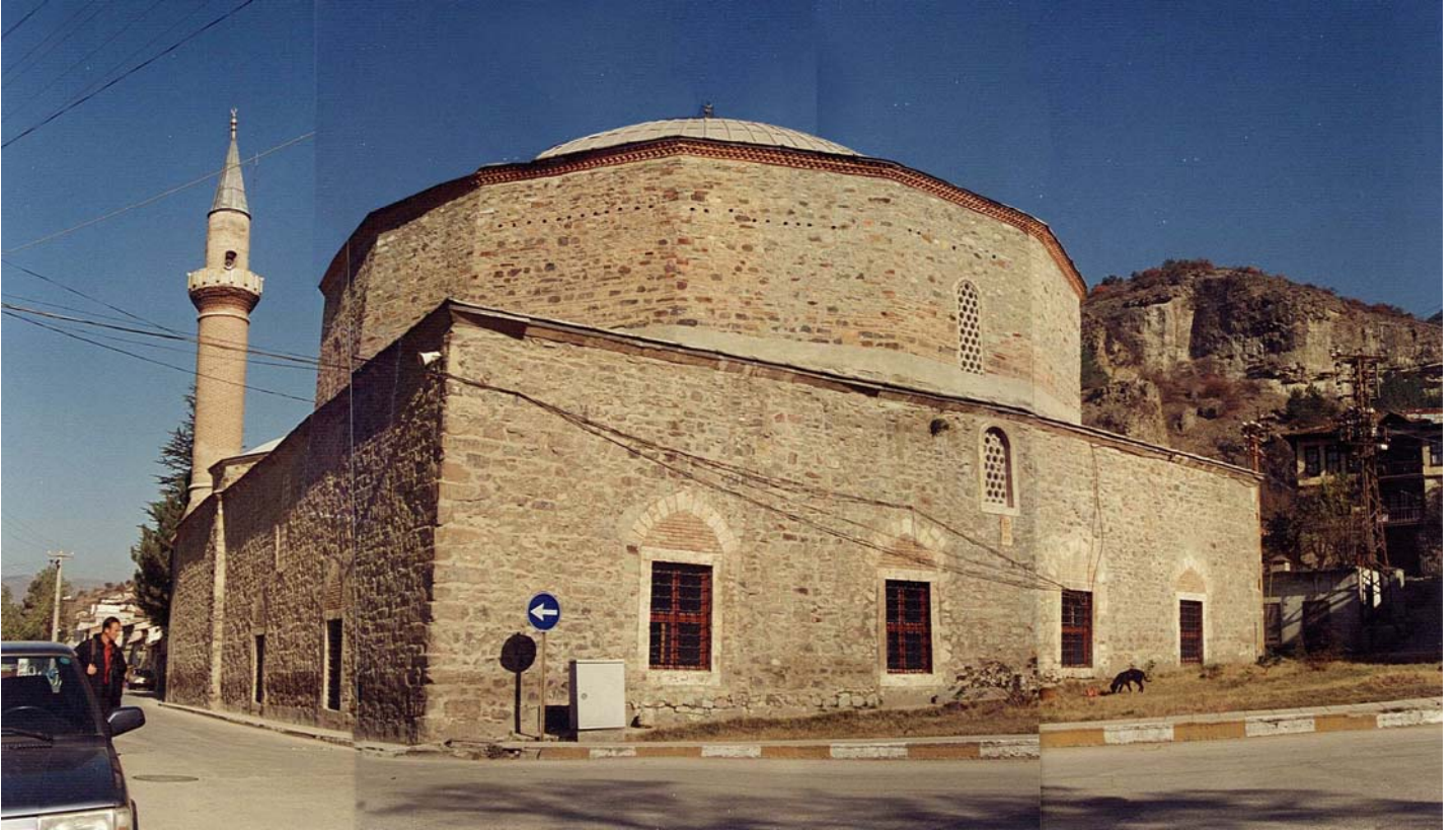
Fotoğraf 3.10 Yıldırım Camii, güney cephesi
