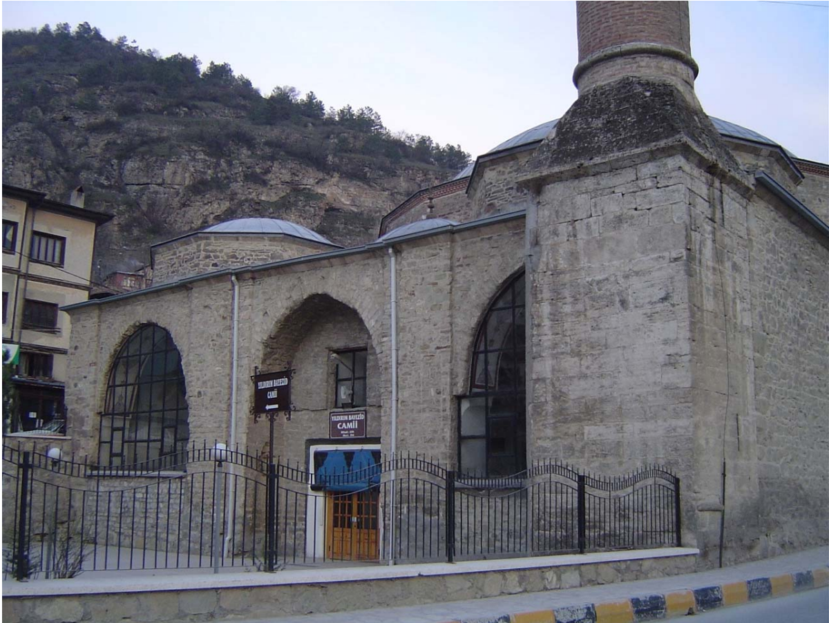
Fotoğraf 3.8 Yıldırım Camii, Giriş cephesi
