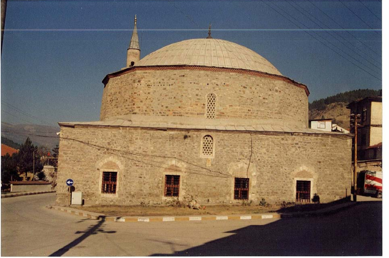
Fotoğraf 3.11 Yıldırım Camii, Giriş cephesi
