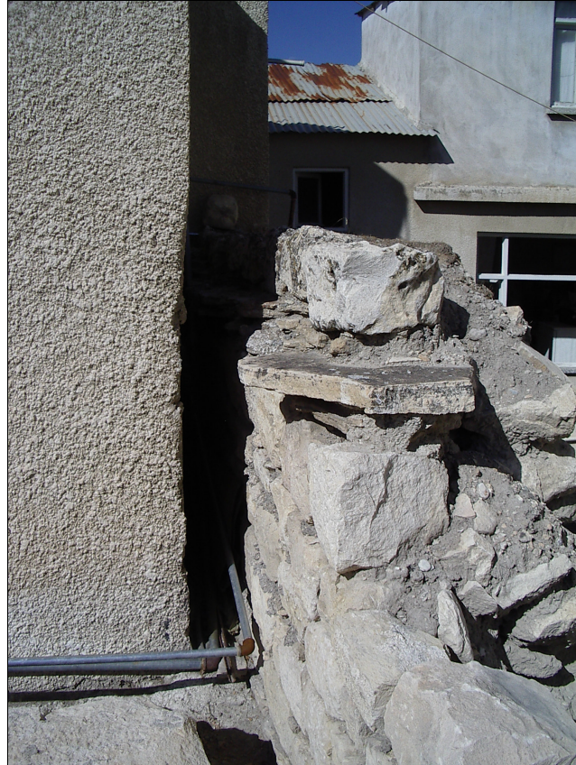
Şekil 38 Damda parapet duvarı kalıntısı
