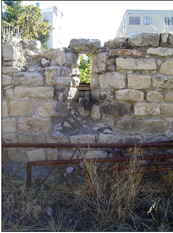
Şekil 13 Katırlığın dış duvarı üzerinde yer alan menfez
