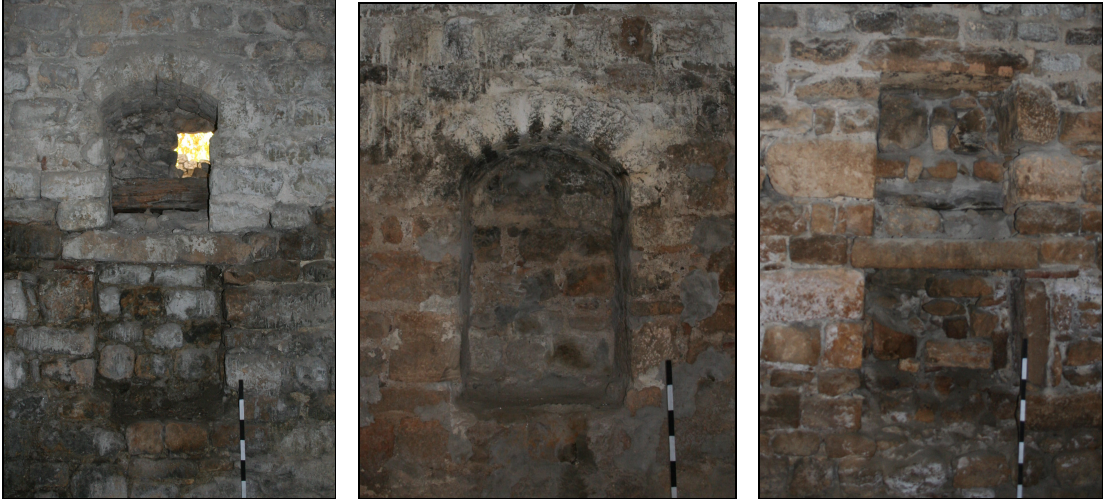
Şekil 4.8 Dış duvarlarda yer alan niş tipleri
