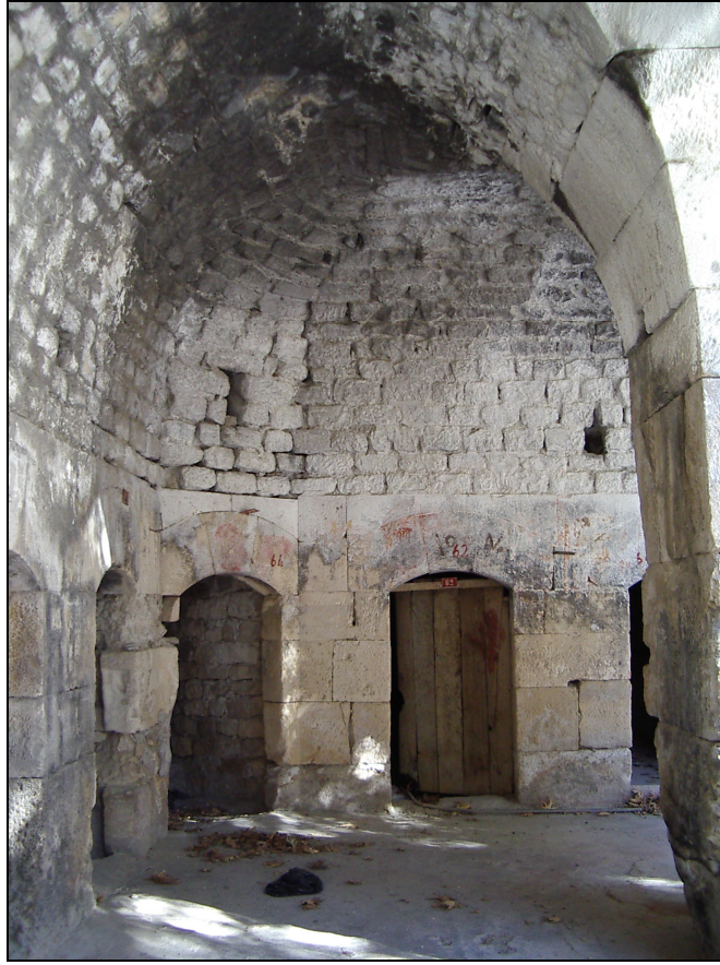
Şekil 5 Köşe revaklar ve oda giriş kapıları
