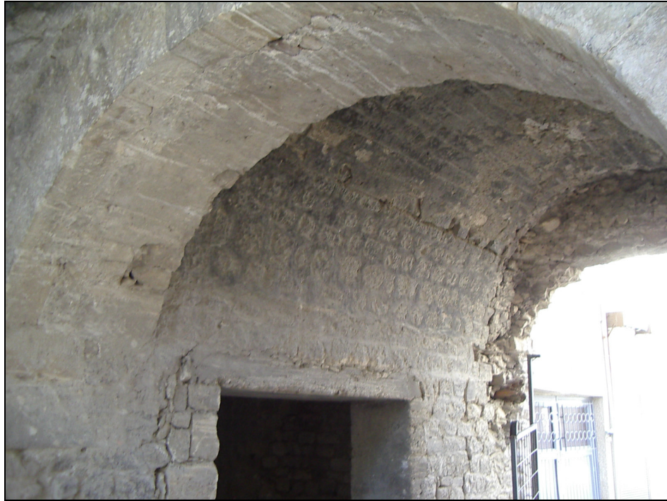
Şekil 22 Muhdes girişte, oda duvarı yıkıldıktan sonra yapılan kemer
