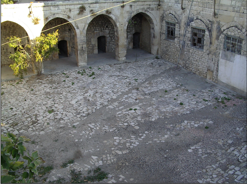
Şekil 4 Avluda bulunan özgün taş döşeme kaplaması
