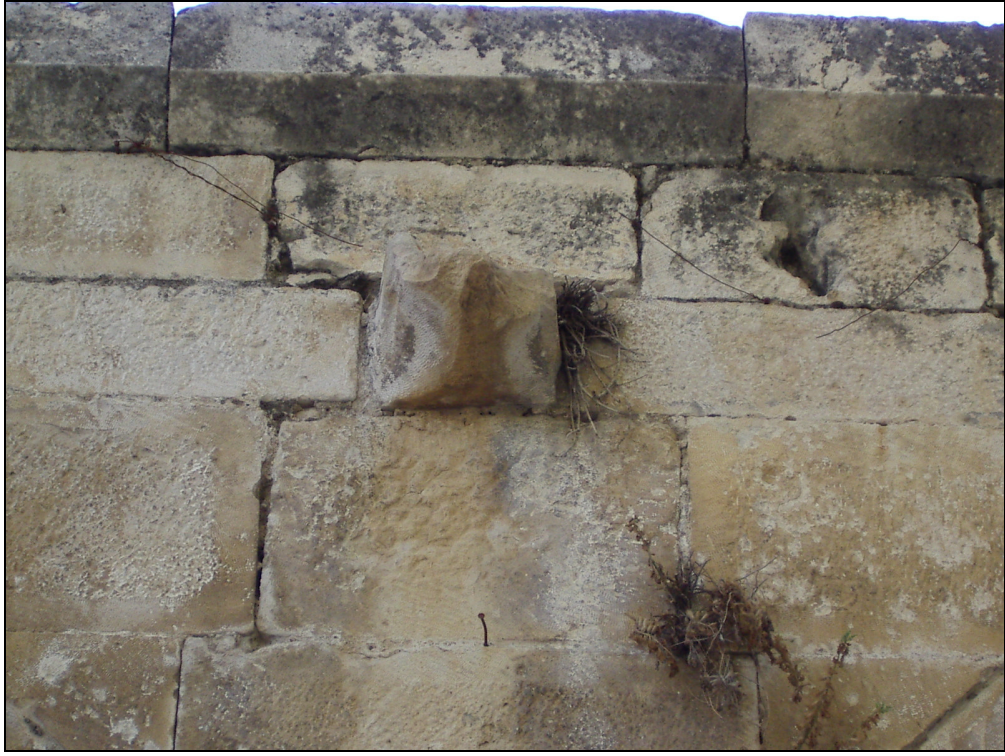
Şekil 48 Çatı silmesi ve çörlen
