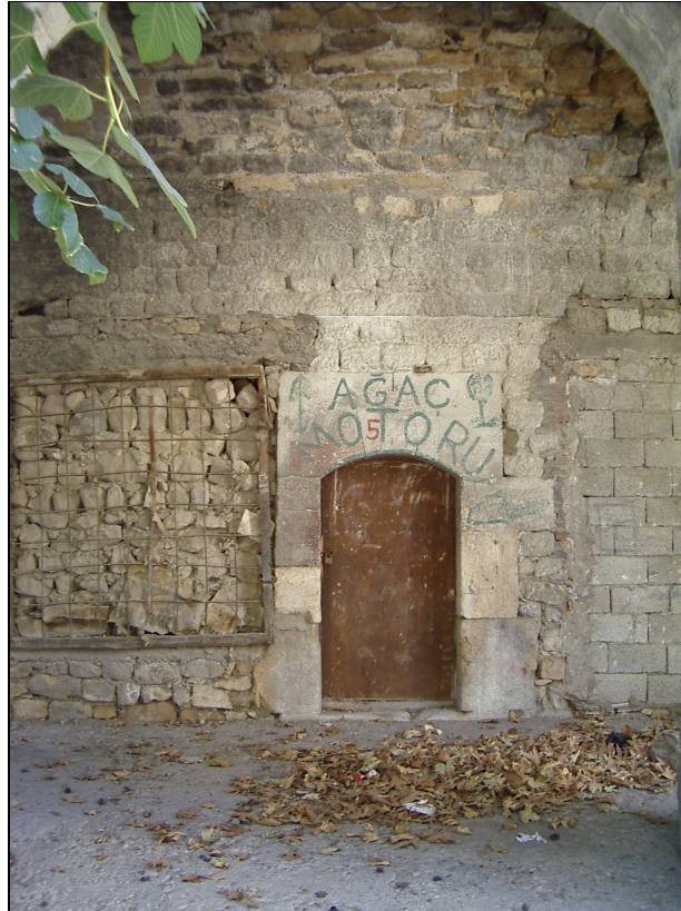
Şekil 32 Moloz taş ile doldurulmuş muhdes pencere boşluğu
