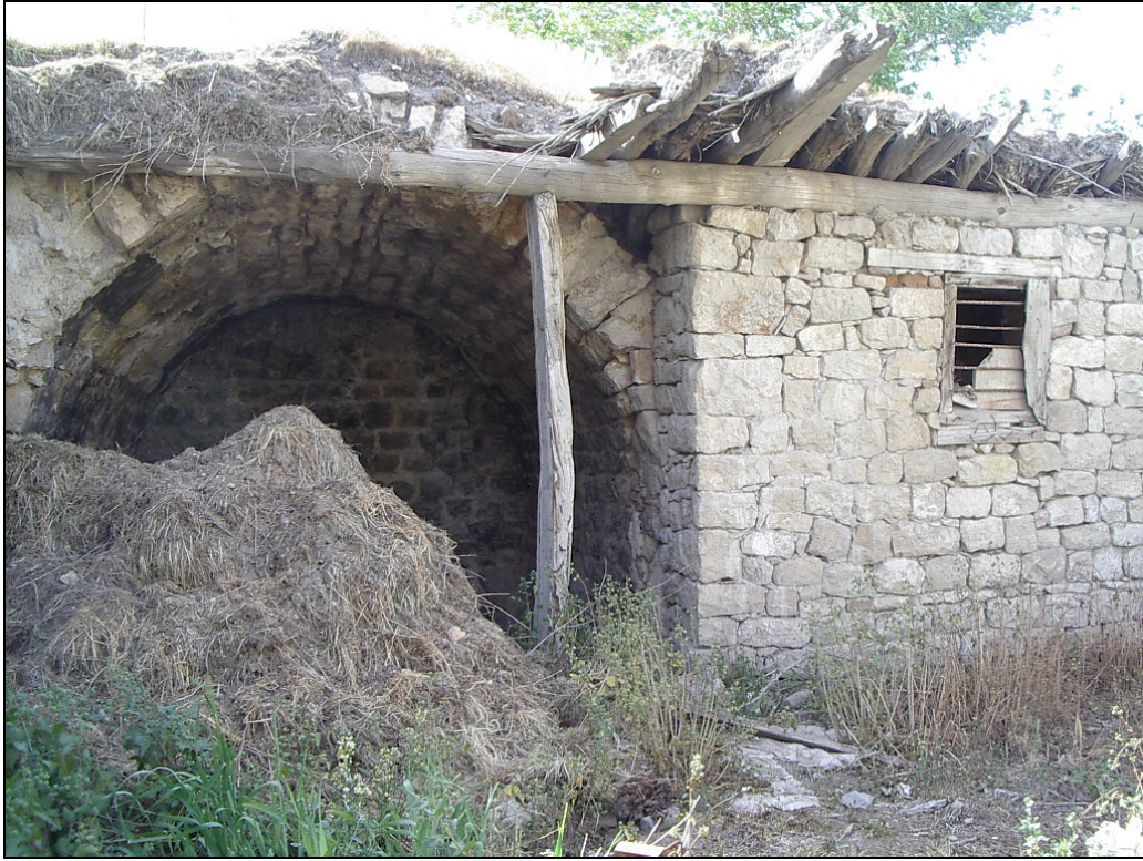
Şekil 33 Katırlık girişine örülmüş muhdes duvar
