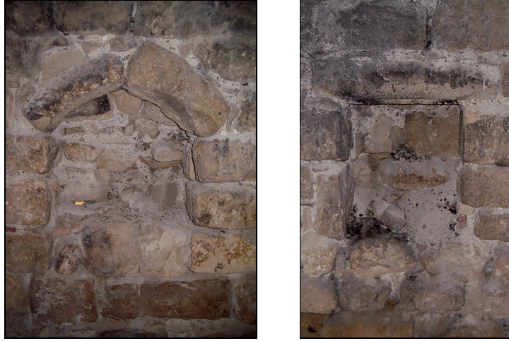
Şekil 4.9 Yan duvarlarda yer alan niş tipleri
