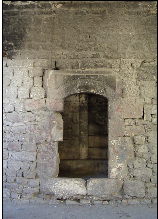
Şekil 8 Merdiven giriř kapısı
