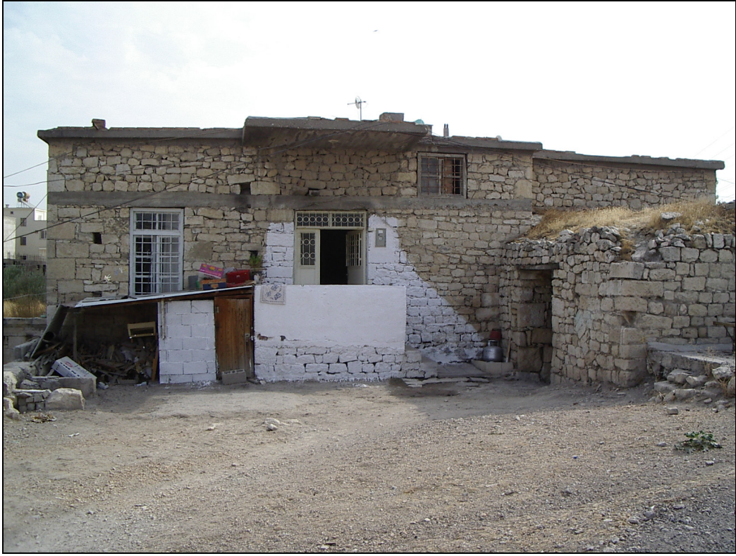
Şekil 27 1962-1963 yıllarında inşa edilmiş muhdes konut
