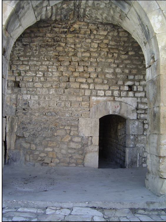
Şekil 4.6 Oda giriş kapısı
