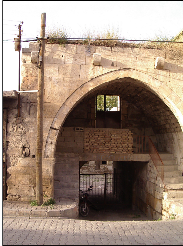
Şekil 20 Portalin içinde bulunan muhdes çıkma ve merdiven
