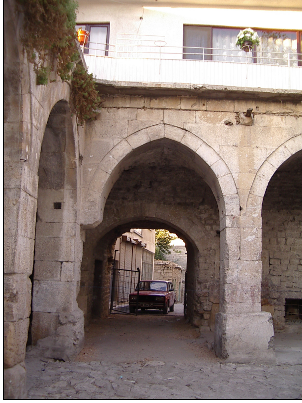
Şekil 4.17 Kuzey cephesindeki muhdes giriş
