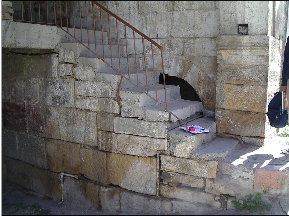
Şekil 6 Portal içinde, önüne muhdes merdiven eklenerek kapatılmış niş
