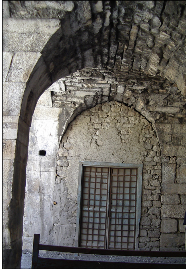
Şekil 23 Girişin doğusunda bulunan kapatılmış revak
