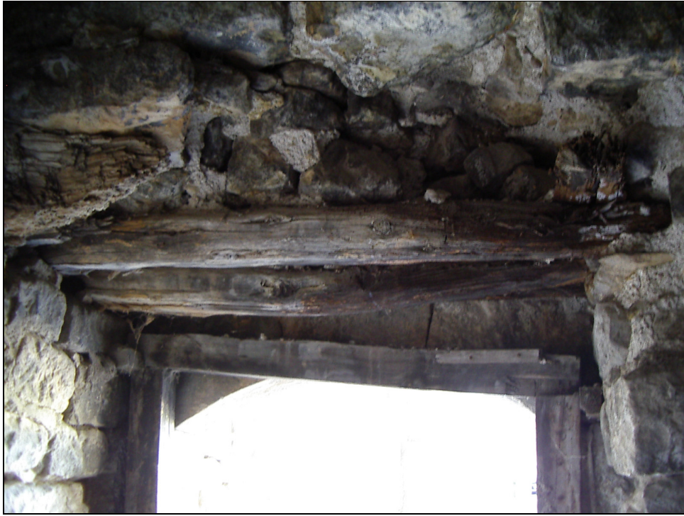
Şekil 45 Oda kapılarının üzerinde yer alan ahşap hatıllar
