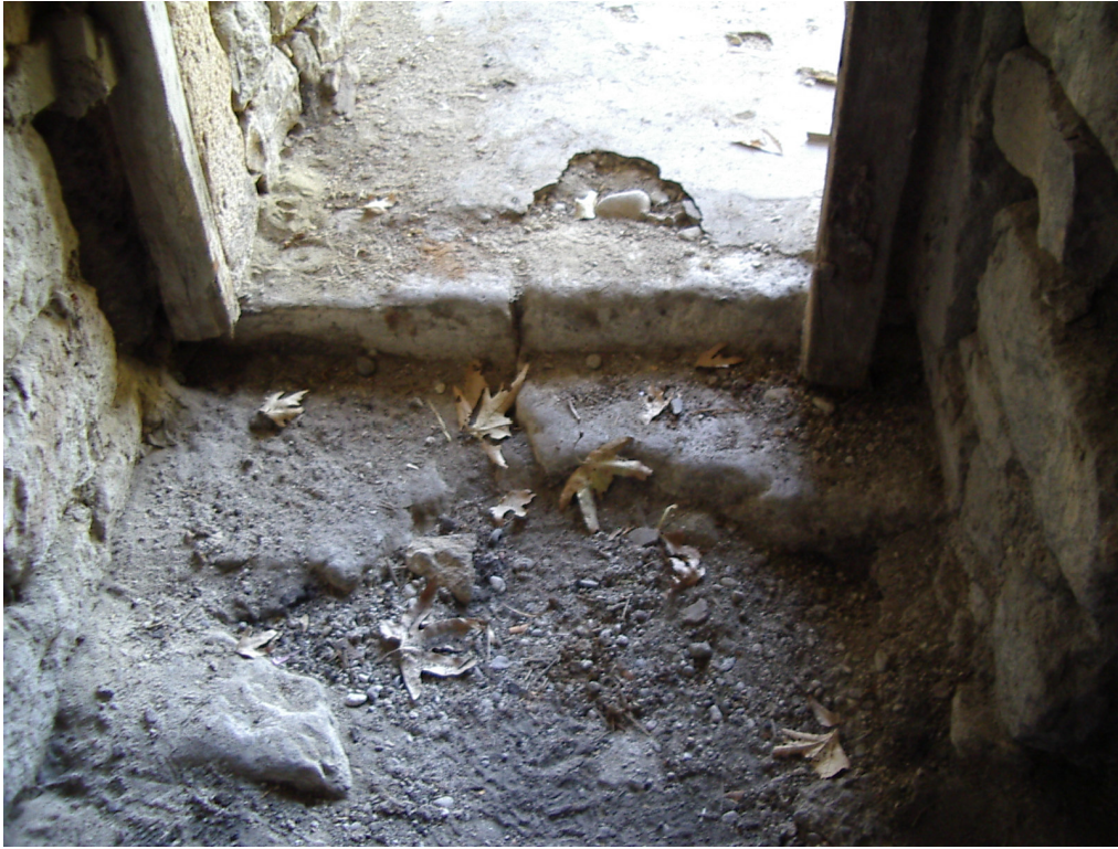
Şekil 42 Özgün taş eşik ve döşeme kaplaması kalıntısı
