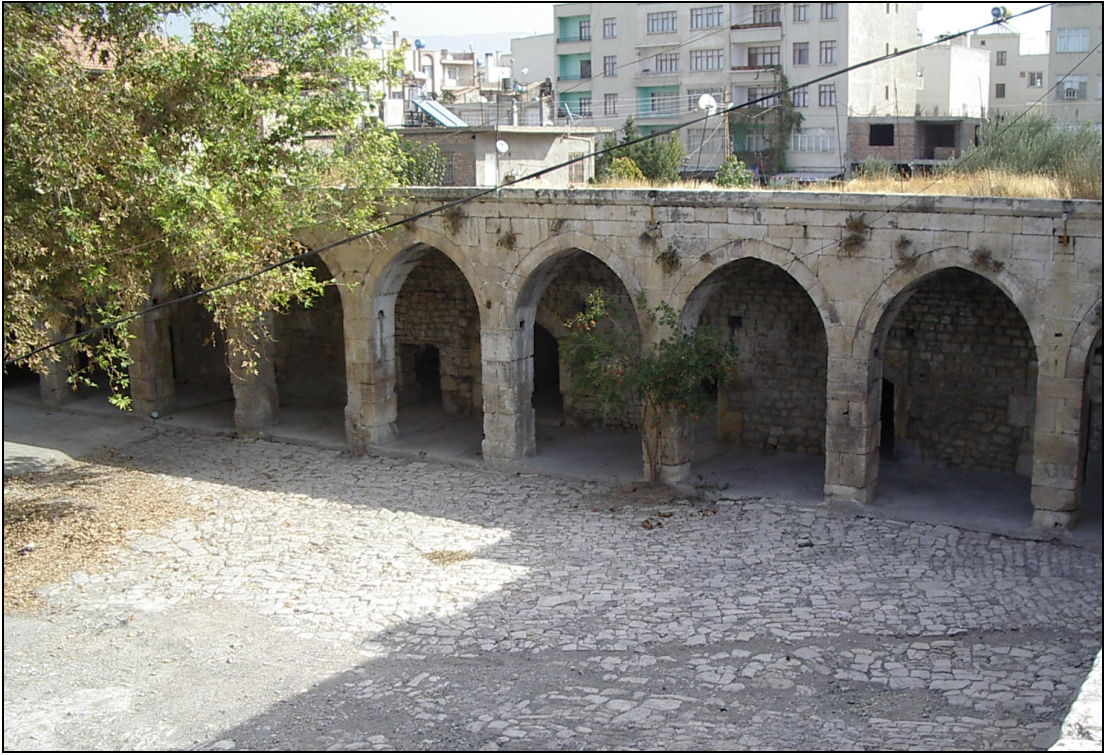
Şekil 4.4 Avlu çevresinde yer alan revaklar
