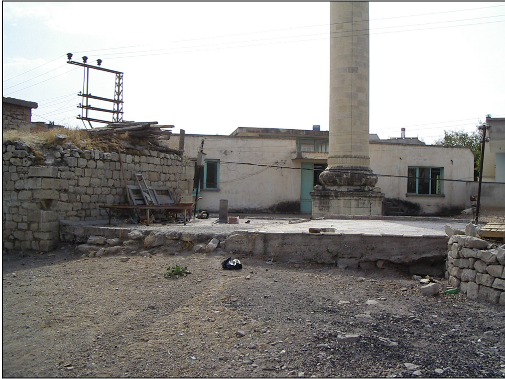
Şekil 26 Komşu dükkanlara ait beton kaplamanın altında, parapet duvarı kalıntısı
