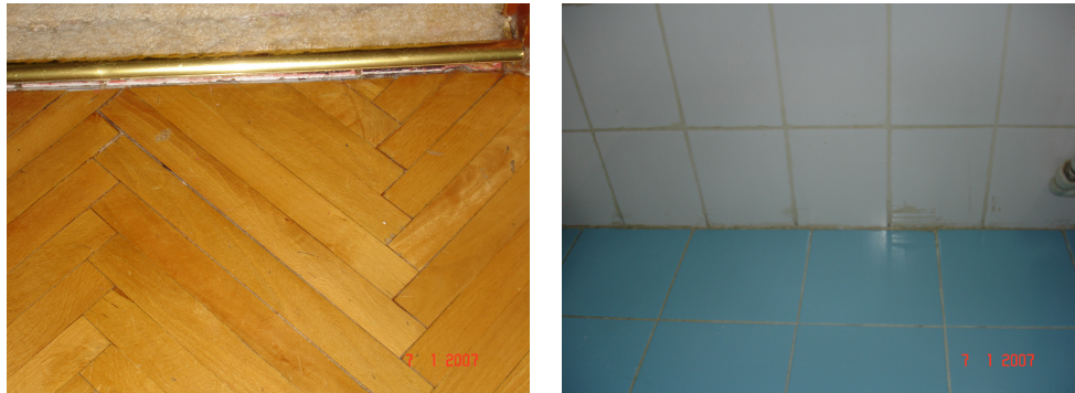
Şekil 3.43 Ucuz, kalitesiz malzeme ve işçilikle yapılmış apartmanlar, Ümraniye, İstanbul
