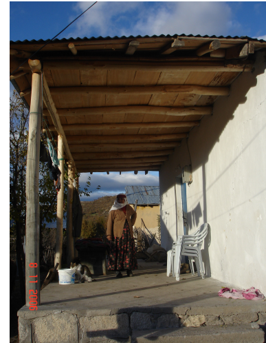
Şekil 4.37 a-Taş ve ahşap kullanılarak yapılmış mutfak eki, b-balkon eki
