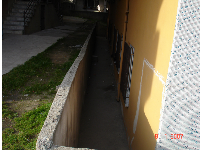
Şekil 3.37 İstinat duvarına bakan bodrum kat pencereleri
