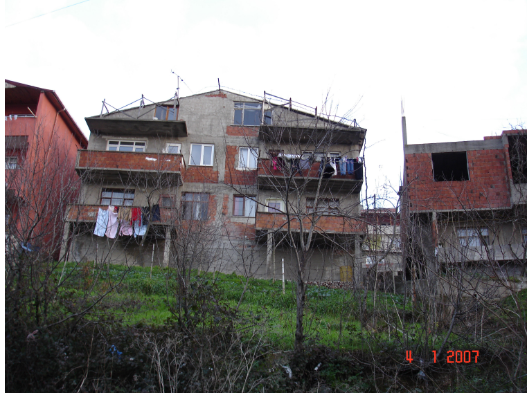
Şekil 3.42 Apartmanlaşmış gecekondu, Ümraniye, İstanbul.
