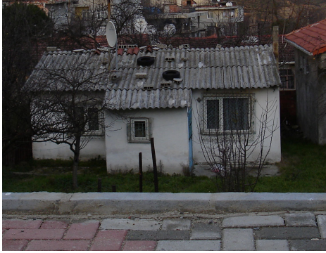
Şekil 3.29 Çatıların üzerine taş ve lastik koyularak çatıların uçması önlenmeye çalışıldığı gecekondular örnekleri, İstanbul, Ümraniye.
