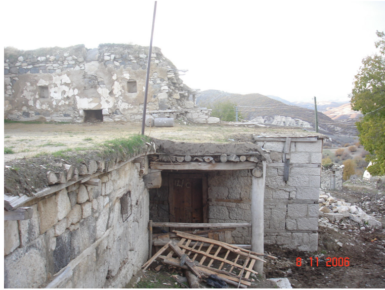
Şekil 4.8 Eğime oturmuş iki katlı taşlı ev örneđi (üst kat yıkılmış)
