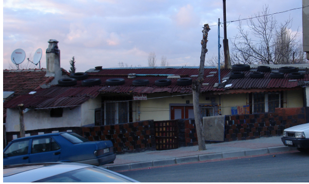
Şekil 3.29 Çatıların üzerine taş ve lastik koyularak çatıların uçması önlenmeye çalışıldığı gecekondular örnekleri, İstanbul, Ümraniye.
