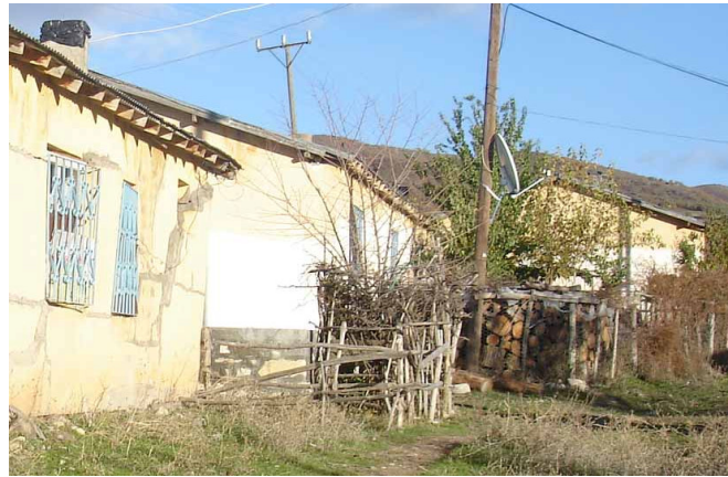
Şekil 4.41 Eski deprem konutlarında odunluk olarak da kullanılan bahçe
