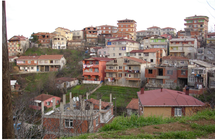
Şekil 3.16 Apartmanlaşan gecekondu, Ümraniye, İstanbul (Bilgin, 1996).
