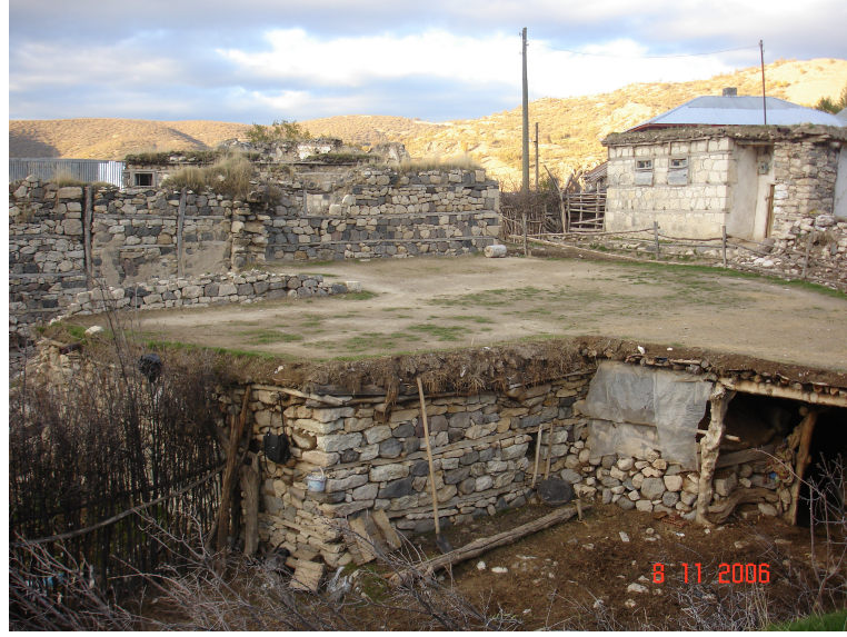
Şekil 4.9 Eğime oturmuş iki katlı teraslı ev örneği (üst kat yıkılmış)
