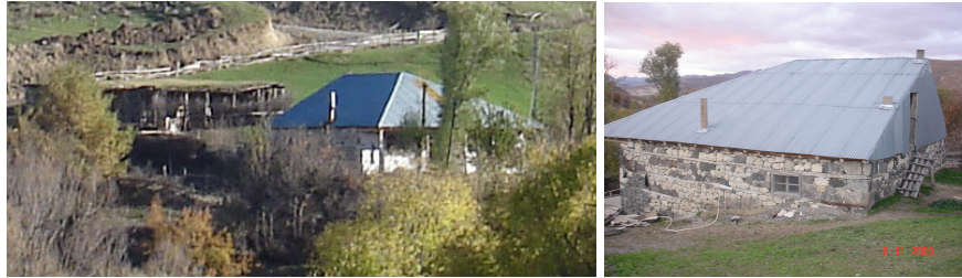
Şekil 4 17 a- İsmail Emsiz Evi, ev ve hayvan barınağı ilişkisi, hayvan barınağı evin arkasındaki damlı yapı, b-depo olarak kullanılan çatı arasına çıkış
