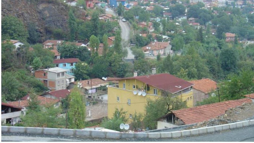
Şekil 3.14 Yeşil içerisinde, az yoğunluklu gecekondu örnekleri, Armutlu
