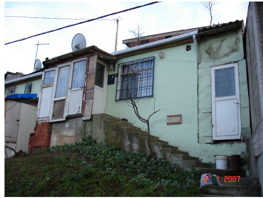
Şekil 3.41 Derleme malzemelerle yapılmış gecekondular, Ümraniye, İstanbul.
