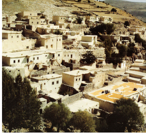
Şekil 3.32 Topoğrafya ile bütünleşmiş yerleşme örneği, Kozluca, Malatya (Aran, 2000).
