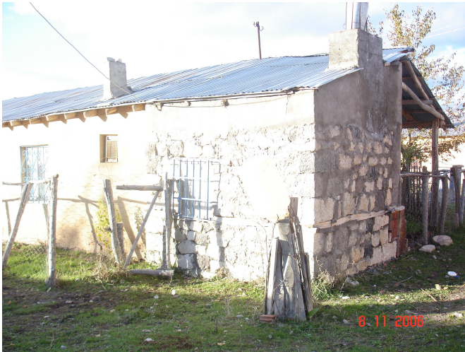
Şekil 4.37 a-Taş ve ahşap kullanılarak yapılmış mutfak eki, b-balkon eki
