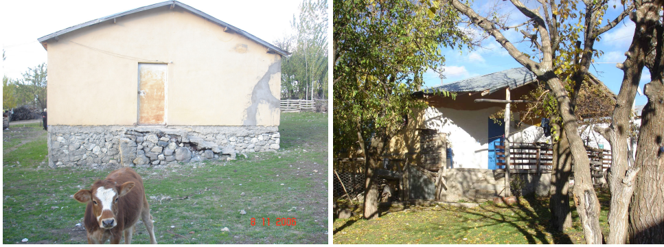
řekil 4.45 a-Eski deprem konutlarının mevcut giriř terası; b-Eklenmiř teras
