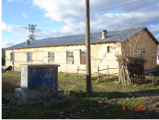
Şekil 4.24 Eski deprem konutu (ikiz konut örneği)
