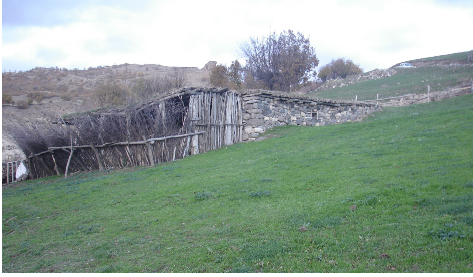
Şekil 4.33 Eğime uyumlu yapılmış hayvan barınakları.
