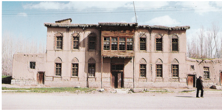
Şekil 3.38 Temel duvarları taş, normal duvarları kerpiç ve çıkması ahşap olan Van evi (Sözen, Eruzun, 1992).
