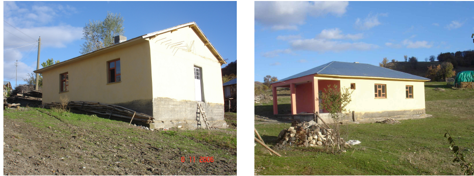
řekil 4.46 a-Yeni deprem konutlarında giriř; b- Yeni Deprem konutunda ek para denerek yaptırılmıř giriř terası
