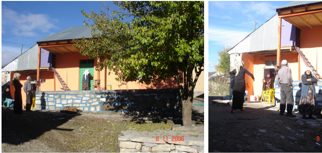
Şekil 4.21 a- Cezayir Oral evi, b- Evin ayrı yapılmış, 60 cmlik taş duvarlı mutfağı
