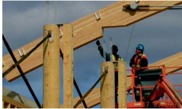
PSL kolonlar ile glulam kirişlerin birleşimi.
