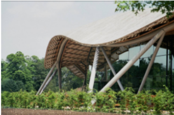
Yapının çatısının içten görünümü ve dış V kolonlar.
