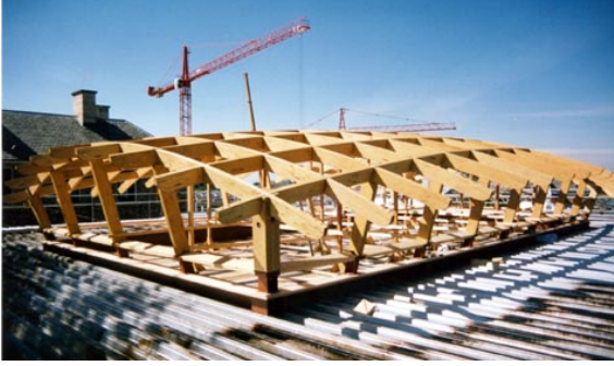
Çatı sisteminin görünümü.
