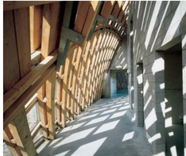
Yapının çatı sisteminin içten görünümü.
