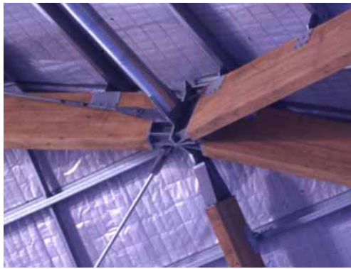
Kubbenin kurulumu ve birleşim detayı.
