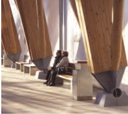
Yapıda kullanılan kemer elemanlar ve mesnet bağlantıları.
