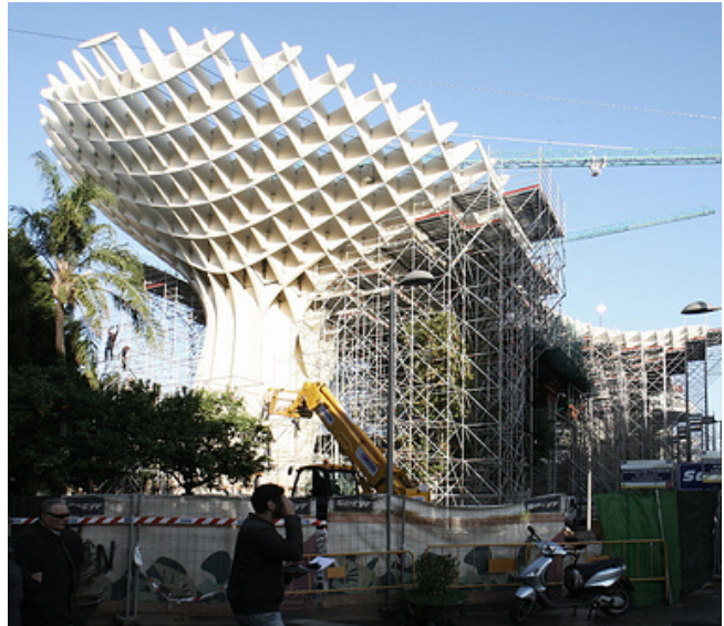
Şekil 4.25 Metropol Parasol yapısının kurulum aşamasından bir görünüm [91].
