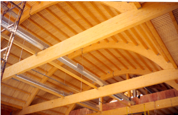
Yapıda kullanılan eğri kirişleriniçten görünümü.
