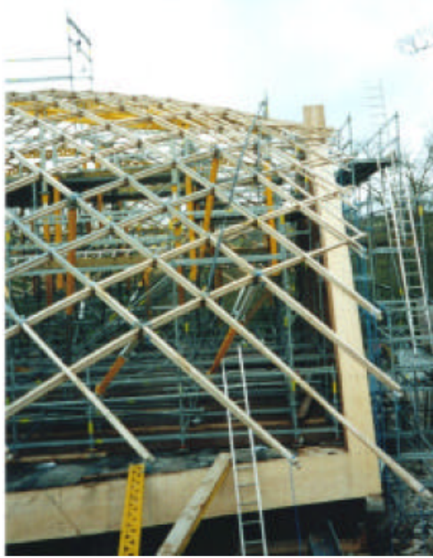
Çatının tamamlanmaya yakın görünümü.
