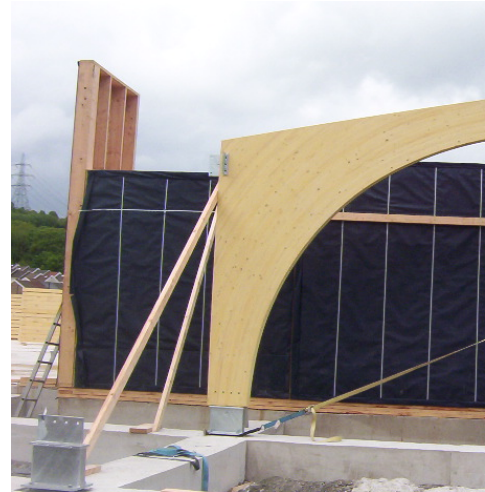
Şekil 3.14 Zemin plaka bağlantıları ile elemanların birleşimleri [50].
