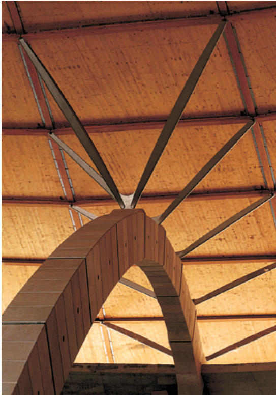
Yapının kemer sisteminin görünümü.
