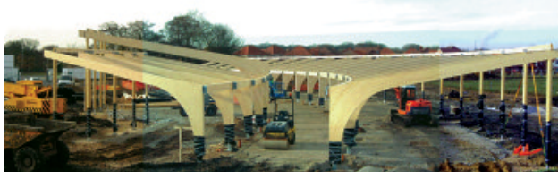
Yapıda kullanılan glulam kirişler.
