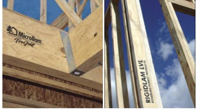
Şekil 4.23 A.B.D’de yaygın kullanılan LSL elemanlar [89], [90].
