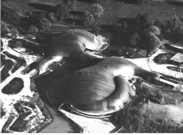
Yapının dış görünümü.
