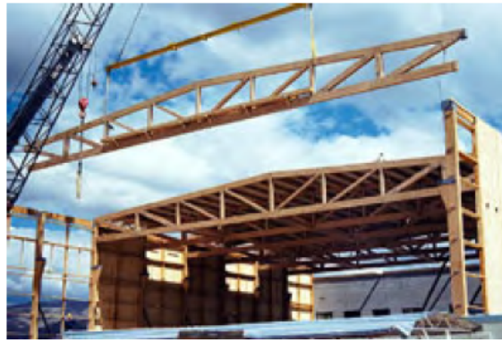
Şekil 5.15 Bir çatı makasının destek elemanı yardımıyla taşınması [124].
