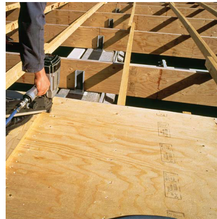
Şekil 4.22 Q tipi panelin uygulanması [87].
