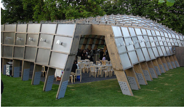
Yapının dış görünümü.
