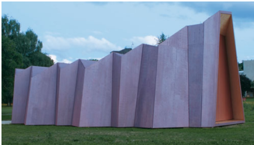
Yapının dış görünüşleri.
