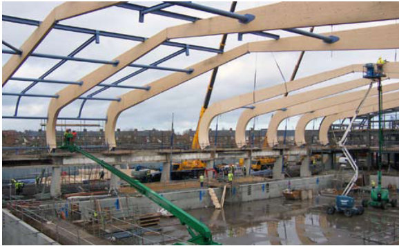
Yapının kemer sistemi.
