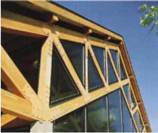
Yapının dış görünümü.
