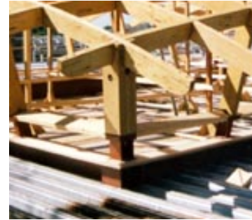
Köşe kolon detayı.
