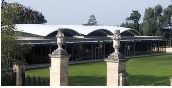
Yapının dış görünümü.
