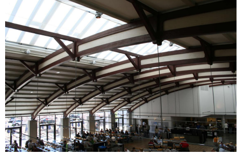
Şekil 4.2 Hala kullanılan tabakalı ahşap kemer, 1916, Copenhagen [65].
