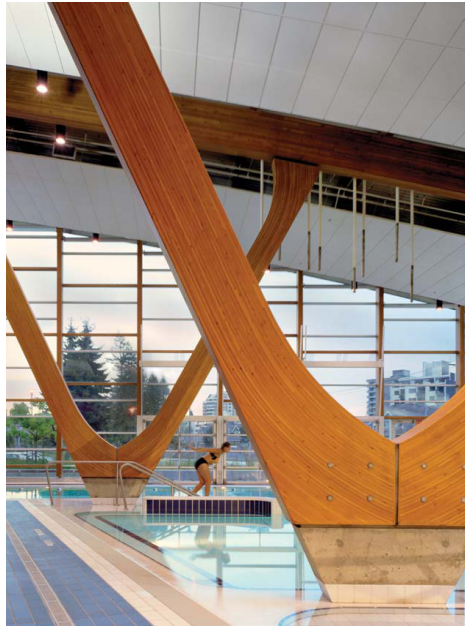
Yapıda kullanılan glulam V kolonlar.
