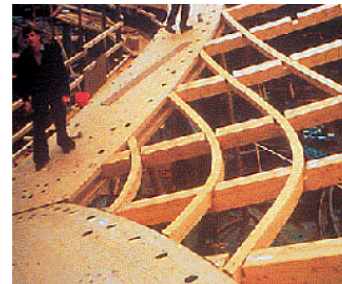
Çatı ızgarasını oluşturan elemanların görünümü.
