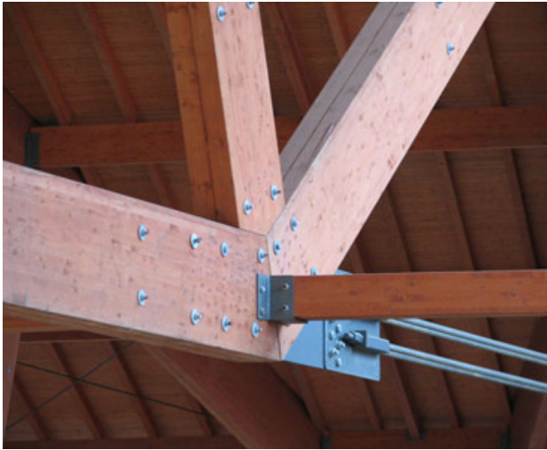
Çatı makaslarının merkez kısmı ve birleşim detayı.
