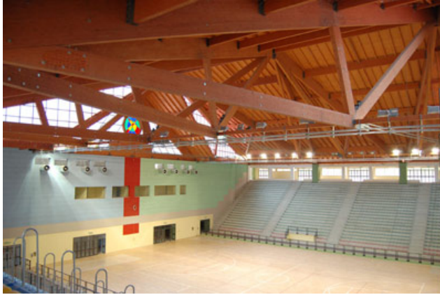
Yapının çatı makaslarının içten görünümü.
