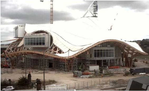
Yapının inşası sırasında bir görünüm.
