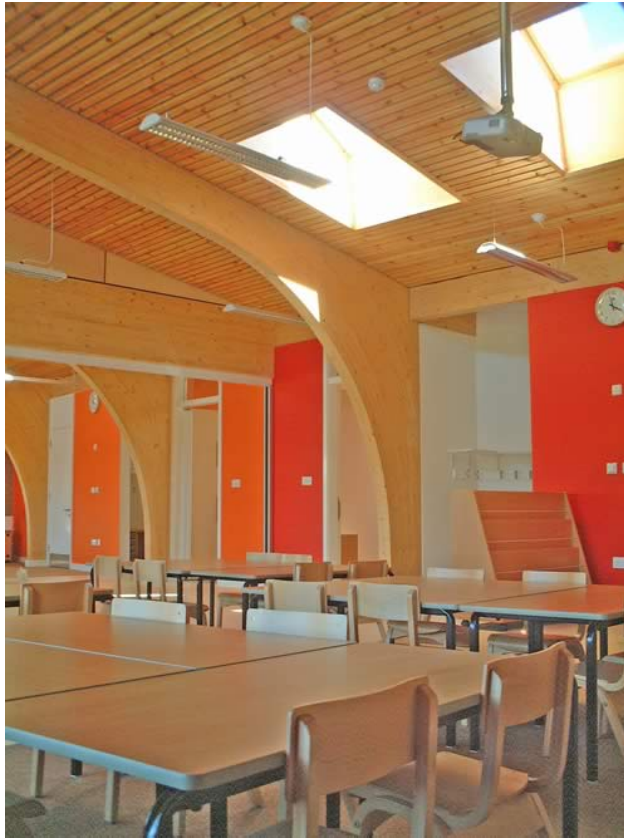
Yapıda kullanılan glulam kirişler.
