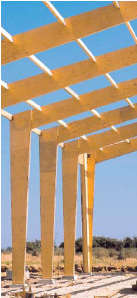
Şekil 4.24 LVL elemanlardan kurulmuş bir çerçeve sistem [87].
