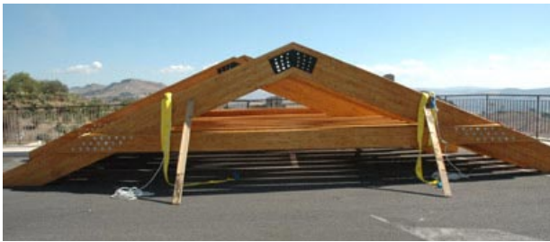
Çatı makaslarının görünümü ve şantiyede uygun şekilde desteklenmesi.
