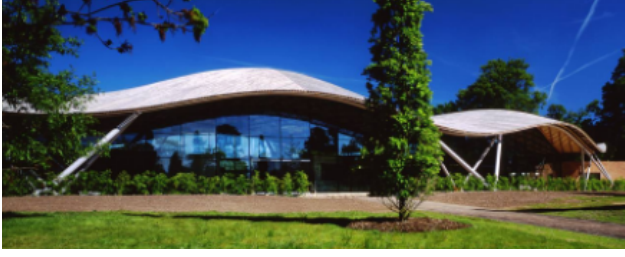
Yapının dış görünümü.
