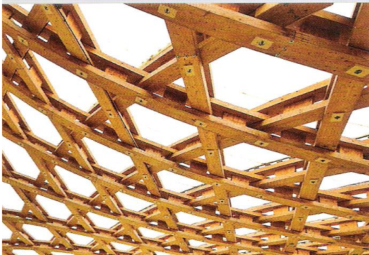
Yapının dokuma sistem detayı.
