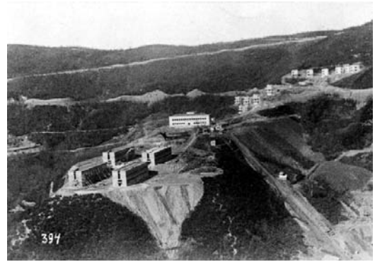
Şekil 3.62 Aydıntepe mahallesi, Üzülmüş İlkokulu ve işçi yurtları. (1937)
