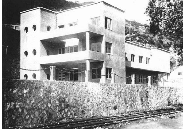
Şekil 3.65 Yapımı tamamlanan Kömür-İş idare binası
