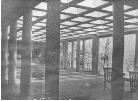
Şekil 3. 91 “Beton arme pergole”
