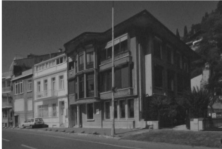
Şekil 3. 225 Armatör Ferit İnal Apartmanı, 2009 (Fotoğraf: Cemal Emden)
