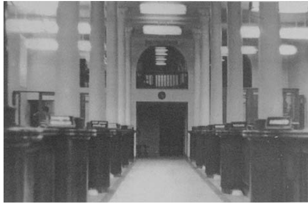
Şekil 3. 235 Osmanlı Bankası Beyoğlu Şubesi, İçeriden Görünüş
