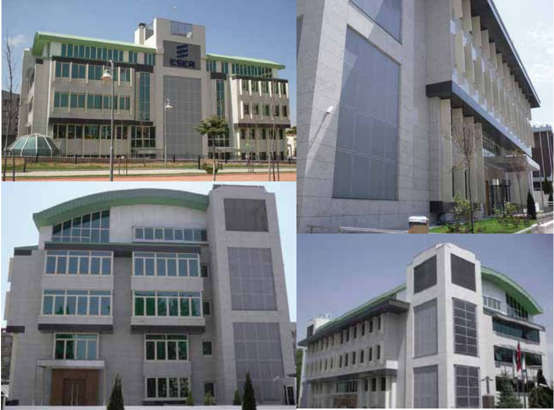
Şekil 5.7 Eser Yeşil Binası Genel Görünüşler [76].
