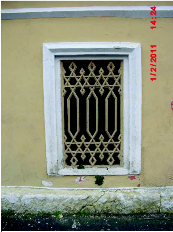
Şekil EK D.288 Profilli kâgir alınlık (taş) ve demir parmaklık görünüşü
