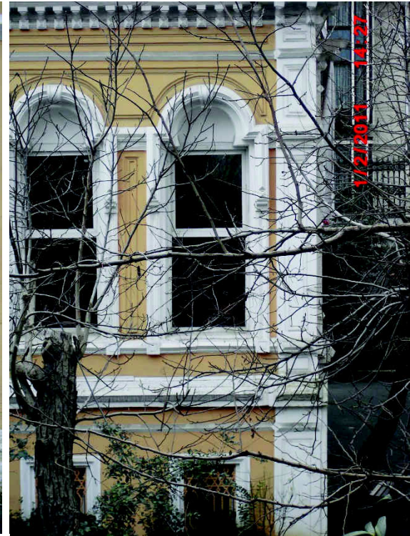
Şekil EK D.287 Kâgir profilli kat silmesi (taş) görünüşü
