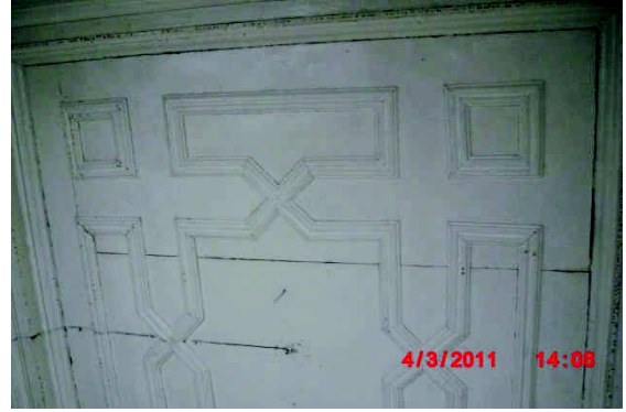
Şekil EK D.134 115 no'lu mekândan tuvali yok olmuş ahşap tavan görünüşü
