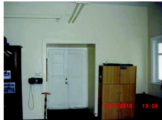
Şekil EK D.4 Z34 no'lu mekândan özgün ahşap tablalı kapı
