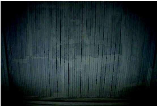
Şekil EK D.219 210 no'lu mekândan tuvali yok olmuş ahşap tavan görünüşü
