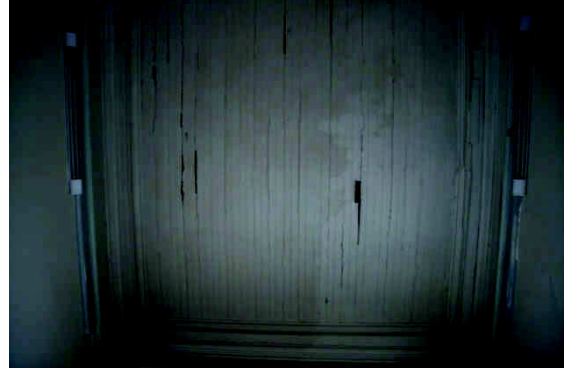
Şekil EK D.216 209 no'lu mekândan tuvali yok olmuş ahşap tavan görünüşü
