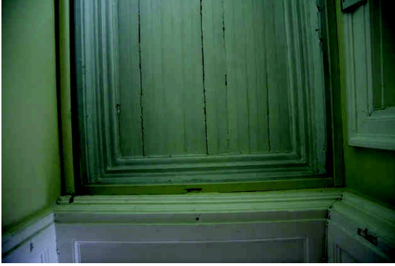
Şekil EK D.205 231 no'lu mekândan tuvali yok olmuş ahşap tavan görünüşü
