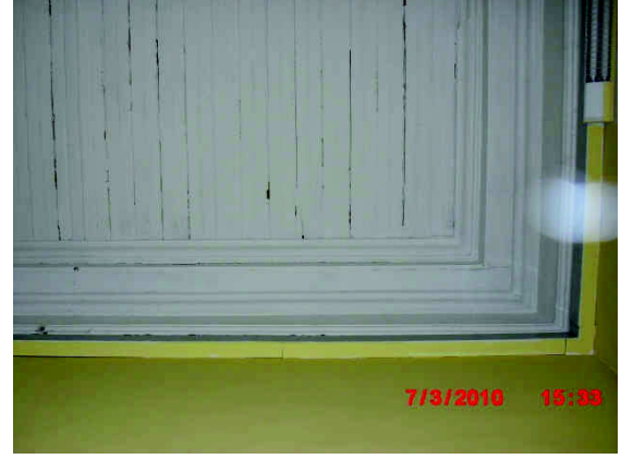
Şekil EK D.114 113 no'lu mekândan tuvali yok olmuş ahşap tavan görünüşü
