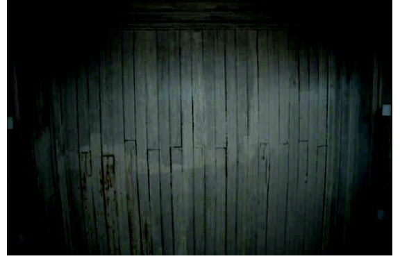
Şekil EK D.210 246 no'lu mekândan tuvali yok olmuş ahşap tavan görünüşü
