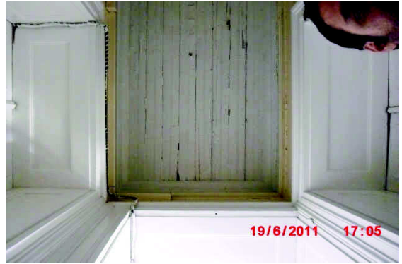
Şekil EK D.92 131 no'lu mekândan tuvali yok olmuş ahşap tavan görünüşü
