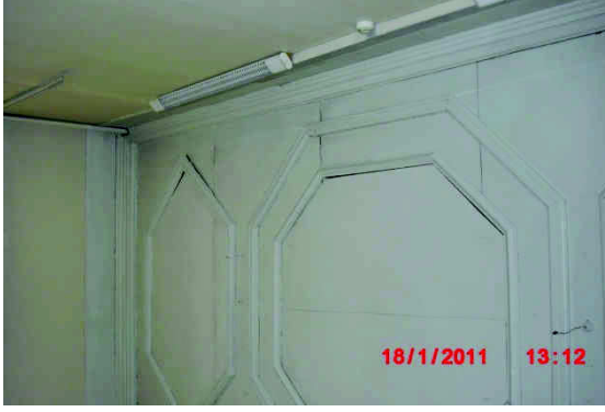
Şekil EK D.119 150 no'lu mekândan tuvali yok olmuş ahşap tavan görünüşü
