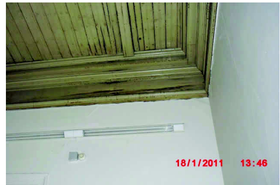
Şekil EK D.178 202 no'lu mekândan tuvali yok olmuş ahşap tavan görünüşü
