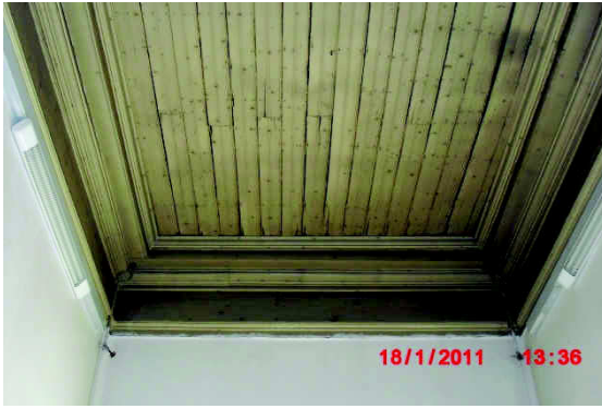
Şekil EK D.193 243 no'lu mekândan tuvali yok olmuş ahşap tavan görünüşü
