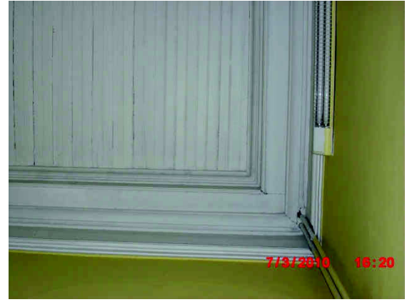
Şekil EK D.98 111 no'lu mekândan tuvali yok olmuş ahşap tavan görünüşü
