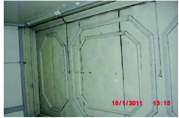
Şekil EK D.122 151 no'lu mekândan tuvali yok olmuş ahşap tavan görünüşü
