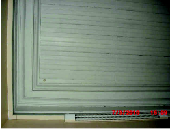
Şekil EK D.83 109 no'lu mekândan tuvali yok olmuş ahşap tavan görünüşü
