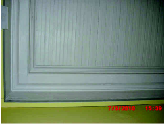
Şekil EK D.125 114 no'lu mekândan tuvali yok olmuş ahşap tavan görünüşü
