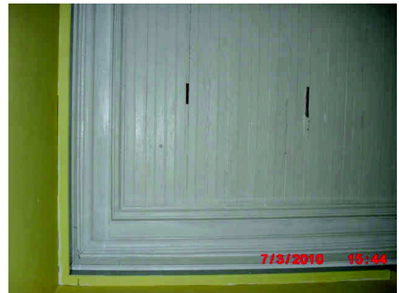
Şekil EK D.106 112 no'lu mekândan tuvali yok olmuş ahşap tavan görünüşü
