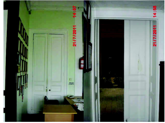
Şekil EK D.44 140 no'lu mekândan özgün ahşap tablalı çift kanatlı kapı görünüşü
