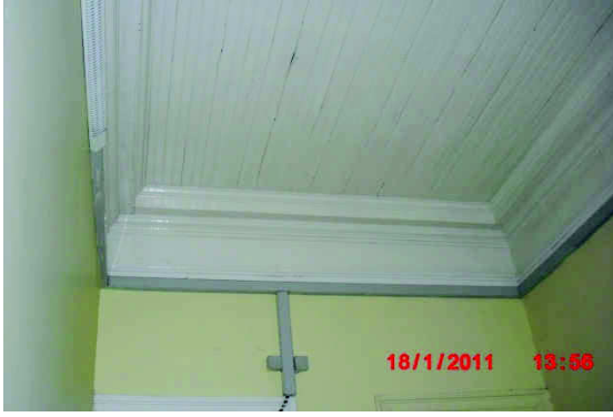
Şekil EK D.95 110 no'lu mekândan tuvali yok olmuş ahşap tavan görünüşü
