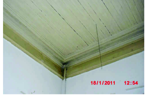
Şekil EK D.56 103 no'lu mekândan tuvali yok olmuş ahşap tavan görünüşü
