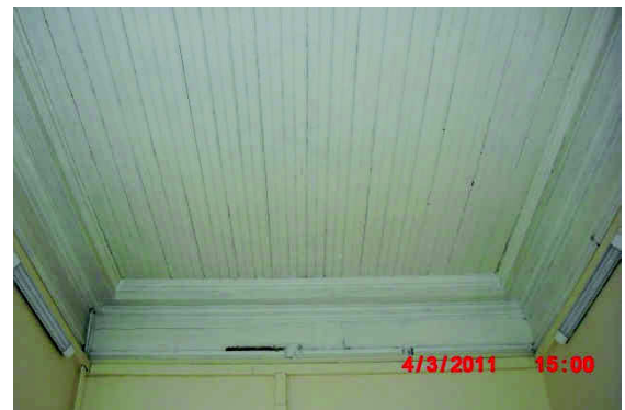
Şekil EK D.52 101 no'lu mekândan tuvali yok olmuş ahşap tavan görünüşü
