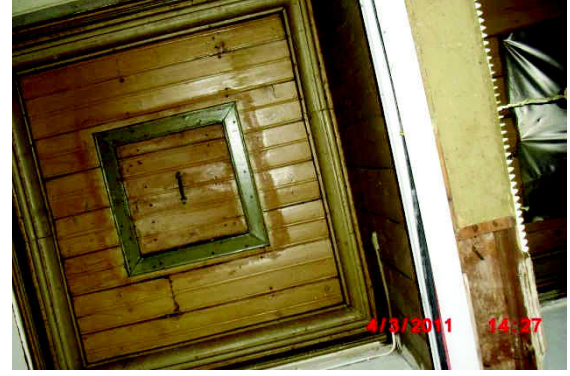
Şekil EK D.108 129 no'lu mekândan tuvali yok olmuş ahşap tavan görünüşü
