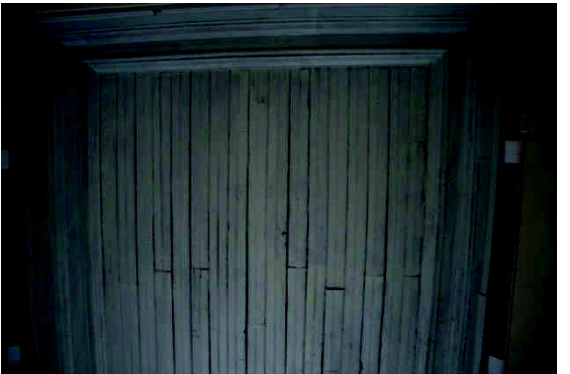
Şekil EK D.244 249 no'lu mekândan tuvali yok olmuş ahşap tavan görünüşü
