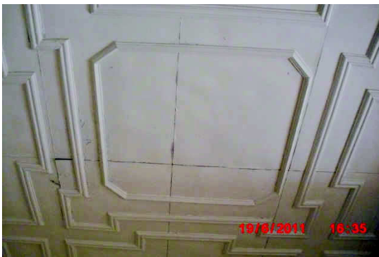
Şekil EK D.129 124 no'lu mekândan tuvali yok olmuş ahşap tavan görünüşü
