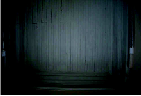
Şekil EK D.241 248 no'lu mekândan tuvali yok olmuş ahşap tavan görünüşü
