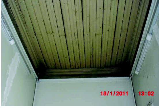
Şekil EK D.71 145 no'lu mekândan tuvali yok olmuş ahşap tavan görünüşü
