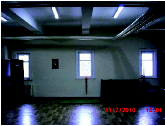
Şekil EK D.1 Z33 no'lu mekânda betonarme kirişlerin görünüşü
