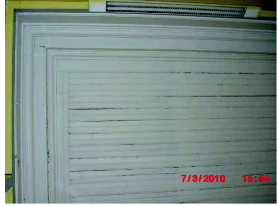
Şekil EK D.90 148 no'lu mekândan tuvali yok olmuş ahşap tavan görünüşü
