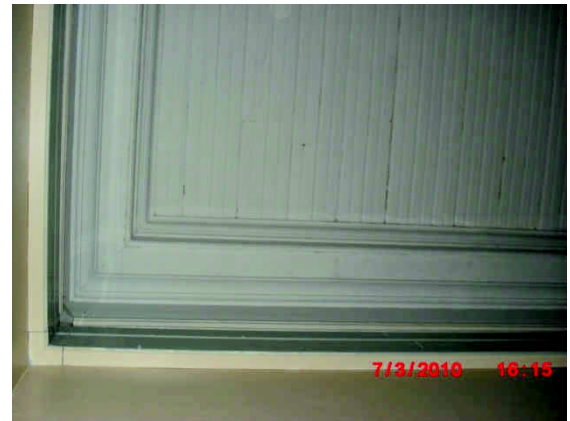
Şekil EK D.76 108 no'lu mekândan tuvali yok olmuş ahşap tavan görünüşü
