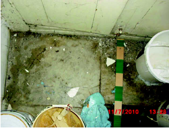
Şekil EK D.11 Z30 no'lu mekândan özgün mermer kaplama
