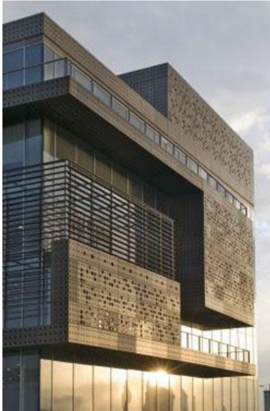
Şekil 3. 17 Tabanlıoğlu Mimarlık, Doğan Medya ofis binası, Ankara
