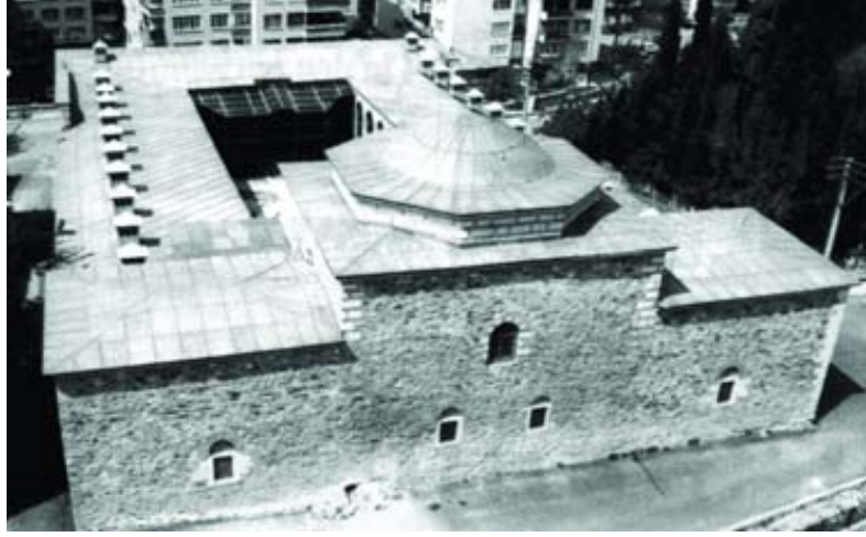
Şekil 4.14 Bursa Yıldırım Darüşşifası [91]
