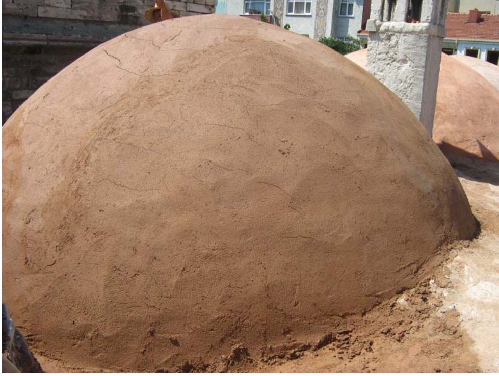
Şekil 7.21 Kubbelere çamur sıva yapılma işlemi, 2010
