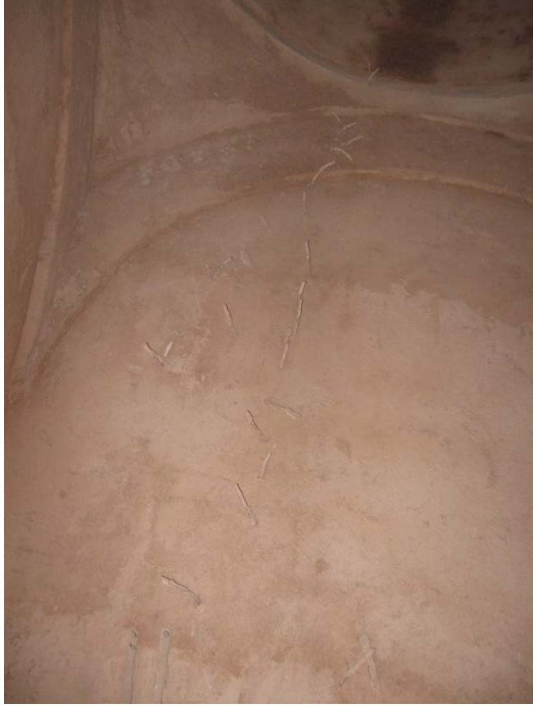
Şekil 7.2 Duvar içi enjeksiyon hortumları, 2011
