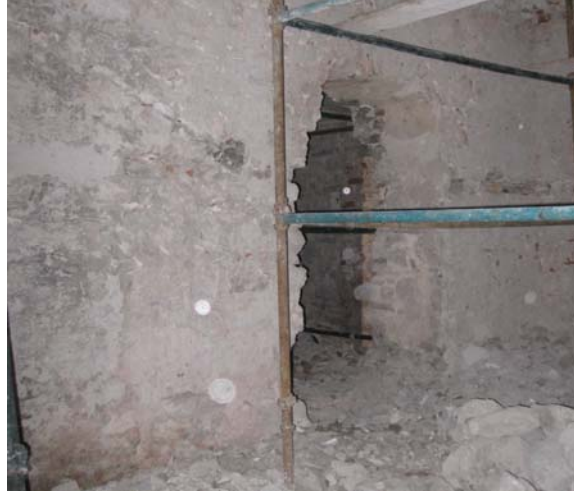
Şekil 7.10 Kapatılan kapıların yeniden açılması, 2010
