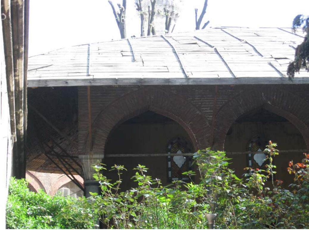
Şekil 3.68 Sıbyan mektebi çatısı, 2010
