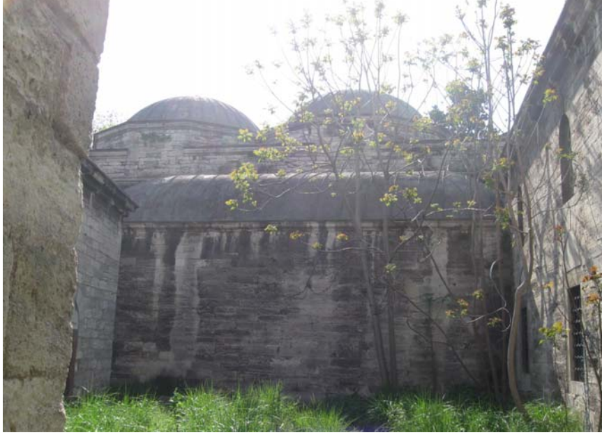
Şekil 5.69 Kazan dairesi batı cephesi, 2010
