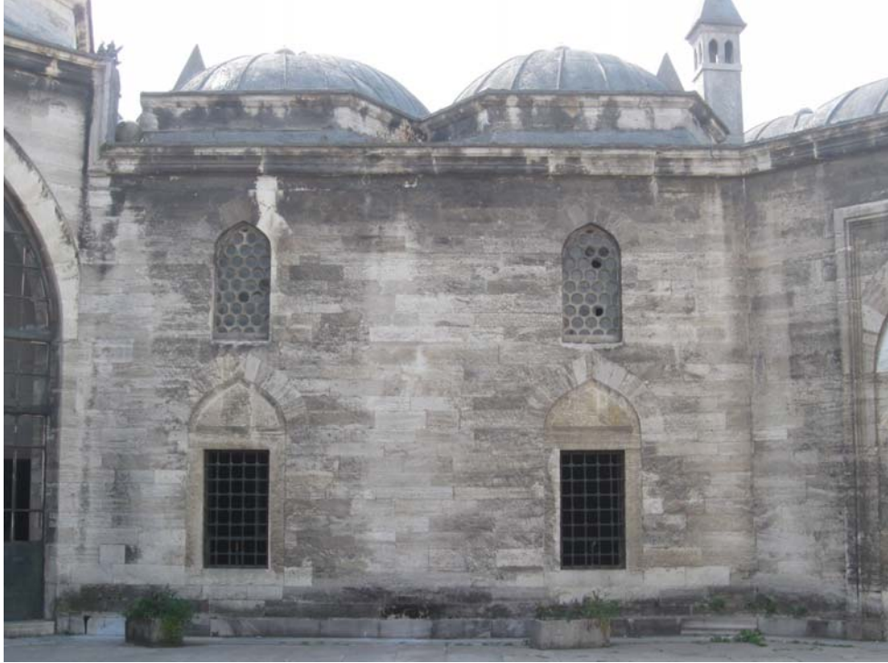
Şekil 5.20 Avlu batı cephesi, 2010
