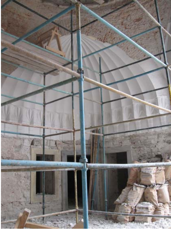
Şekil 7.11 Muhdes zemin kaplamalarının sökülmesi, 2010
