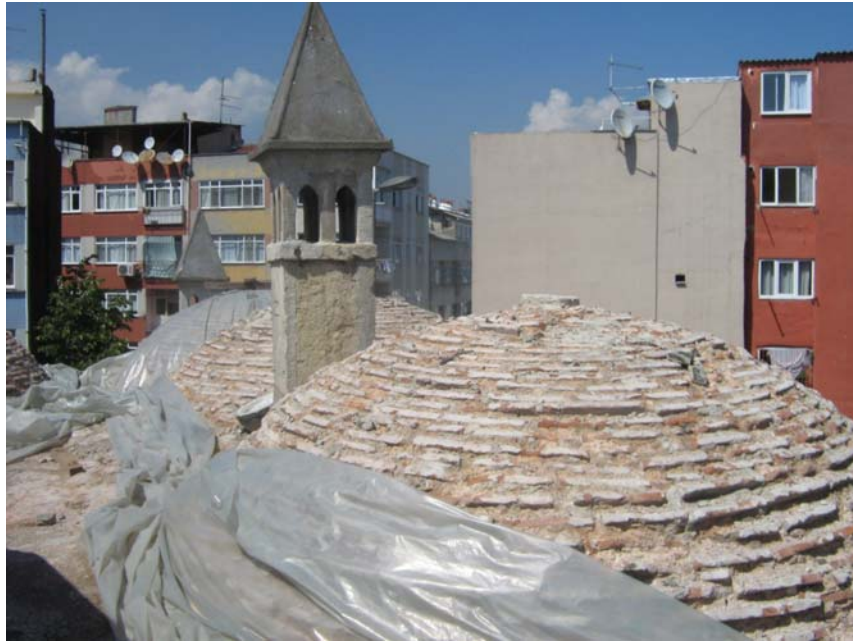
Şekil 7.4 Üst örtüde çimento raspası, 2010
