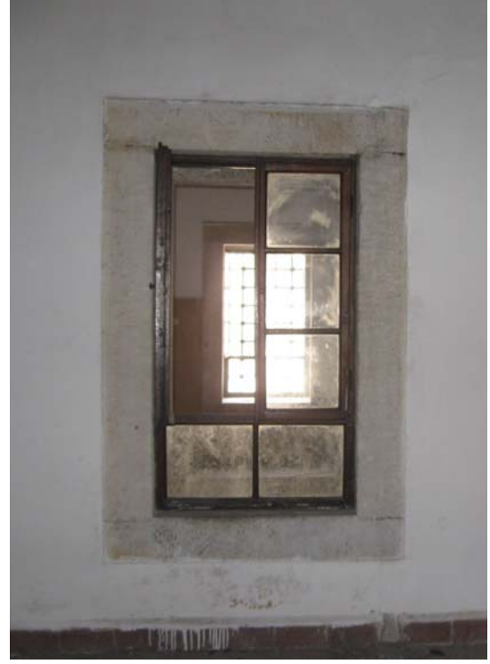
Şekil 5.53 Z-09 nolu oda ara pencere
