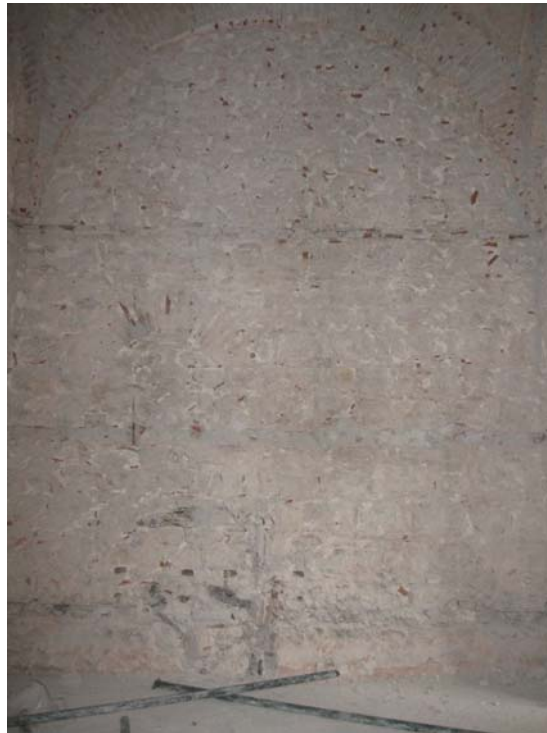
Şekil 5.77 Ahşap hatıllı yığma duvar, 2010
