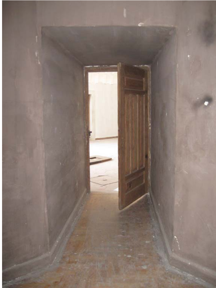
Şekil 5.59 Z-17 nolu oda giriş koridoru, 2011
