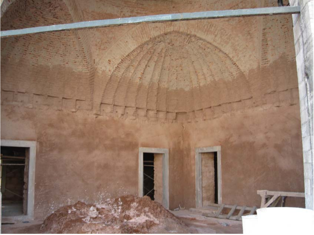
Şekil 7.16 Duvar iç yüzeylerinin özgün harç ile sıvanması, 2011
