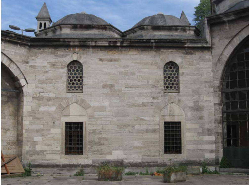
Şekil 5.21 Avlu doğu cephesi, 2010
