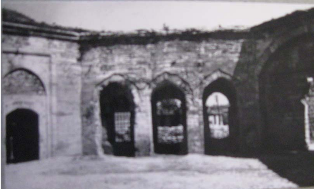
Şekil 5.18 Avlu kuzey cephesinde bulunan nişler, 1927 [75]
