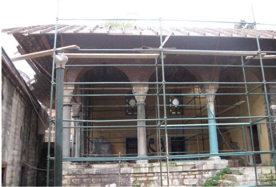
Şekil 3.19 Restorasyon çalışmaları-Sıbyan Mektebi, 2010
