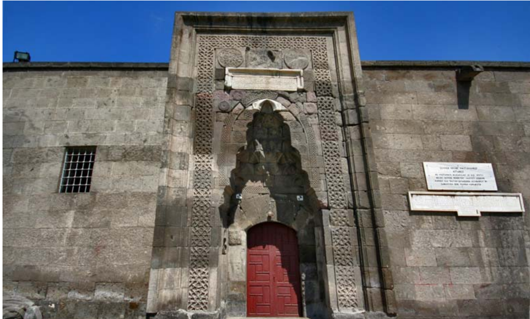
Şekil 4.13 Kayseri Gevher Nesibe Darü'sşifası-Taç kapı [87]
