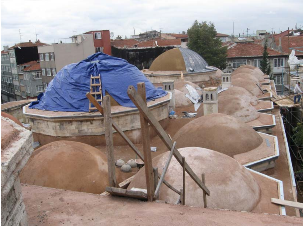
Şekil 7.23 Üst örtüye kurşun kaplama işlemi, 2010
