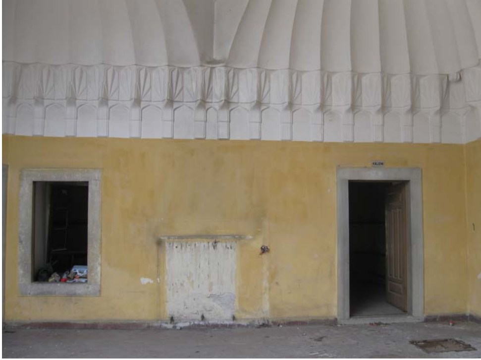
Şekil 5.28 Z-07 nolu eyvan güney duvarı, 2010
