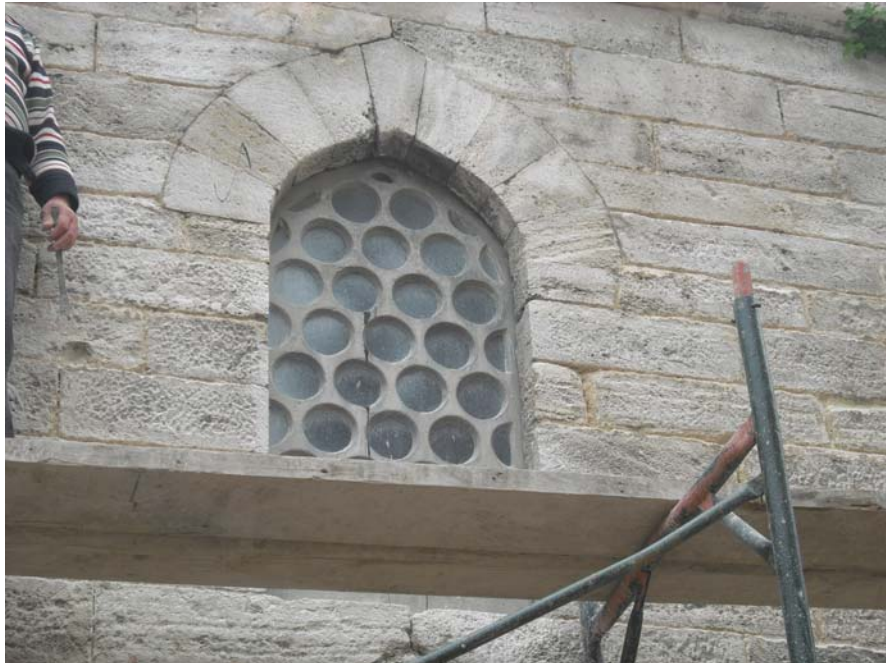
Şekil 7.19 Hasar gören kemer taşlarının değiştirilmesi, 2011
