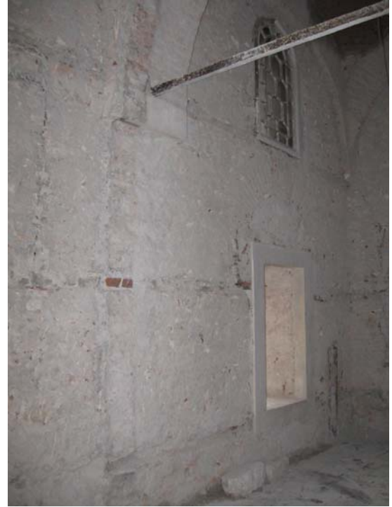
Şekil 7.9 Muhdes duvarın yıkılması, 2010
