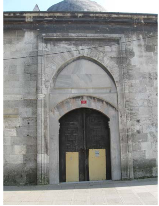
Şekil 5.132 Yol kotunun yükselmesi, 2010
