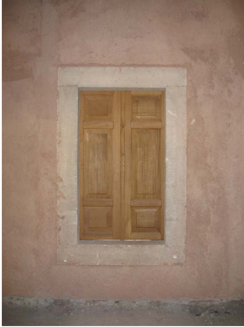
Şekil 7.26 Yeniden üretilen ahşap kapaklar, 2011
