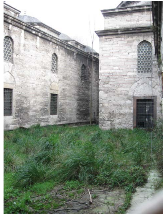
Şekil 5.94 Haseki Darüşşifası güney cephesi, 2010
