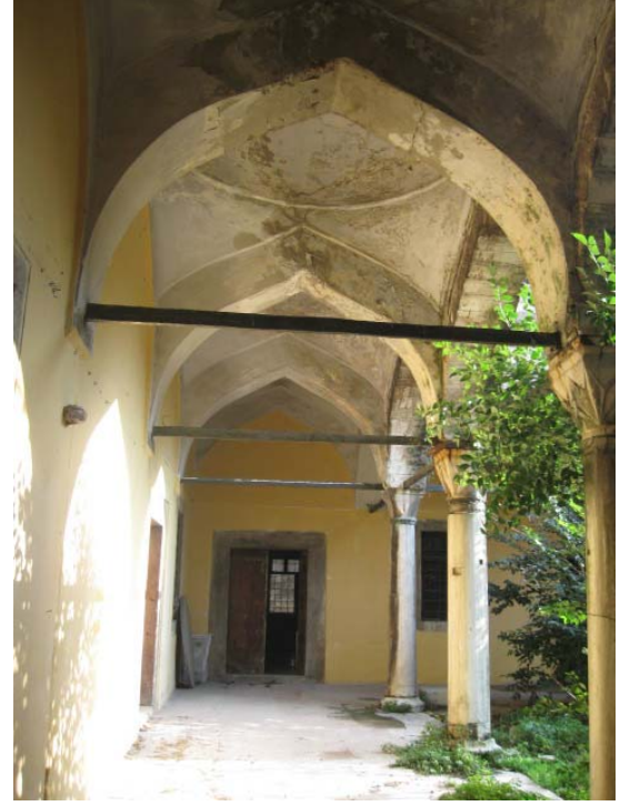
Şekil 3.53 Kuzey aksı revaklar-imaret, 2010
