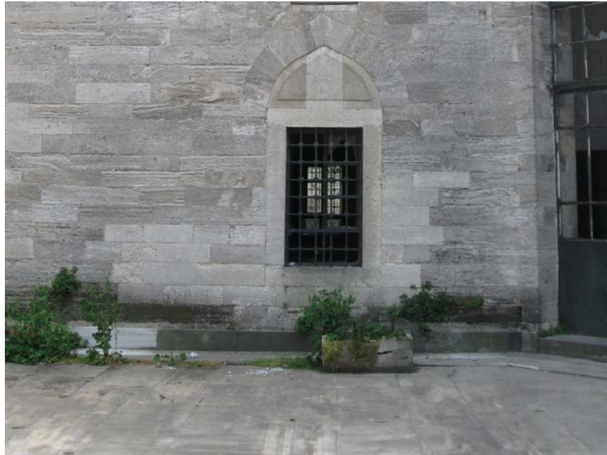
Şekil 5.110 Cephede çiçeklenme sorunu, 2010
