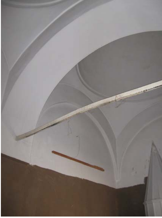
Şekil 5.107 Gergi demirinde eğrilme, 2010 Şekil 5.108 Kemer taşlarında kayma, 2010
