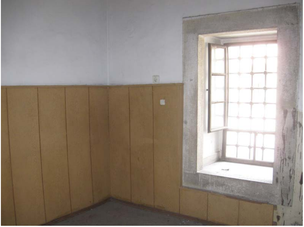
Şekil 5.44 Z-10 nolu mekan, 2010
