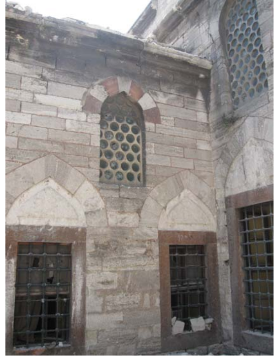
Şekil 3.35 Kemer taşları ve söveler, 2010
