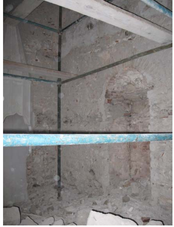
Şekil 7.7 Kapatılan nişlerin açılması, 2010
