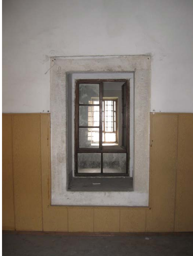
Şekil 5.45 Z-10 nolu mekan, 2010
