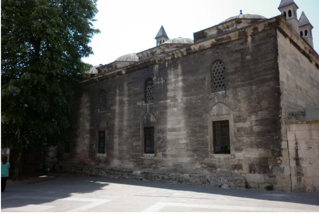
Şekil 5.91 Haseki Darüşşifası doğu cephesi, 2010
