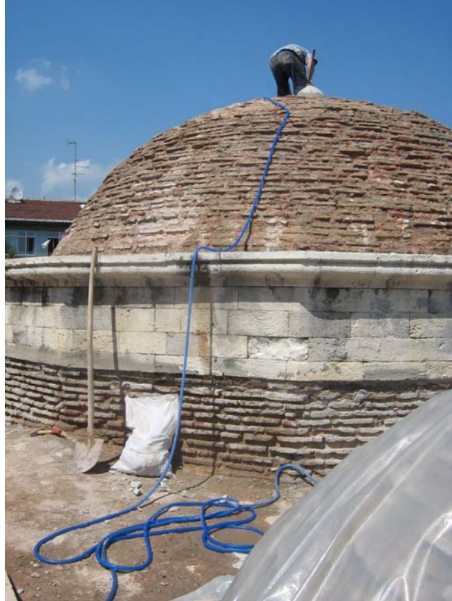
Şekil 7.20 Derz aralarının temizlenmesi, 2010
