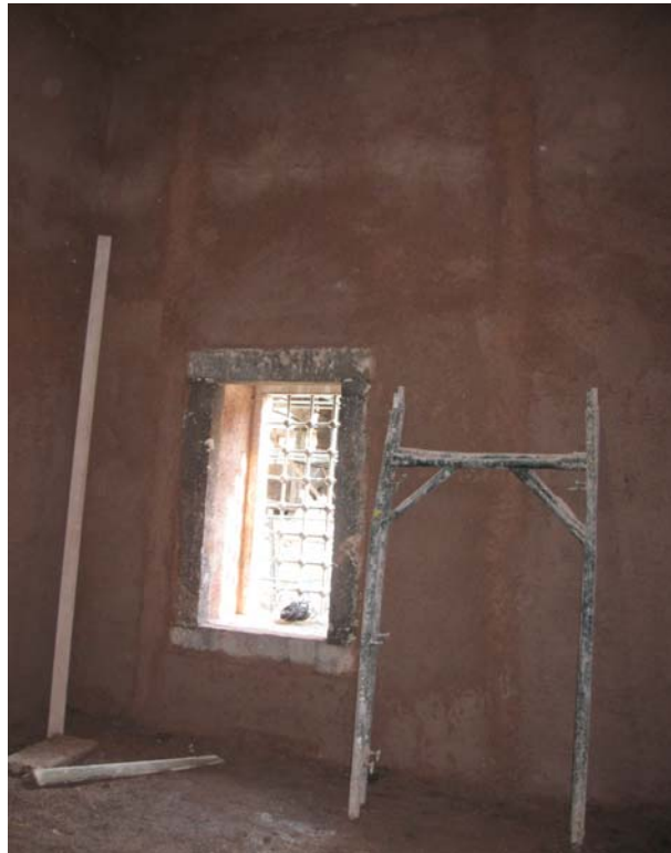
Şekil 7.17 Duvar iç yüzeylerinin özgün harç ile sıvanması, 2011
