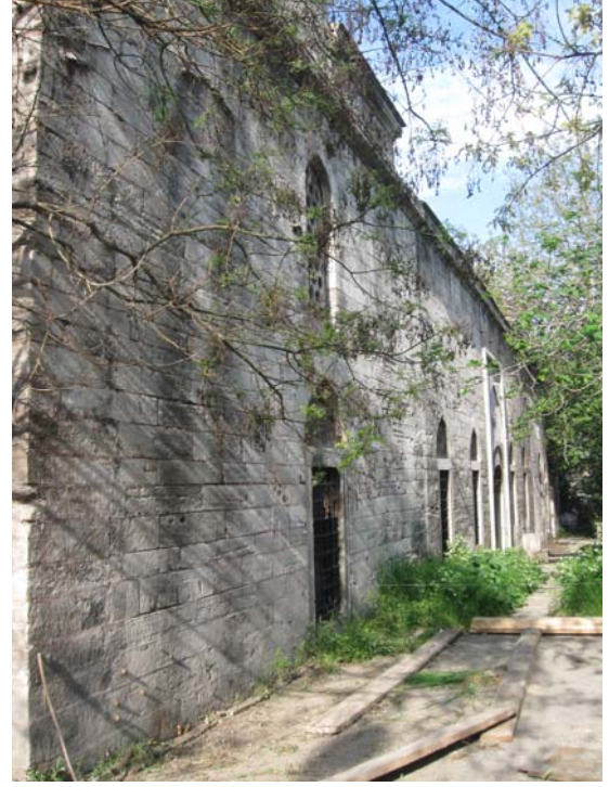
Şekil 3.59 İmaret güney cephesi, 2010
