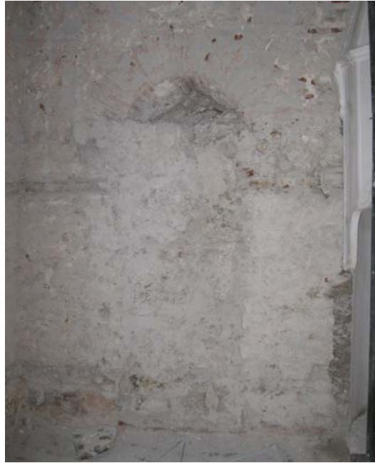
Şekil 5.129 Kapatılan niş örneği, 2010
