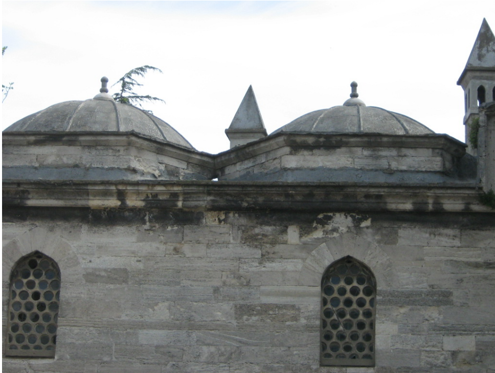
Şekil 5.82 Beton dışlıklar, 2010
