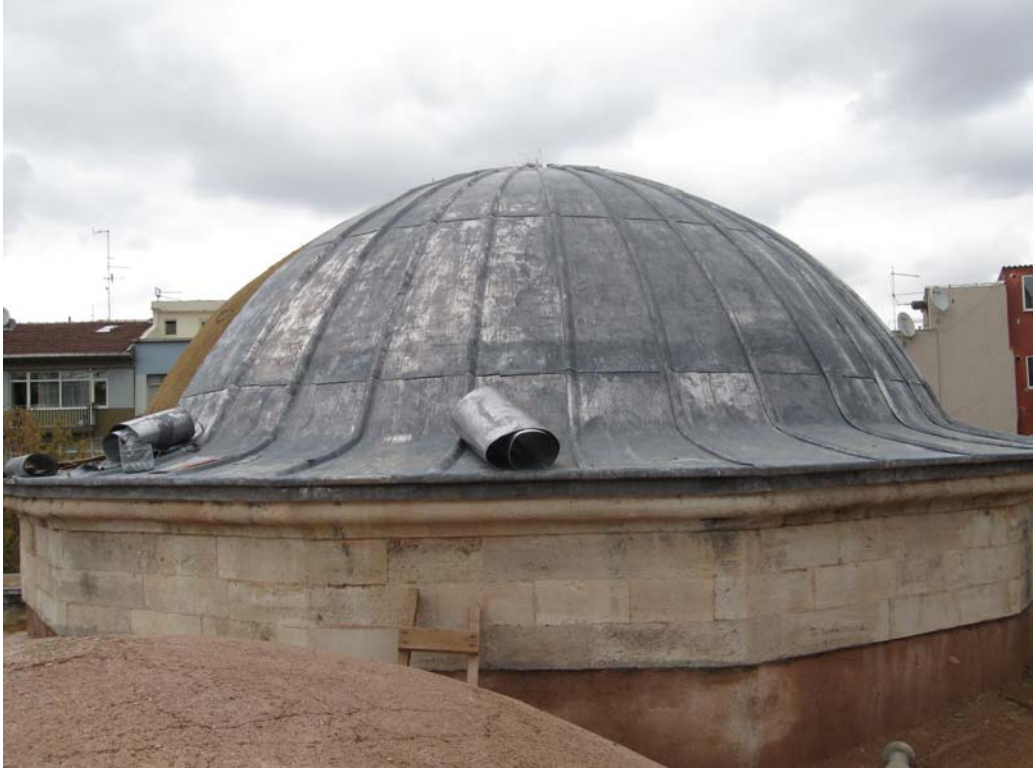
Şekil 7.25 Üst örtüye kurşun kaplama işlemi, 2010
