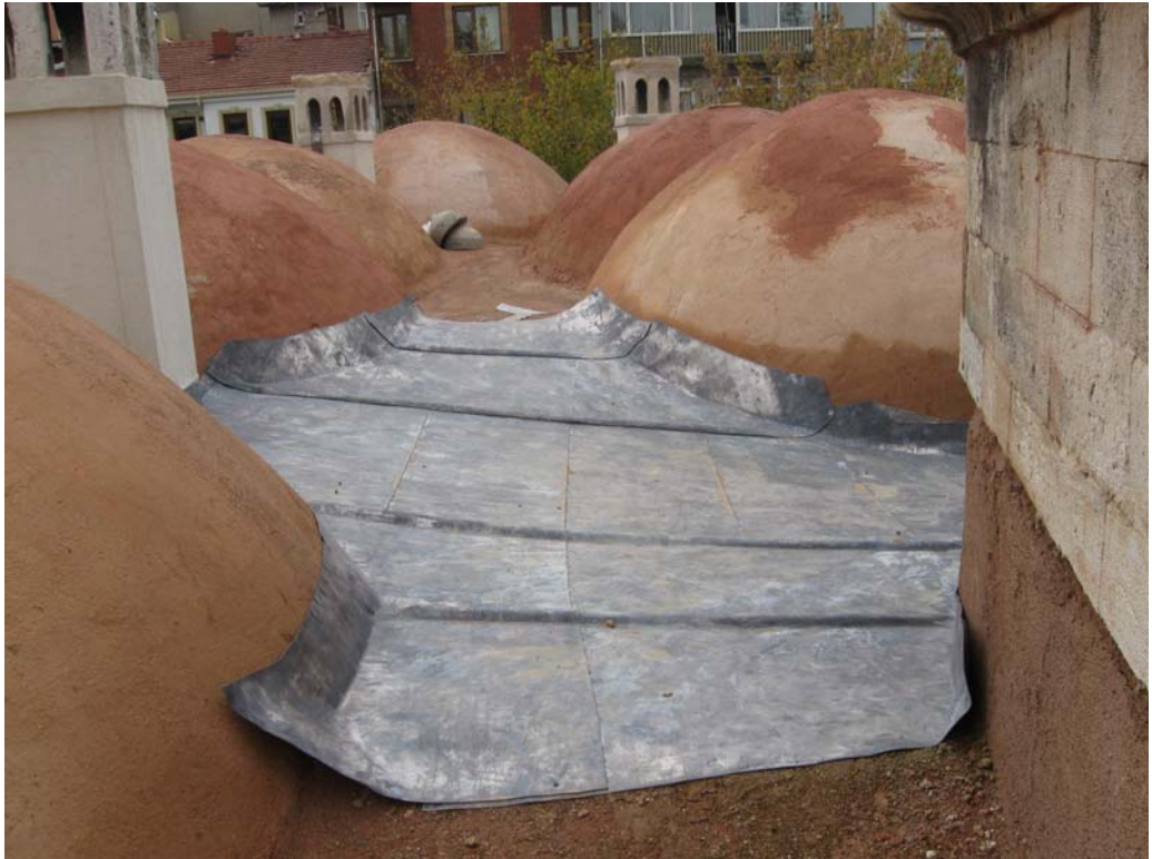
Şekil 7.24 Üst örtüye kurşun kaplama işlemi, 2010
