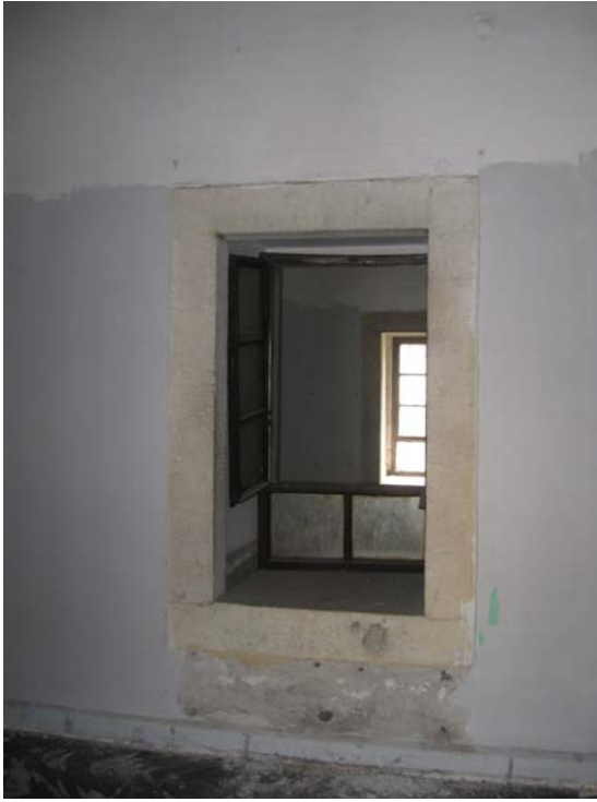
Şekil 5.46 Z-11 nolu mekan, 2010
