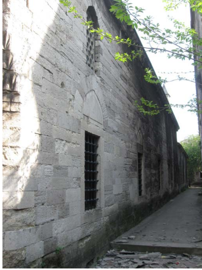
Şekil 5.96 Haseki Darüşşifası batı cephesi, 2010
