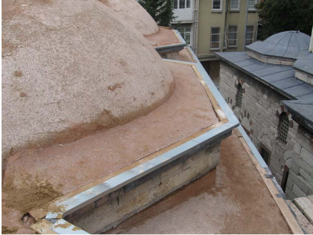
Şekil 7.22 Kaskak etrafına ahşap hatıl dönülmesi, 2010
