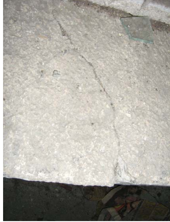
Şekil 5.114 Sövede kırılma, 2010
