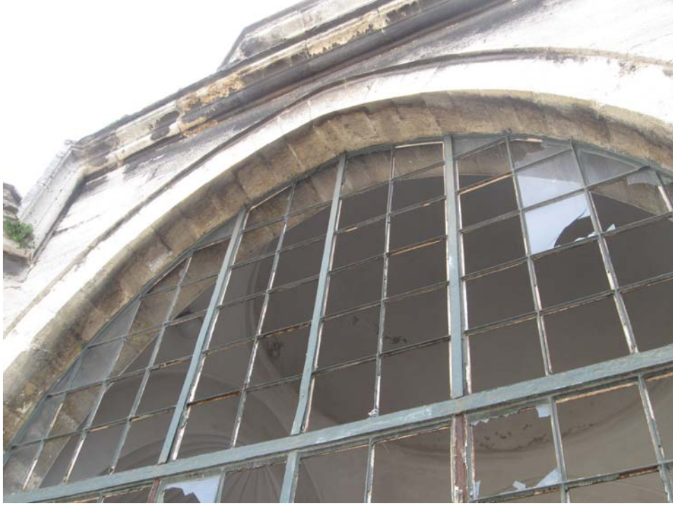
Şekil 5.74 Z-07 nolu eyvanda bulunan kemer, 2010
