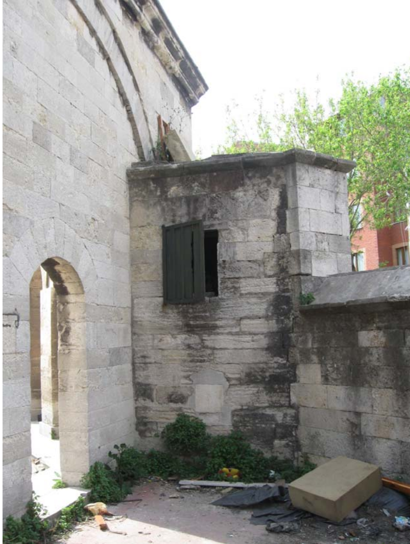
Şekil 5.65 Kademeli ihata duvarı ve su depose, 2010
