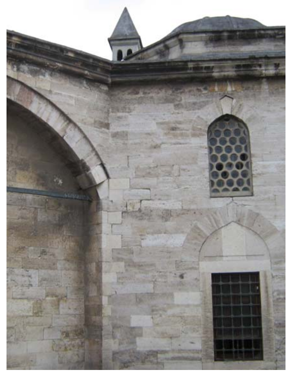
Şekil 5.107 Gergi demirinde eğrilme, 2010 Şekil 5.108 Kemer taşlarında kayma, 2010
