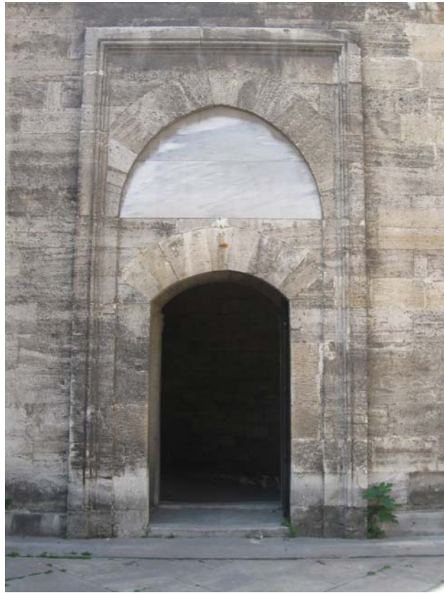
Şekil 5.16 Giriş kapısı-Avlu cephesi, 2010
