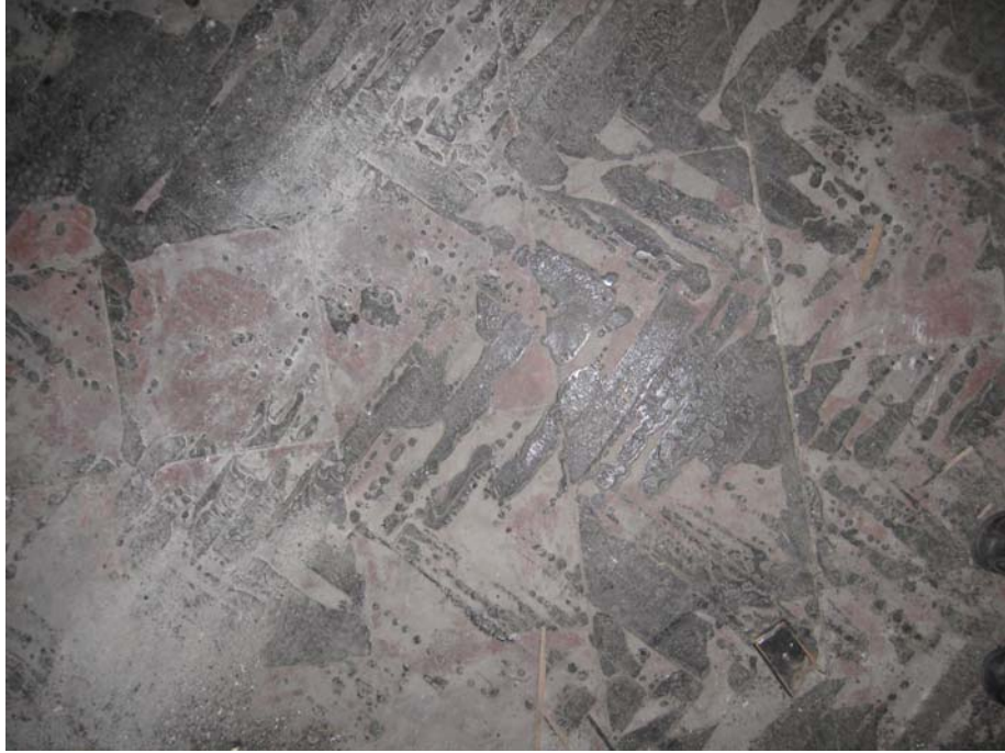
Şekil 5.58 Z-16 nolu oda döşeme kaplaması, 2011
