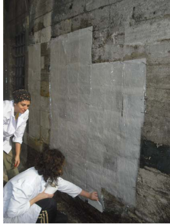
Şekil 7.15 AB 57 ile kimyasal temizlik işlemi, 2011
