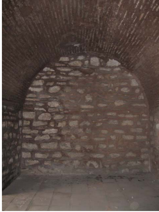
Şekil 3.49 Üst katta bulunan tonozlu mekan-hamurluk, 2010
