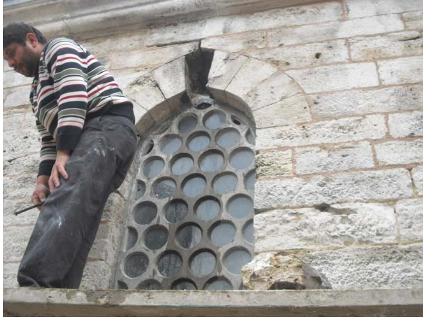
Şekil 7.18 Hasar gören kemer taşlarının değiştirilmesi, 2011
