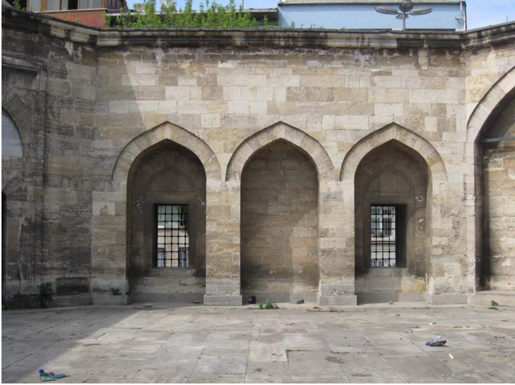
Şekil 5.17 Avlu kuzey cephesinde bulunan nişler, 2010
