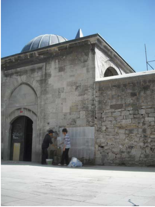
Şekil 7.14 AB 57 ile kimyasal temizlik işlemi, 2011
