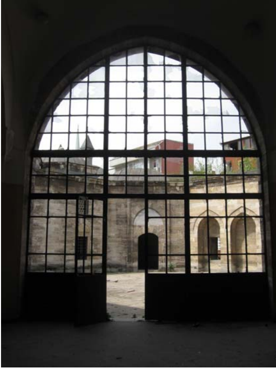
Şekil 5.122 Muhdes demir doğrama, 2010
