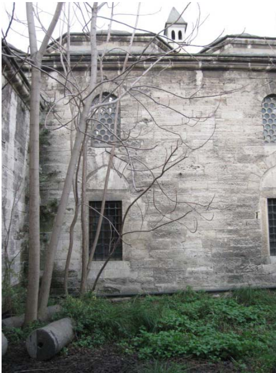
Şekil 5.93 Haseki Darüşşifası güney cephesi, 2010
