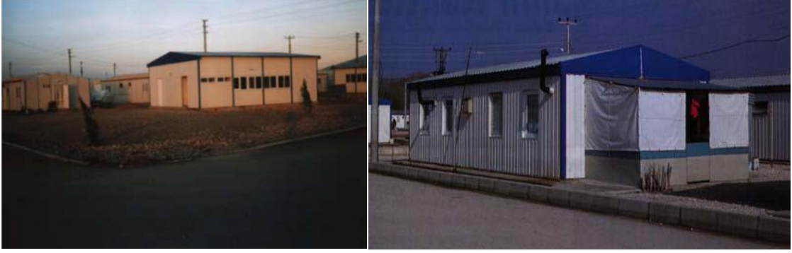
Şekil 2.9 Marmara depremi sonrasında üretilen Bayındırlık ve İskân Bakanlığı'nın geçici konutlar [10] (solda) Şekil 2.10 Marmara depremi sonrası devlet tarafından yapılan geçici iskân biriminin dış mekânından görünüm [10] (sağda)
