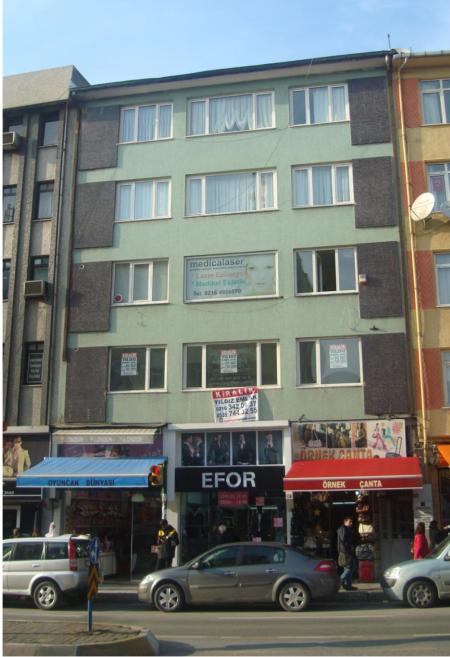
Şekil 7. 1 Selman-i Pak Caddesi 1318 numaralı adadaki 4. binanın belediye uygulaması öncesi durumu [17]
