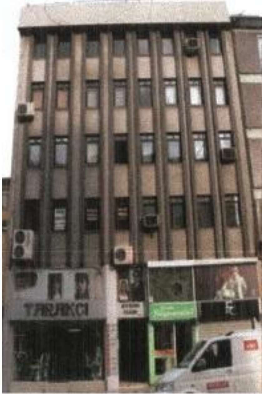
Şekil 7. 9 Selman-i Pak Caddesi 1318 numaralı adadaki 3. binanın belediye uygulaması öncesi durumu [17]
