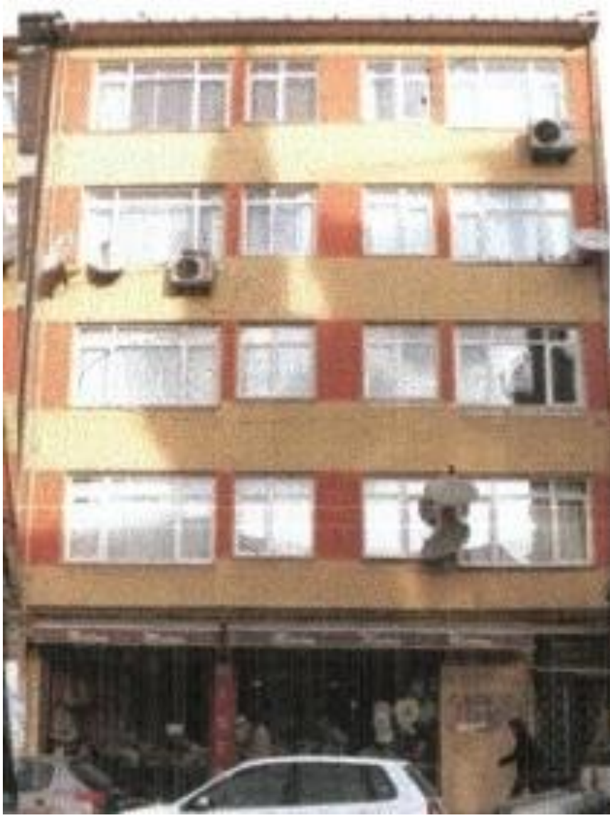
Şekil 7.14 Selman-i Pak Caddesi 1318 numaralı adadaki 5. binanın belediye uygulaması sonrası durumu [17]
