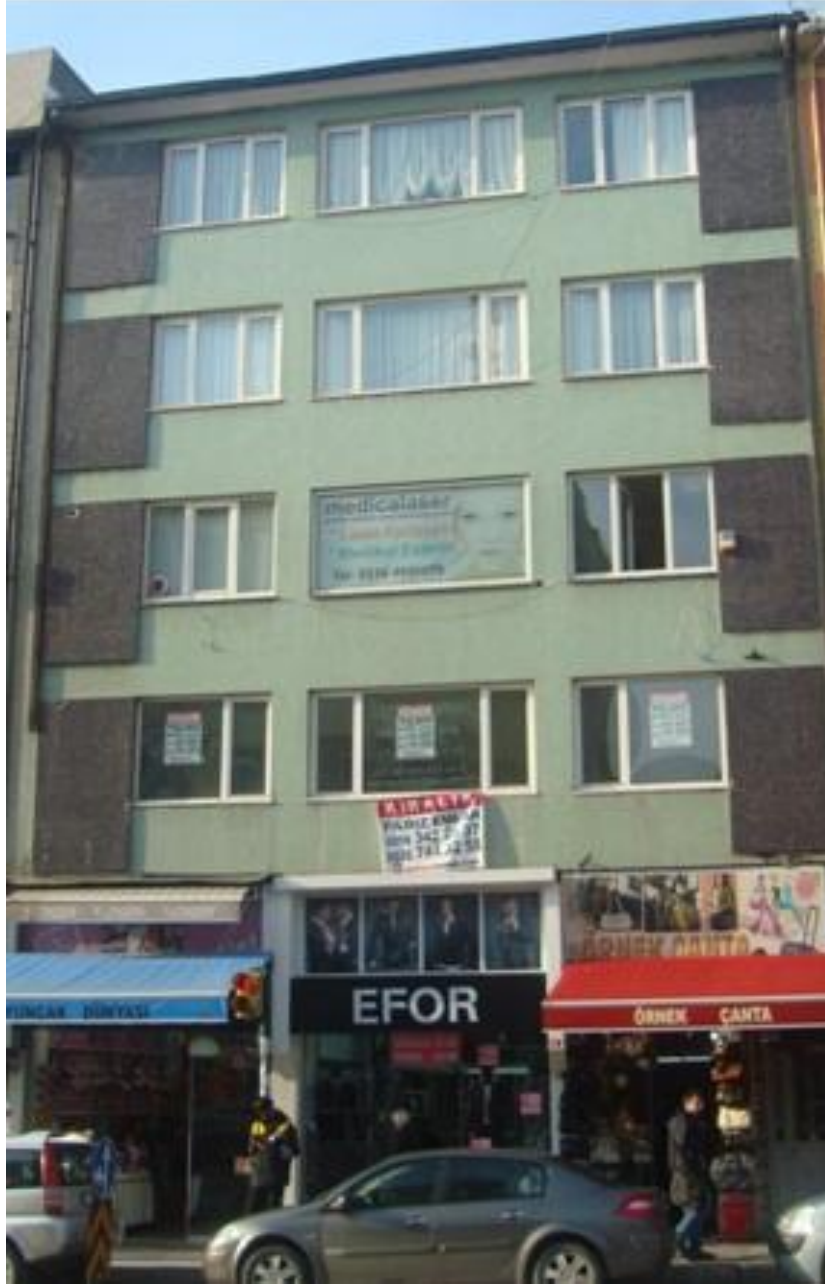
Şekil 7.12 Selman-i Pak Caddesi 1318 numaralı adadaki 4. binanın belediye uygulaması sonrası durumu [17]
