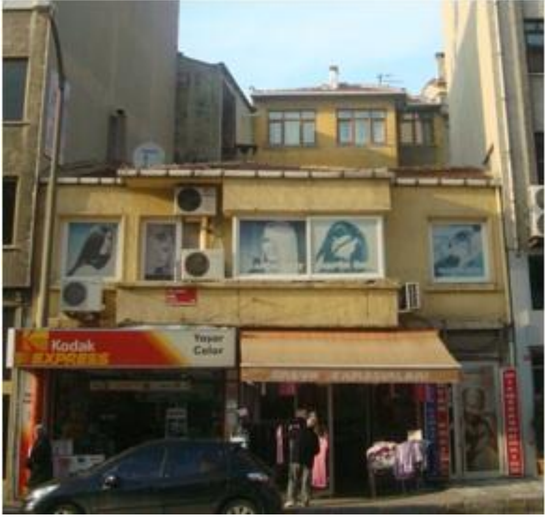
Şekil 7. 7 Selman-i Pak Caddesi 1318 numaralı adadaki 2. binanın belediye uygulaması öncesi durumu [17]
