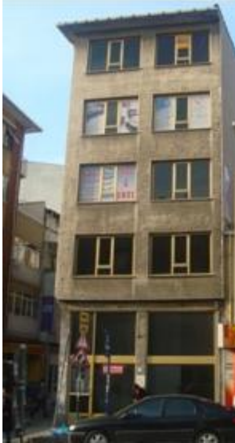
Şekil 7. 5 Selman-i Pak Caddesi 1318 numaralı adadaki 1. binanın belediye uygulaması öncesi durumu [17]
