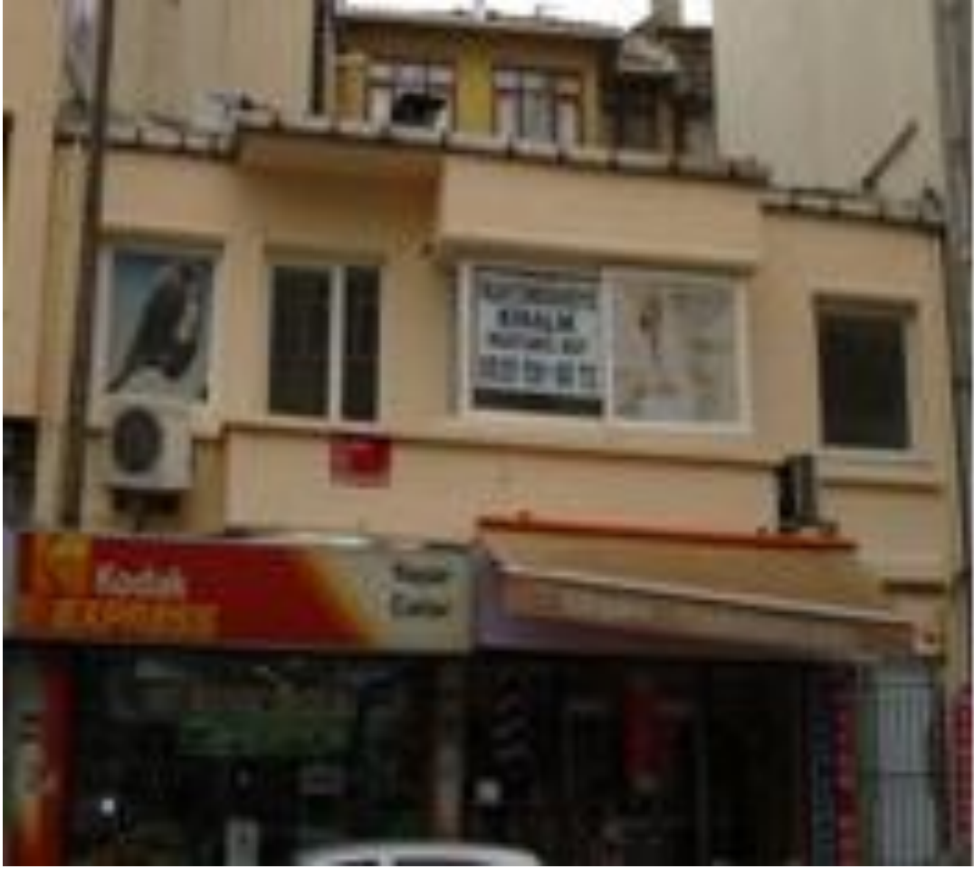
Şekil 7. 8 Selman-i Pak Caddesi 1318 numaralı adadaki 2. binanın belediye uygulaması sonrası durumu [17]
