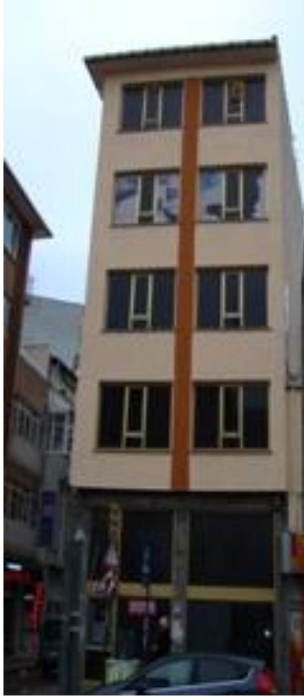
Şekil 7. 6 Selman-i Pak Caddesi 1318 numaralı adadaki 1. binanın belediye uygulaması sonrası durumu [17]
