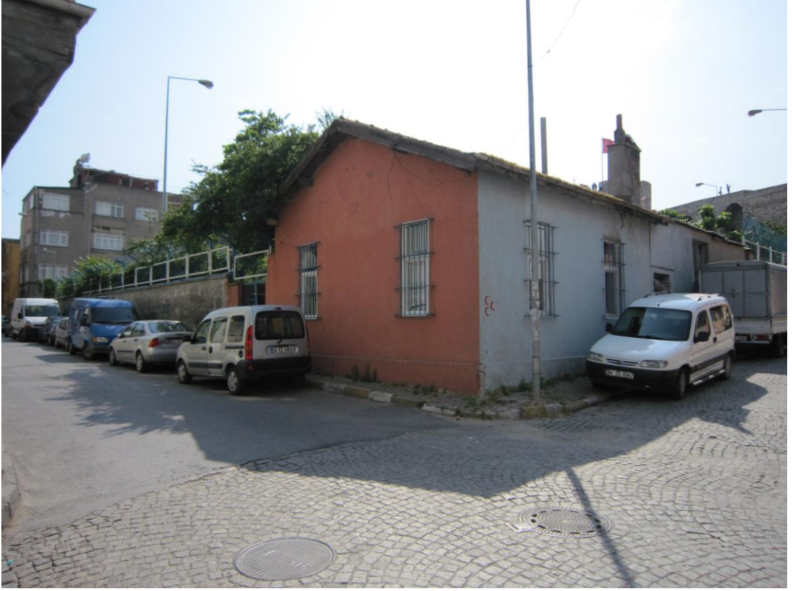
Şekil 4. 3 Sarnıcın doğu duvarı ve lojman binası (2010)
