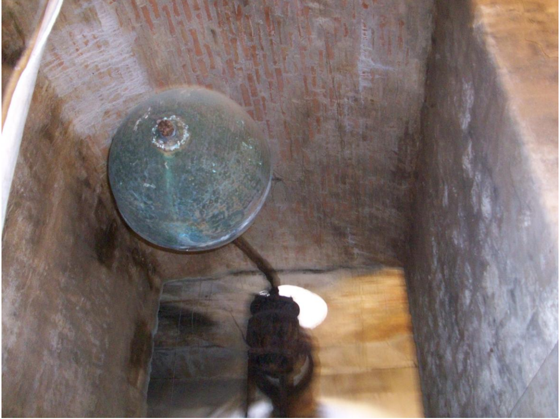
Şekil 4. 83 Su geliş borusuna takılan şamandıra (2010)
