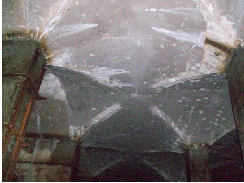
Şekil 3. 17 Feriköy Sarnıcı'nın çapraz tonoz çatı örtüsü (2010)
