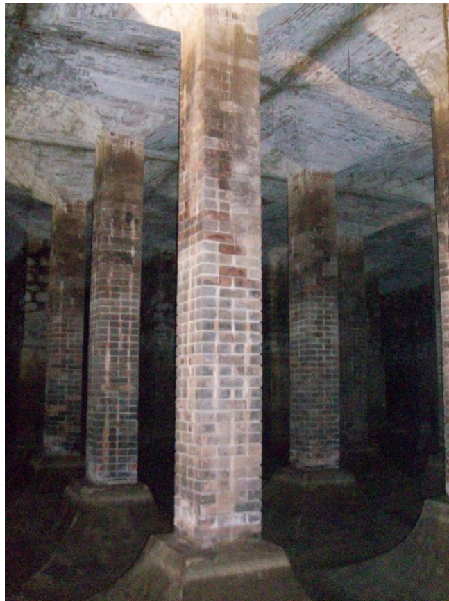
Şekil 5. 13 Ayakların tuğla malzemesinde görülen renk farklılıkları (2010)
