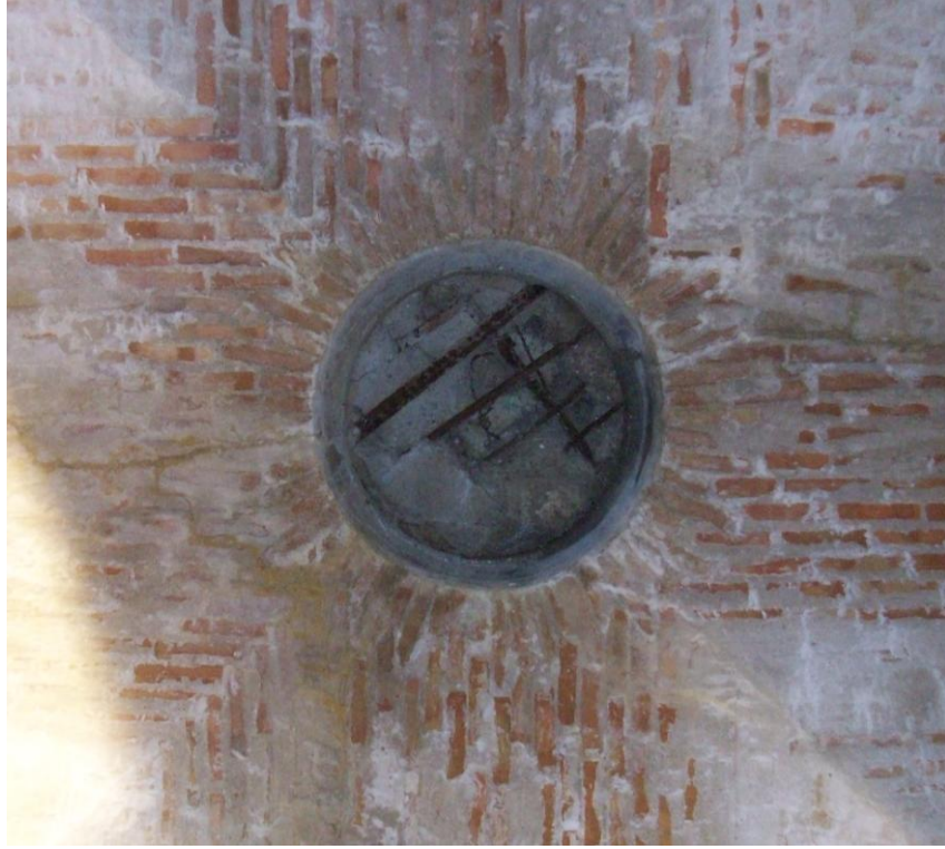
Şekil 4. 78 Bacaların çevresinde kılıcına yerleştirilmiş tuğlalar (2010)
