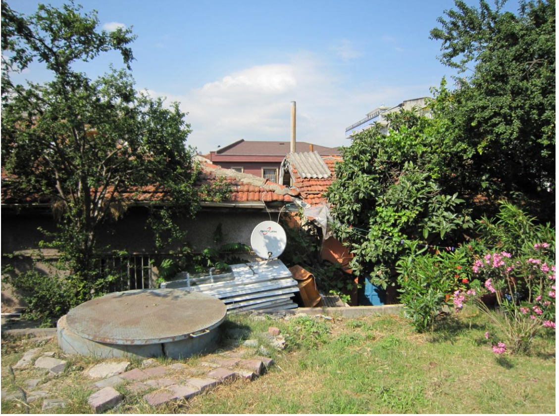
Şekil 4. 88 Ek binanın ve personel binasının sarnıcın üzerinden görünüşü (2010)
