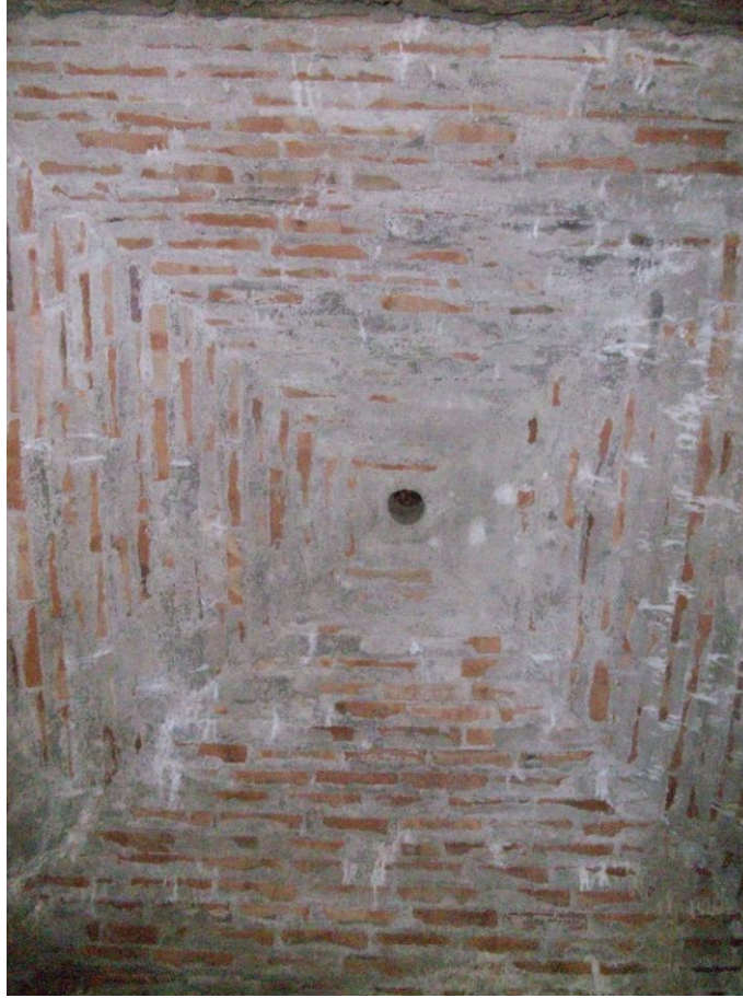
Şekil 4. 45 Dolu savakların çapraz tonoz çatı örtüsü ve havalandırma kanalı (2010)
