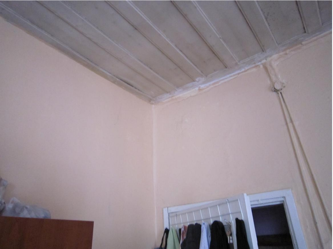
Şekil 4. 108 Ek bina yatak odası tavanının ahşap kaplaması (2010)
