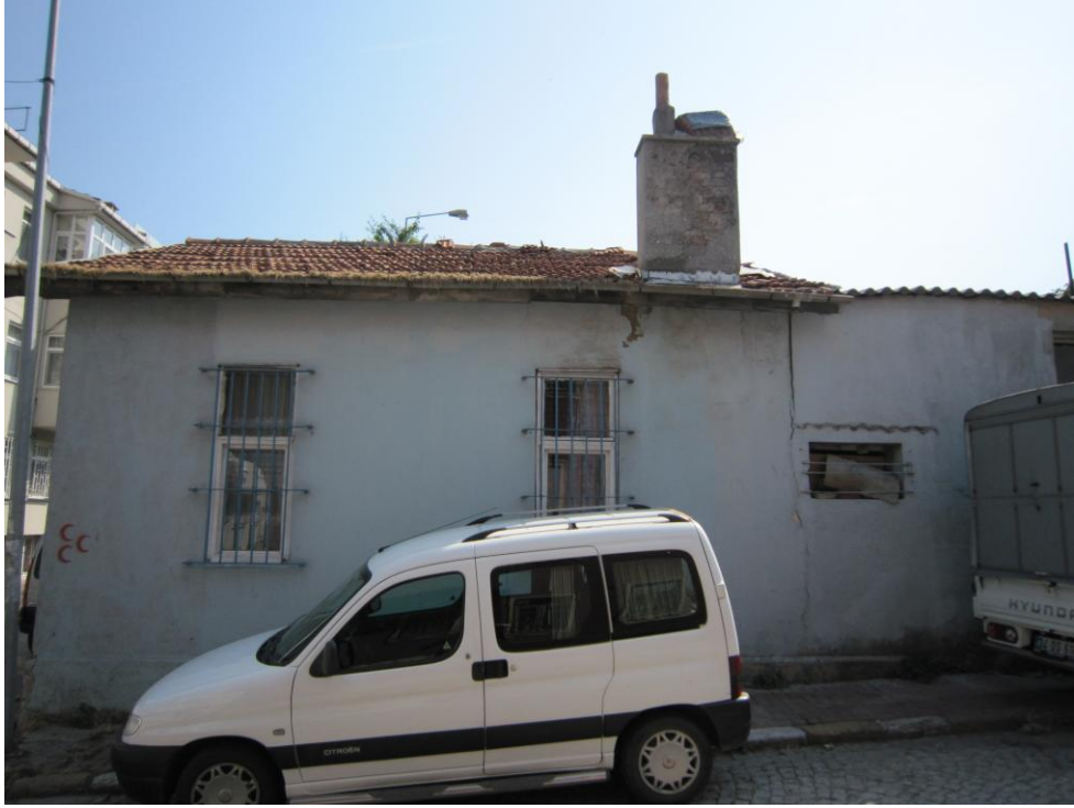
Şekil 4. 115 Ek binanın kuzey cephesinin görünüşü (2010)
