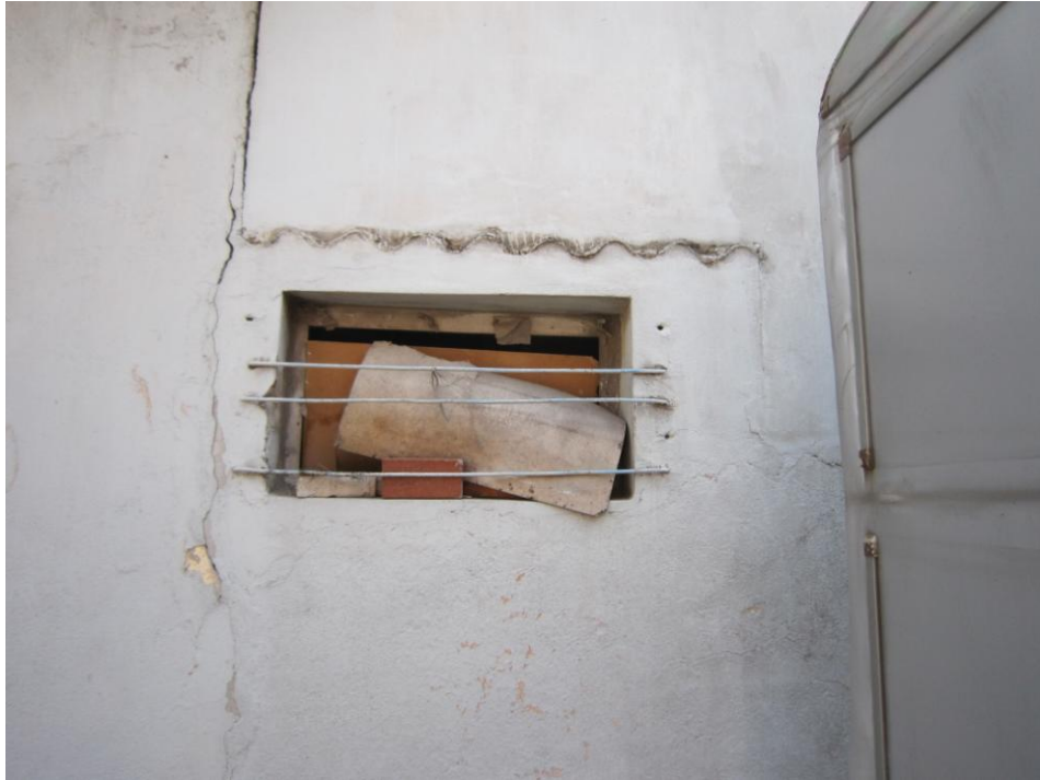
Şekil 4. 116 Kuzey cephesindeki oluklu çatı örtüsünün ve hela penceresinin görünüşü (2010)
