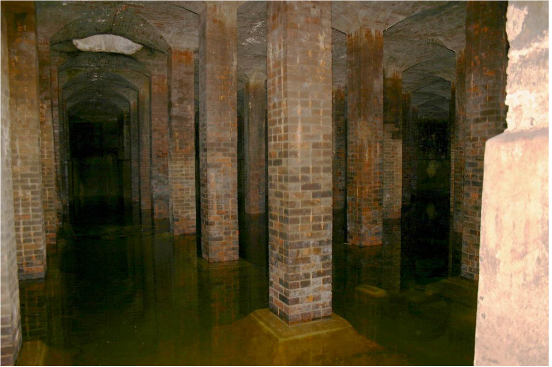
Şekil 4. 13 Tuğla malzemeli kare planlı ayaklar (İSKİ Vakıf Sular İdaresi Fotoğraf Arşivi, 2006)
