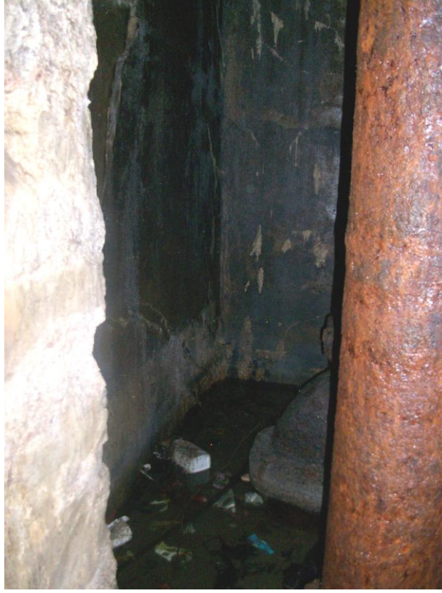
Şekil 4. 64 Vana mahallinin batı ve güney duvarlarının birleşimi (2010)
