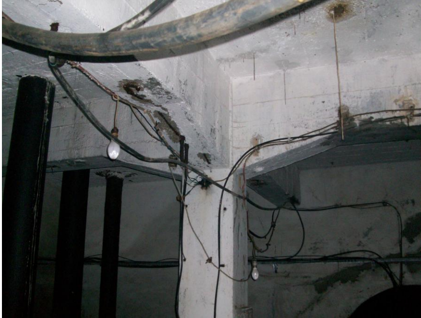
Şekil 3. 29 Vana mahallinin betonarme kolon ve kirişleri (2010)
