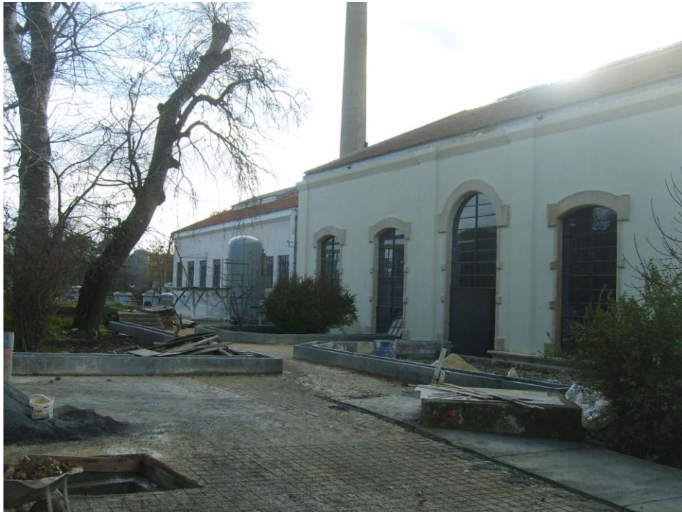
Şekil 3. 2 Terkos Su Pompa İstasyonu'nun görünüşü (2010)
