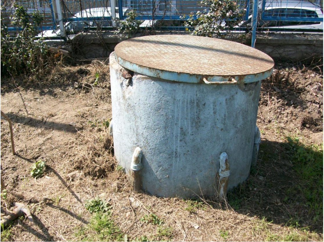
Şekil 4. 52 Metal kapakla kapatılmış B5 bacası (2010)
