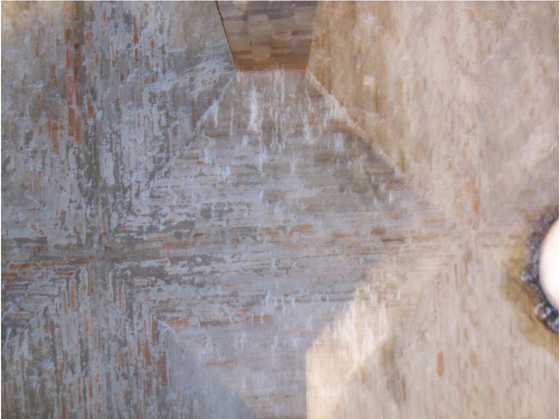
Şekil 4. 77 Yüzeyi kaplanmış tavan tuğlaları (2010)
