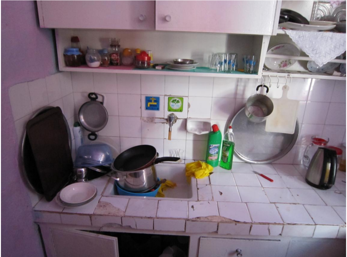
Şekil 4. 105 Ek bina mutfağındaki muhdes tezgahı (2010)
