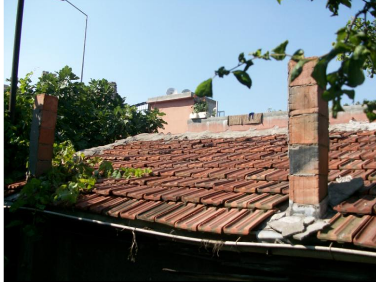
Şekil 4. 117 Ek bina çatısının görünüşü (2010)
