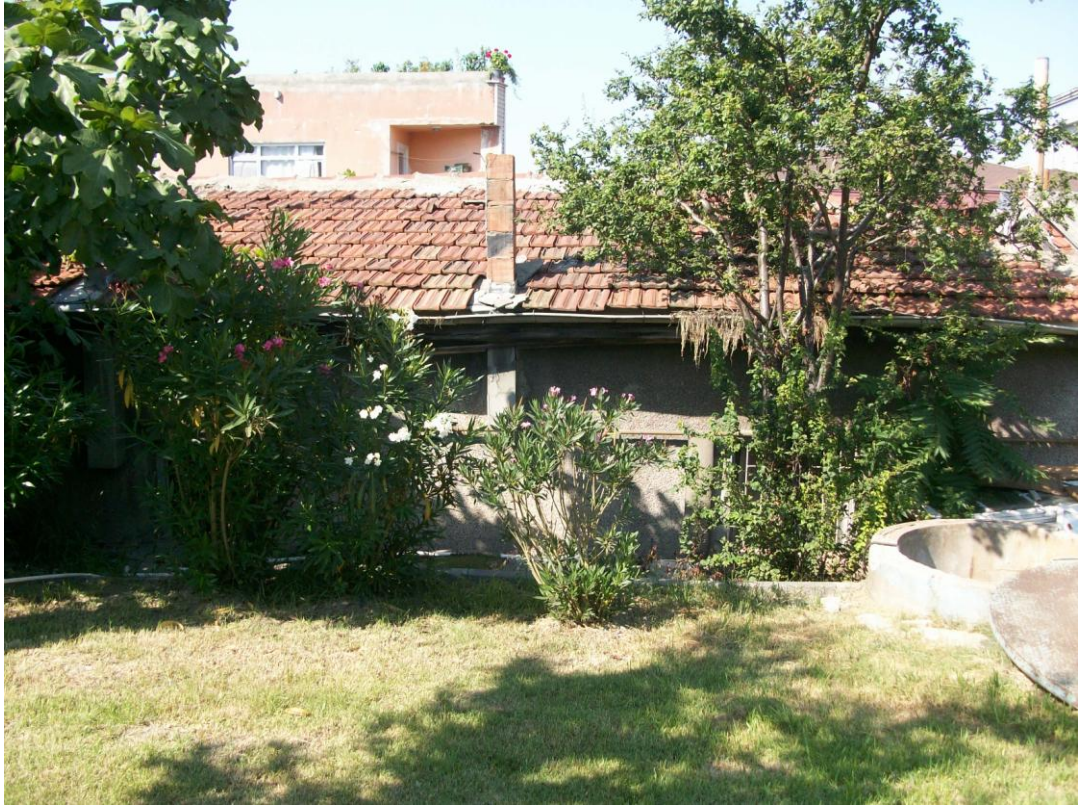
Şekil 4. 6 Personel binası işlevi gören binanın güney cephesi (2010)
