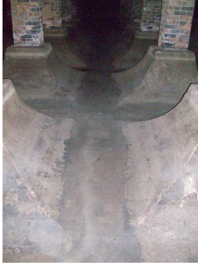
Şekil 4. 27 Çapraz tonoz zemin uygulaması (2010)
