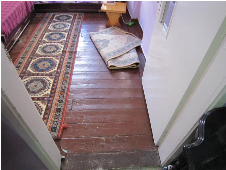
Şekil 4. 110 Ek bina oturma odası zemininin ahşap kaplaması (2010)
