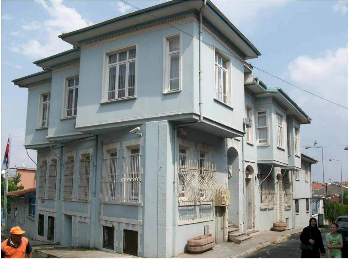
Şekil 4. 4 İSKİ Fatih Su, Kanal ve Ruhsat Şefliği binası (2010)
