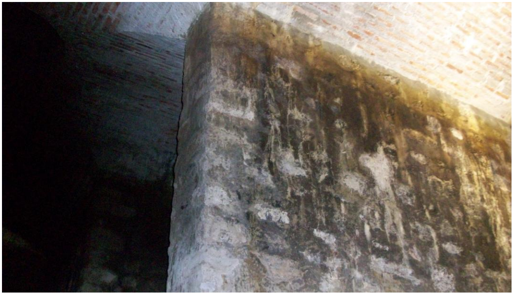
Şekil 4. 39 Kaba yonu moloz taş örgülü duvar (2010)
