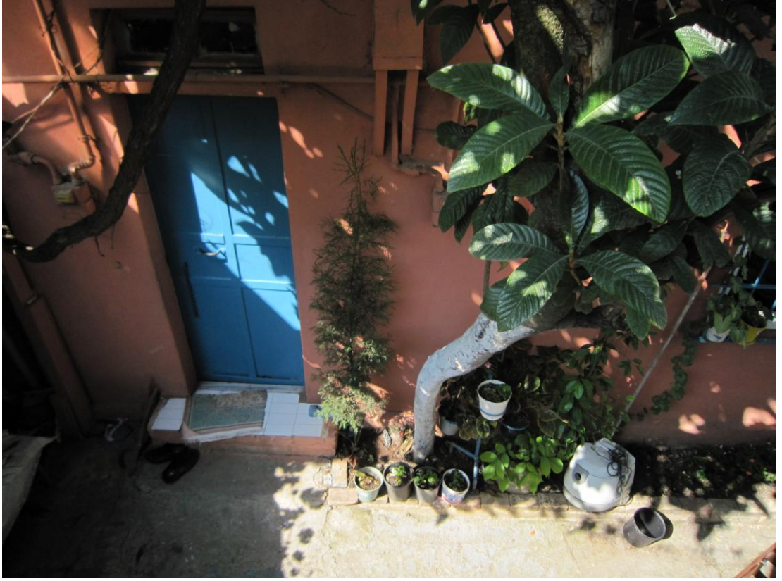
Şekil 4. 112 Ek bina güney cephesinin sarnıç üzerinden görünüşü (2010)
