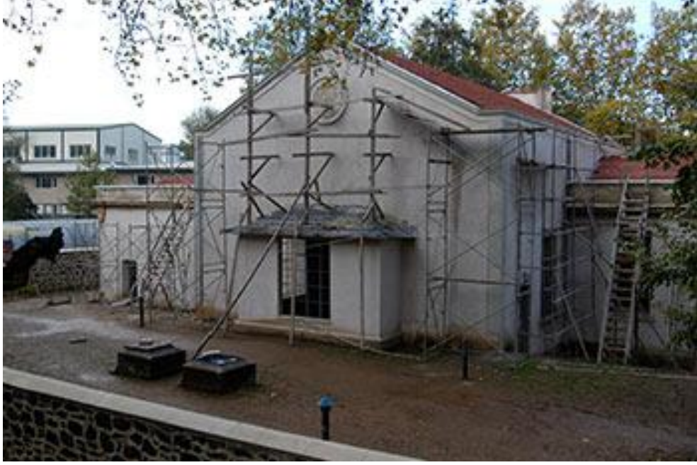
Şekil 3. 6 Cendere Hamidiye Su Pompa İstasyonu'nun restorasyon aşamasındaki görünüşü [26]
