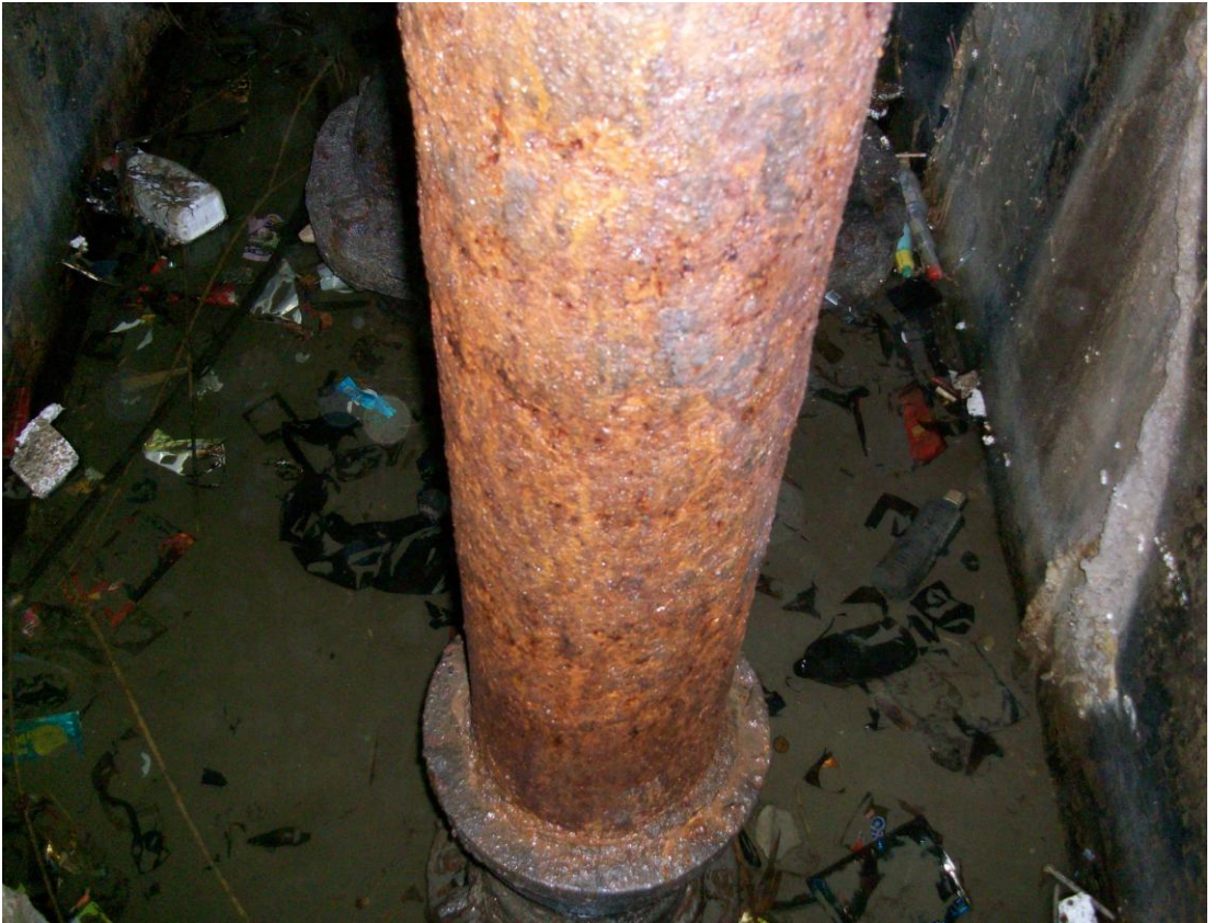
Şekil 4. 68 Vana mahallinde bulunan 45 cm çapındaki metal boru (2010)
