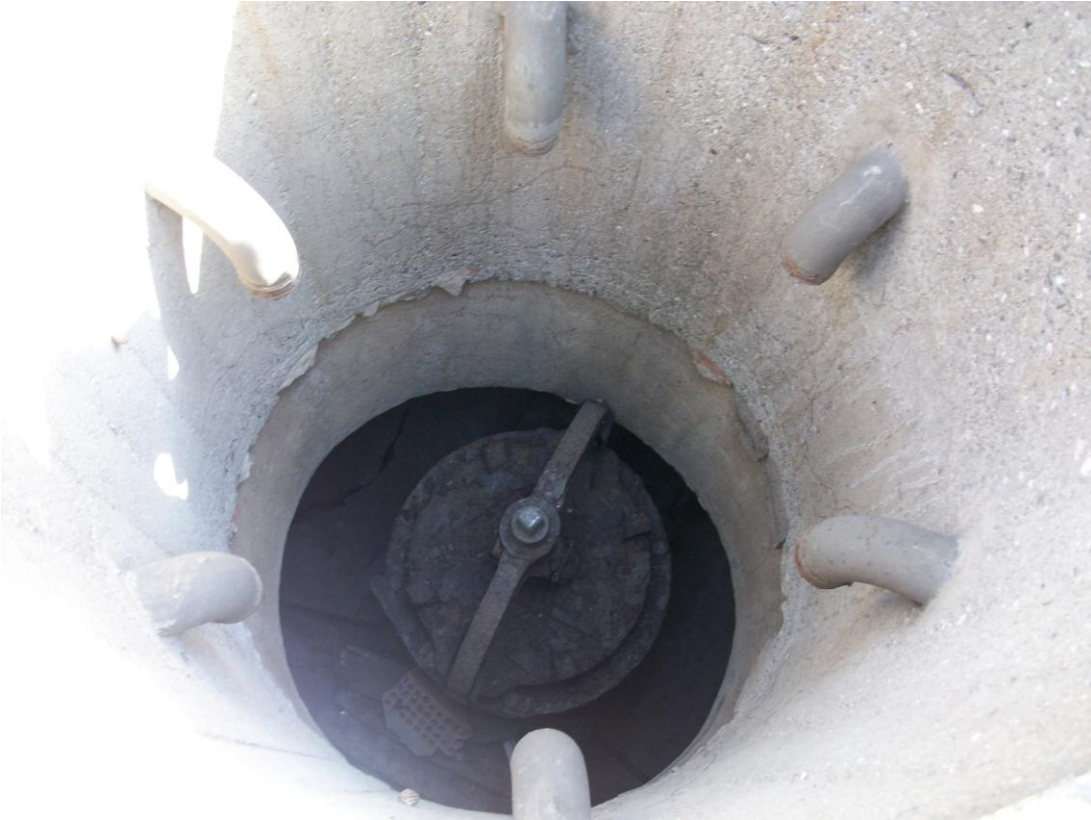
Şekil 4. 81 Su geliş borusunu kontrol eden vana (2010)
