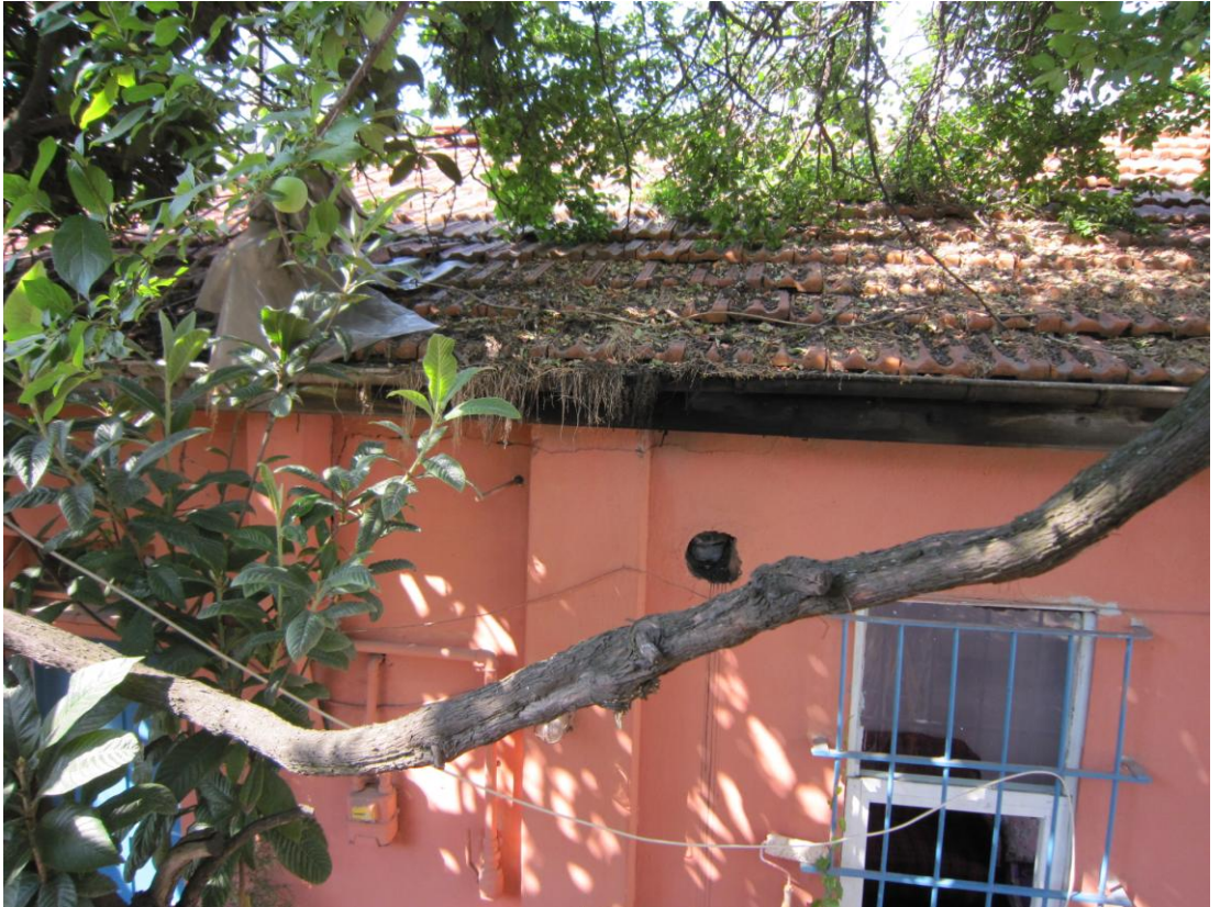
Şekil 4. 113 Ek binanın güney cephesinde çıkma yapan bölümün görünüşü (2010)
