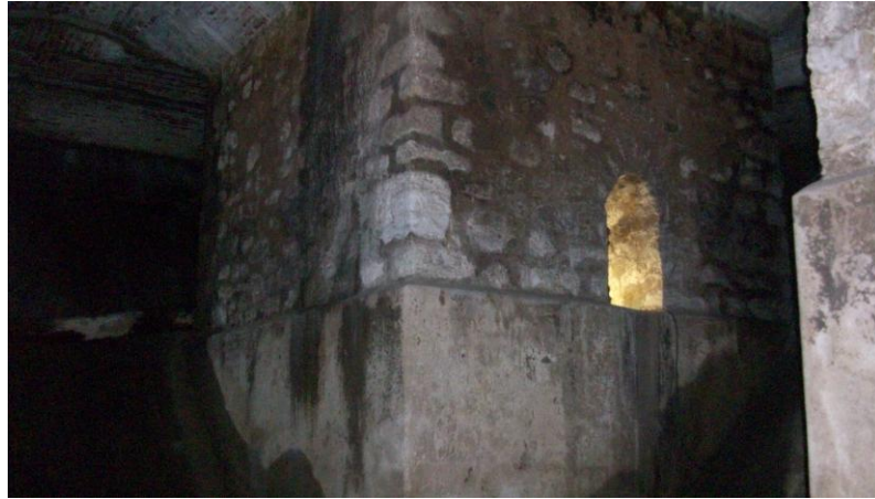
Şekil 4. 11 Yapının dört köşesinde bulunan kare planlı dolu savakları (2010)
