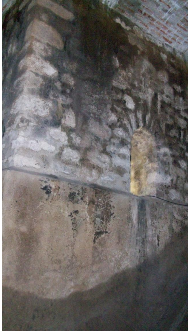
Şekil 4. 73 Dolu savak pencerelerinin çevresindeki taşlar (2010)
