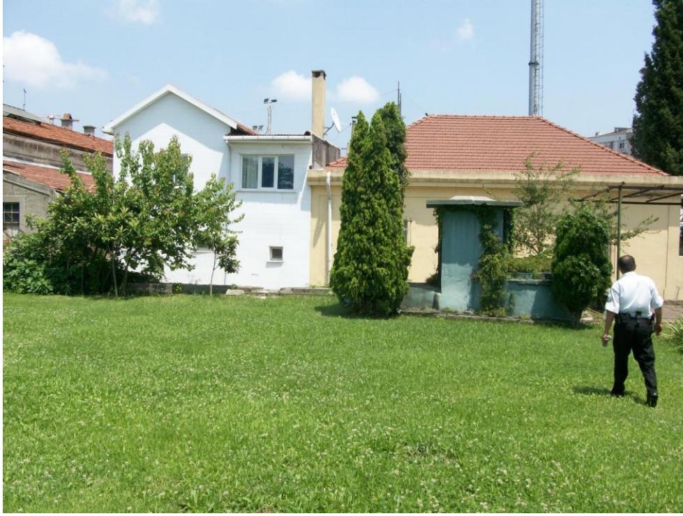
Şekil 3. 21 Feriköy Sarnıcı'na girilen merdiven bacasının görünüşü (2010)
