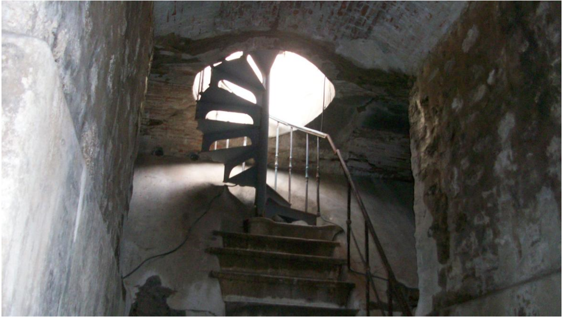
Şekil 4. 19 B1 bacası ve döner merdiven (2010)
