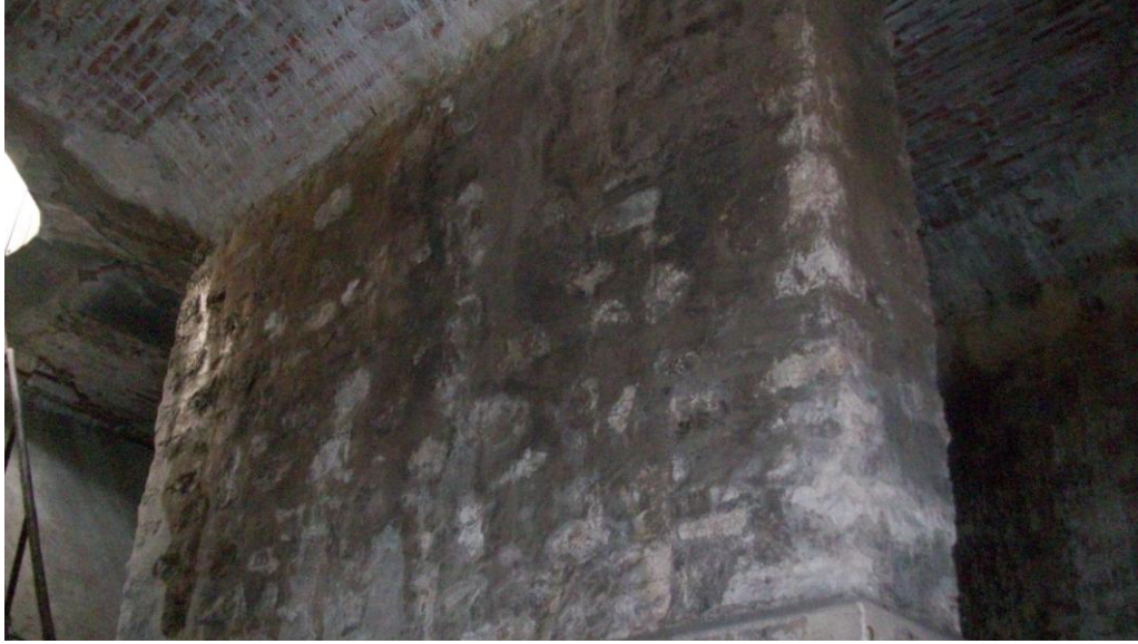
Şekil 4. 71 Duvarlardaki kaba yonu taş örgü (2010)
