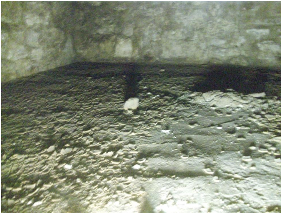
Şekil 4. 46 Boşluğu kapatılmış dolu savak döşemesi (2010)
