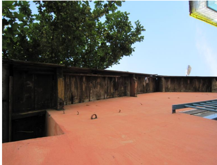
Şekil 4. 118 Ek bina çatısının saçığı (2010)
