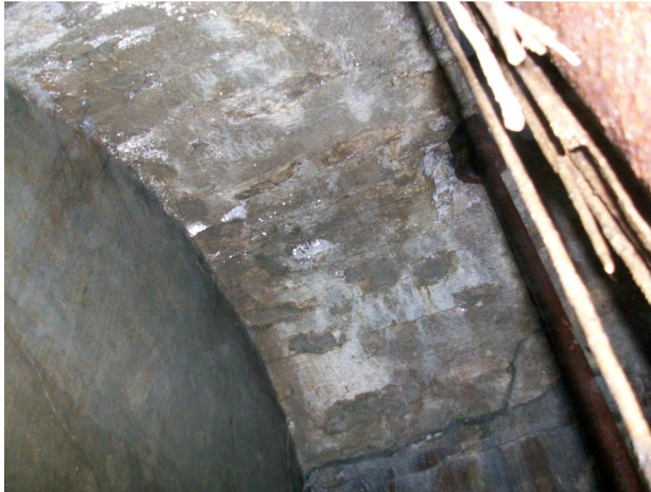
Şekil 4. 72 Vana mahalli tavan ve duvarlarındaki kaba yonu taş örgü (2010)
