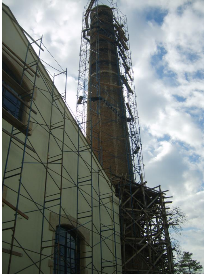
Şekil 3. 7 Terkos Su Pompa İstasyonu'nun restorasyon aşamasındaki görünüşü (2010)
