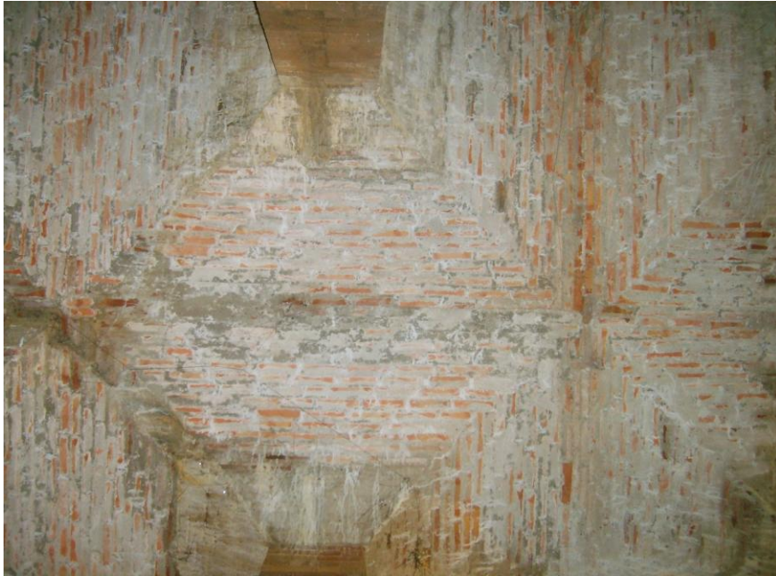
Şekil 4. 34 Çapraz tonoz örgüsünde tuğla dizilimi (2010)
