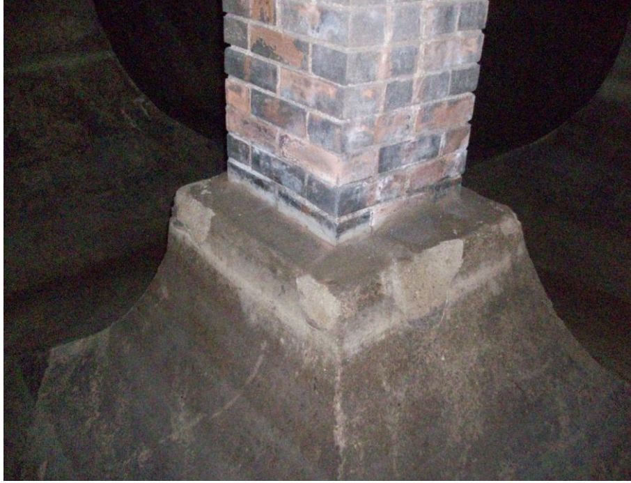
Şekil 5. 17 Ayak kaidesinin sıvalı yüzeyinde malzeme kaybı (2010)
