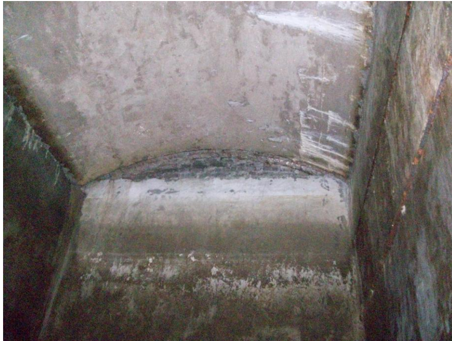
Şekil 3. 18 Feriköy Sarnıcı, duvar tuğlaları görülen tavan tuğlası (2010)
