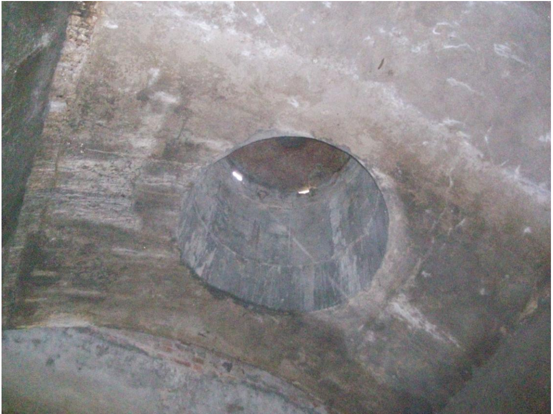
Şekil 3. 20 Feriköy Sarnıcı'ndaki havalandırma bacasının içeriden görünüşü (2010)
