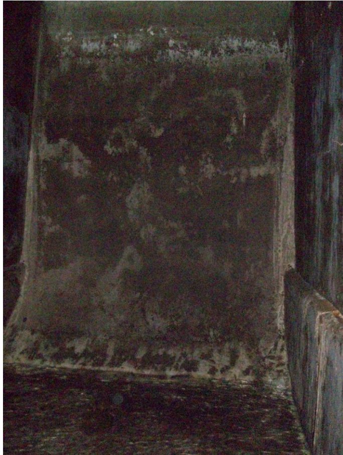
Şekil 3. 22 Feriköy Sarnıcı güneydoğu duvarının içeriden görünüşü (2010)
