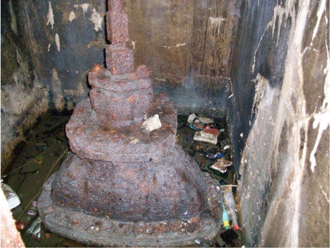
Şekil 4. 67 Vana mahallindeki dip tahliye vanasının görünüşü (2010)
