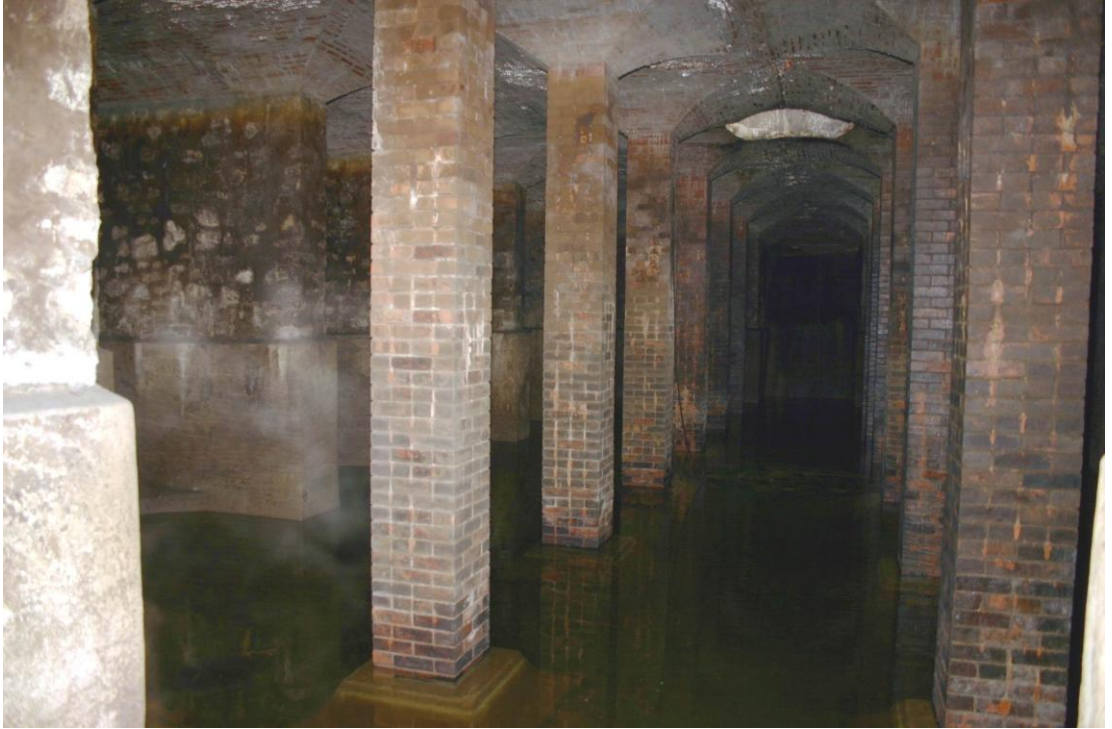
Şekil 4. 29 Duvar ve ayaklarda farklı yüksekliklerde son bulan sıva kullanımı [28]
