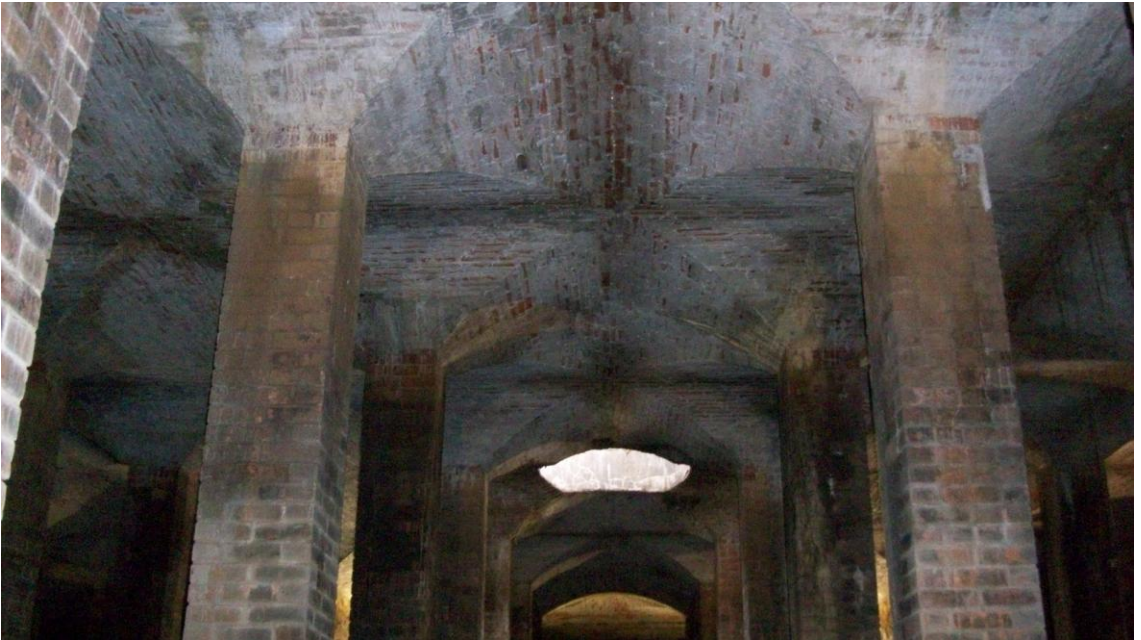
Şekil 4. 43 Tuğla ayak-çapraz tonoz çatı örtüsü bağlantısı (2010)
