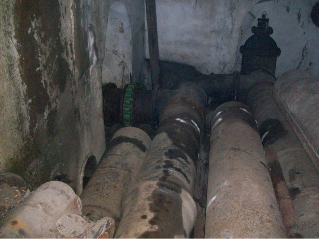
Şekil 3. 32 Vana mahallindeki su borularının görünüşü (2010)
