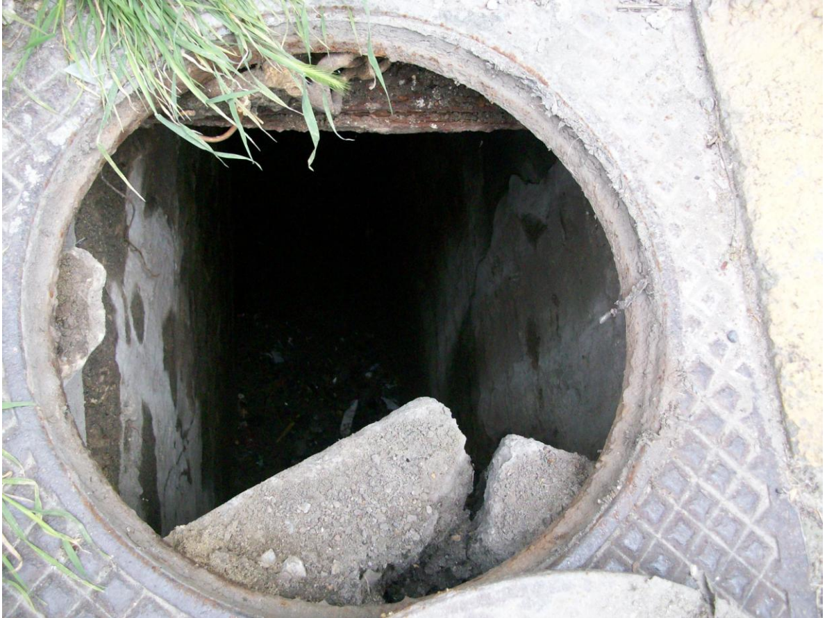
Şekil 4. 63 Vana mahalline girişi sağlayan metal kapaklı bölüm (2010)
