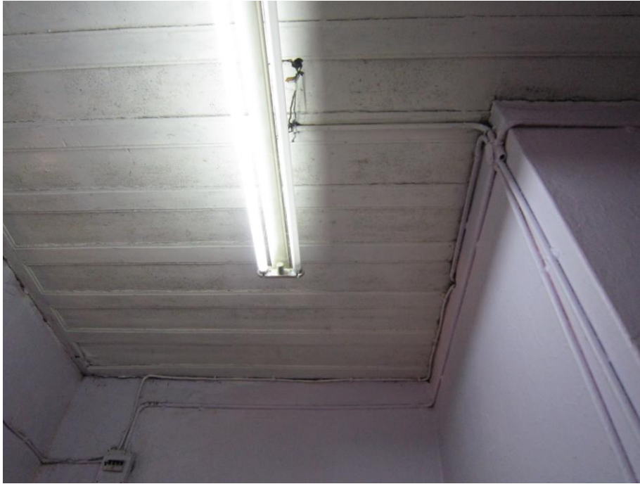
Şekil 4. 99 Ek binadaki hol mahallinin özgün ahşap tavan kaplaması (2010)
