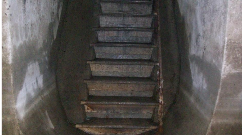
Şekil 4. 60 Taş merdivenin basamak rıht ve profilleri (2010)
