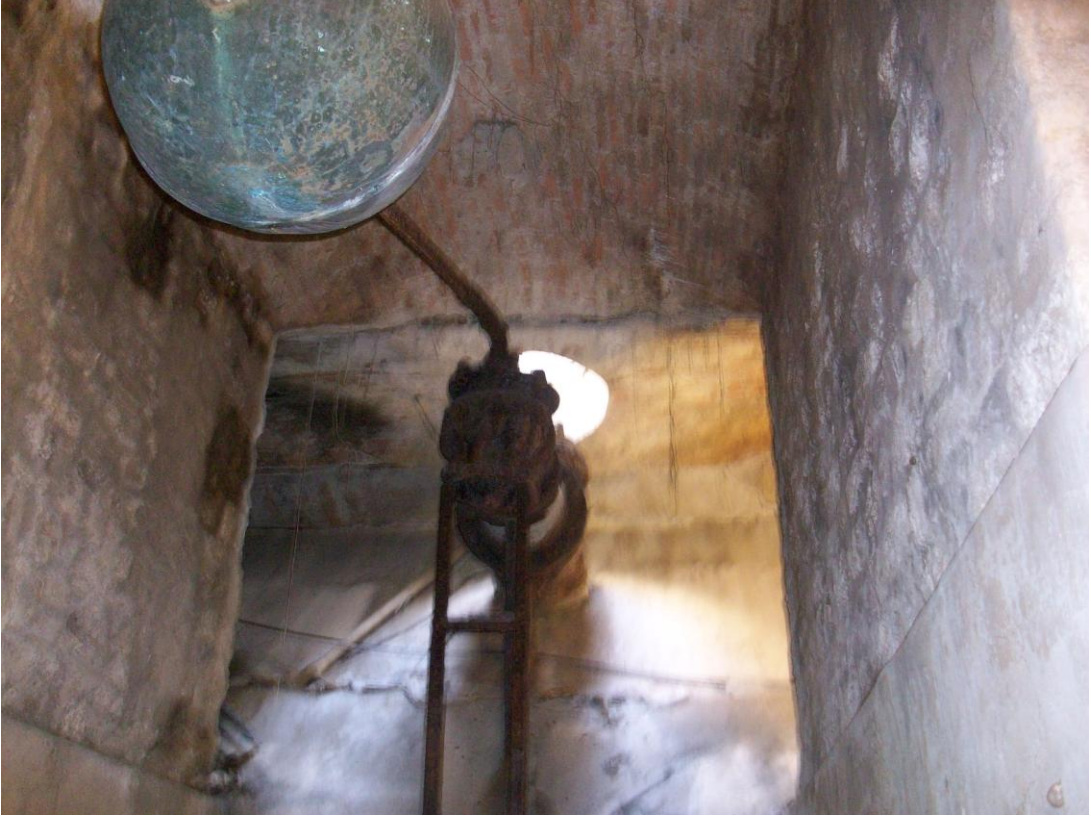
Şekil 4. 80 Metal su geliş borusu (2010)
