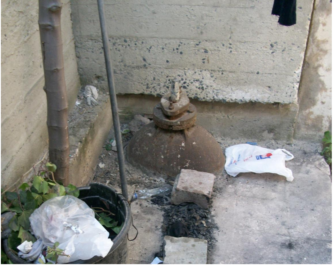
Şekil 4. 85 İkinci su geliş borusunu kontrol eden vana (2010)
