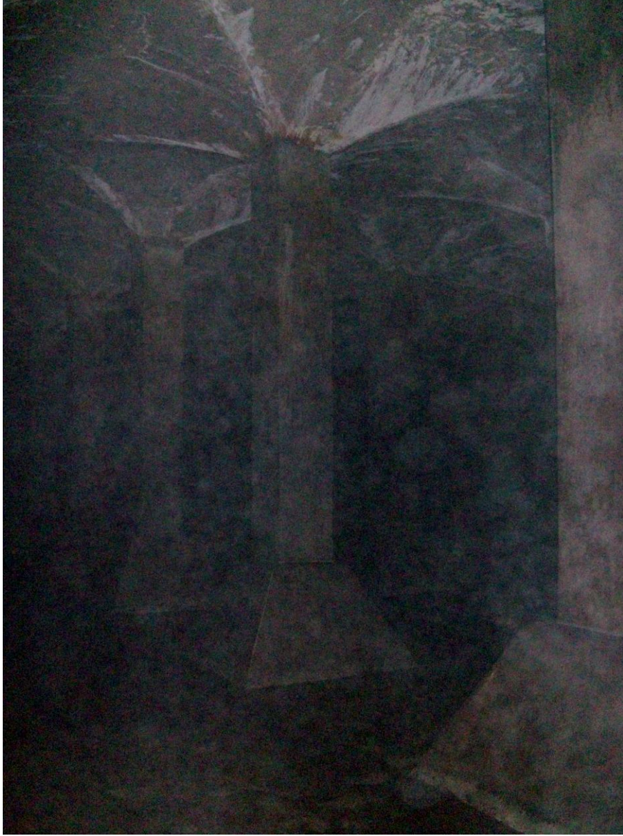
Şekil 3. 15 Feriköy Sarnıcı'ndaki taşıyıcı ayak-tavan bağlantısı (2010)
