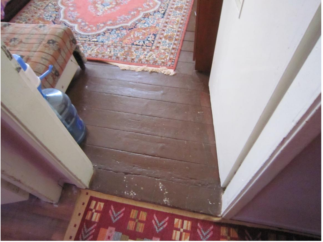
Şekil 4. 107 Ek bina yatak odası zemininin ahşap döşeme kaplaması (2010)
