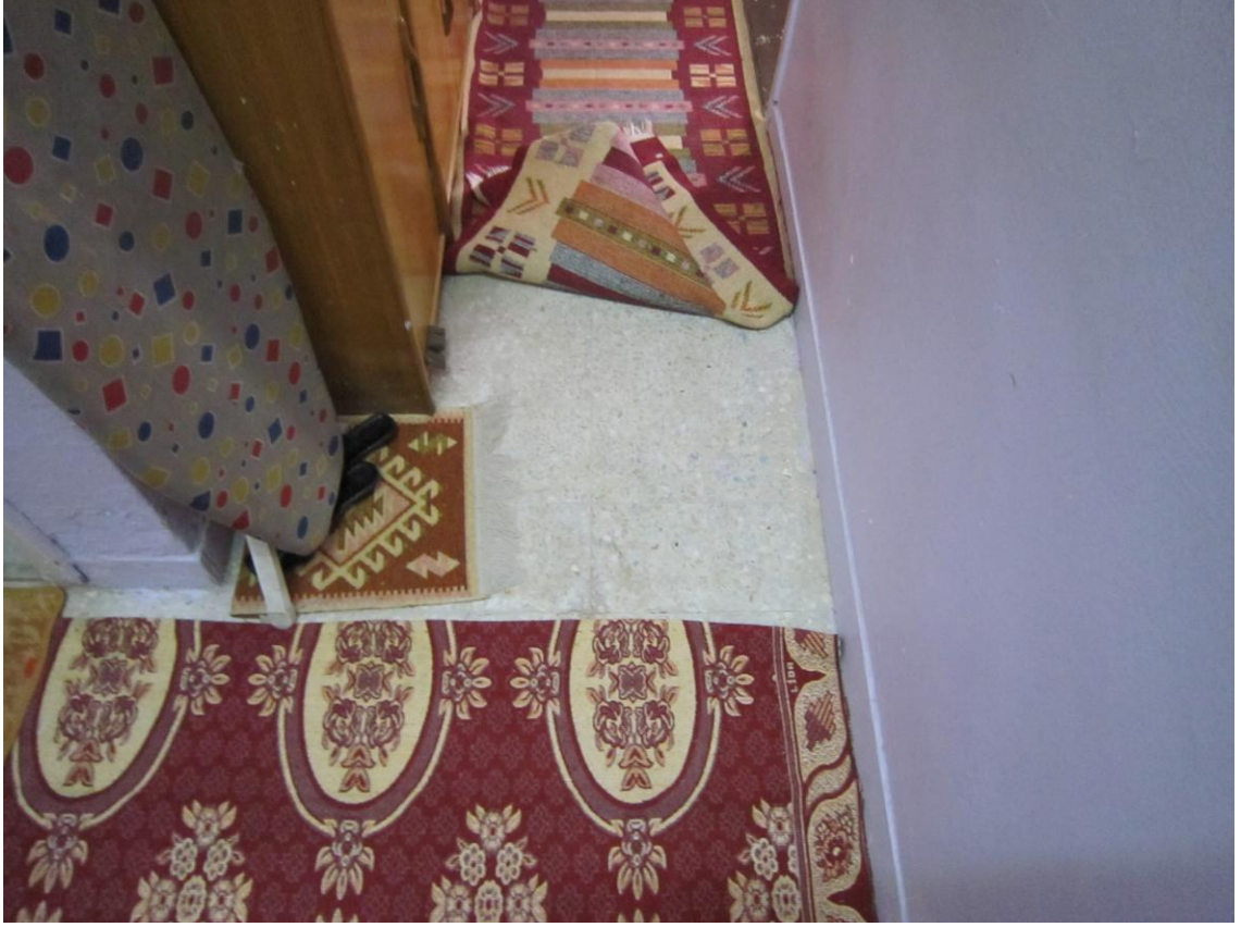
Şekil 4. 100 Ek binadaki hol mahallinin zeminindeki taş kaplama ve taş süpürgelik (2010)
