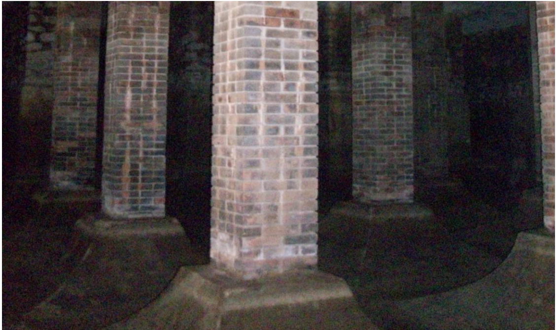
Şekil 4. 79 Ayaklarda kullanılan tuğla örgü sistemi (2010)
