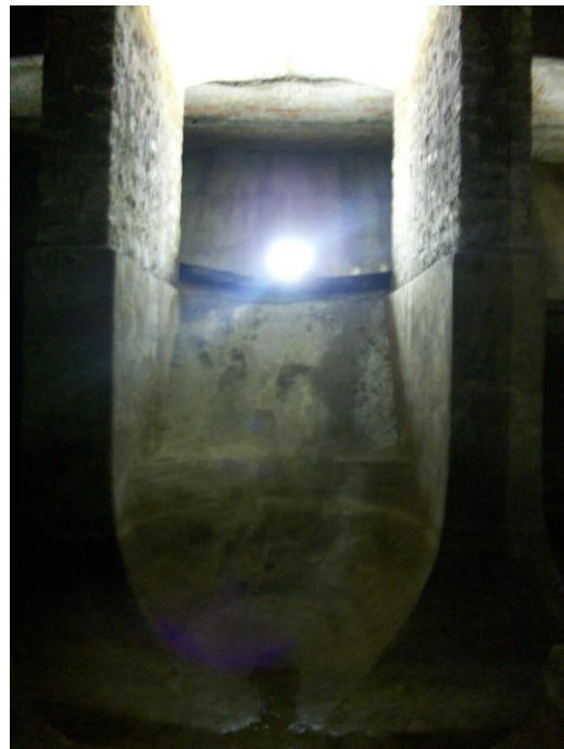
Şekil 5. 12 Doğu duvarında C-I aksları arasındaki çatlak (2010)
