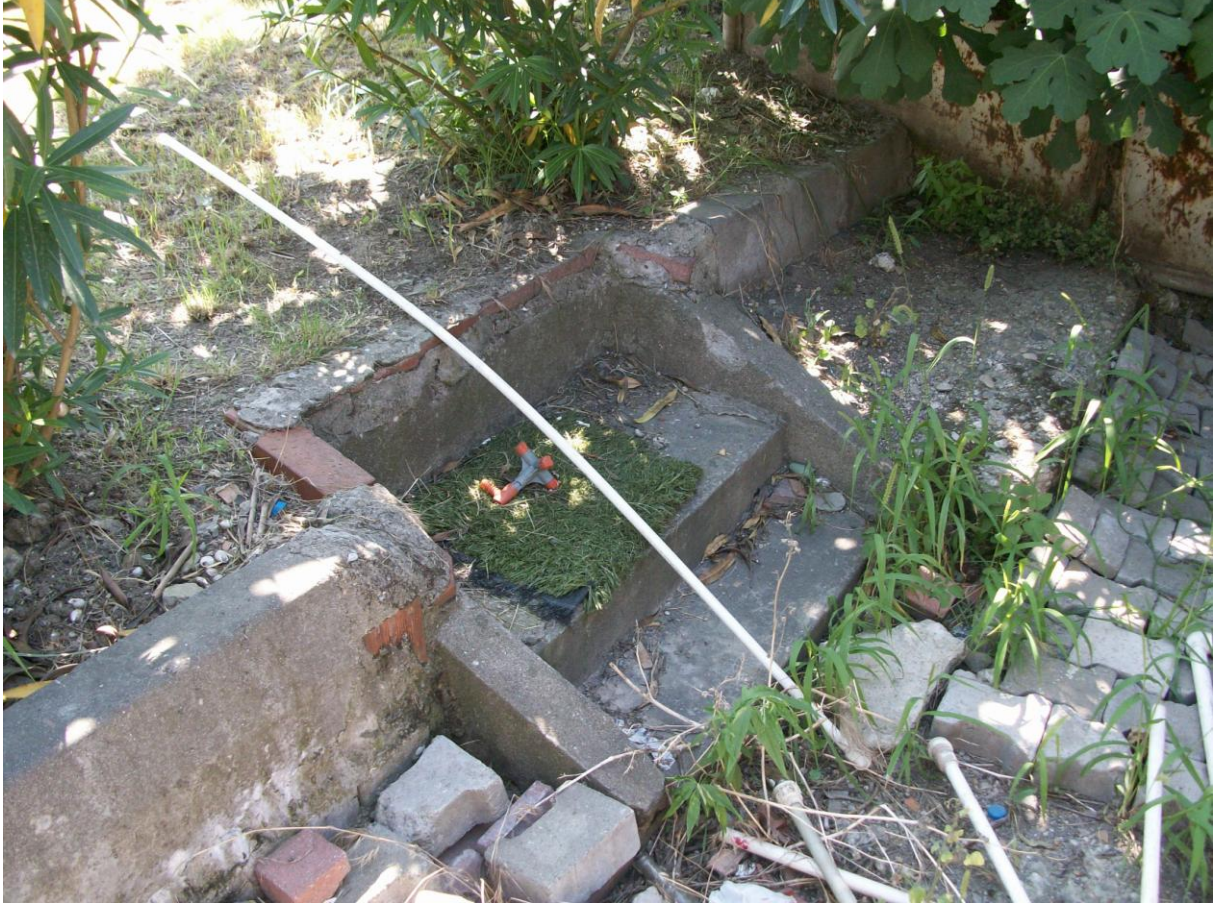
Şekil 6.5 Bekçi evinden sarnıca çıkmak için kullanılan merdiven (2010)
