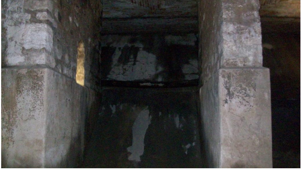
Şekil 4. 14 Dış duvarın eğimli iç yüzeyi (2010)
