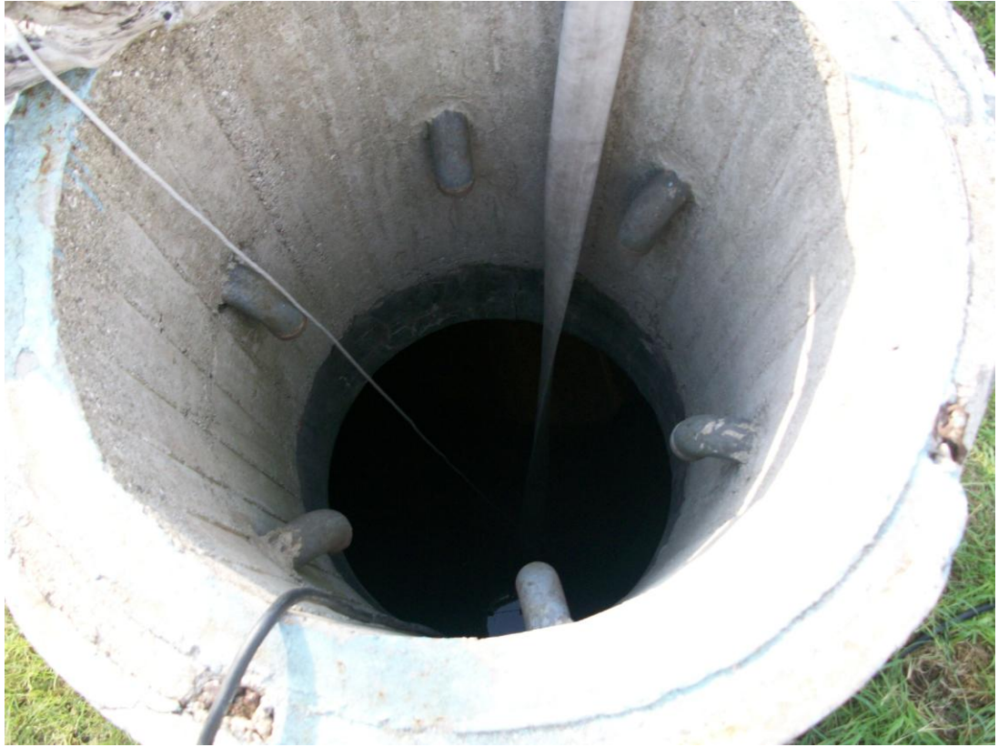
Şekil 4. 56 Havalandırma borularının parapetin içinden görünüşü (2010)
