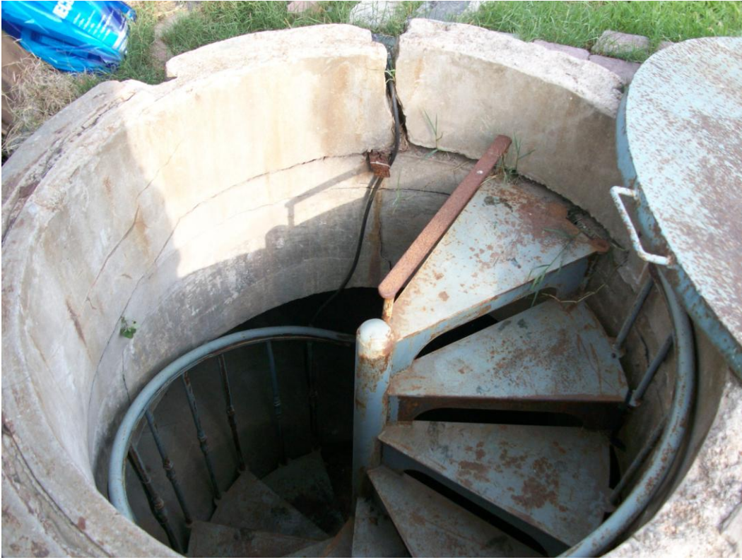
Şekil 4. 57 Merdiven bacasında bulunan ve yapıya girişi sağlayan döner merdiven (2010)
