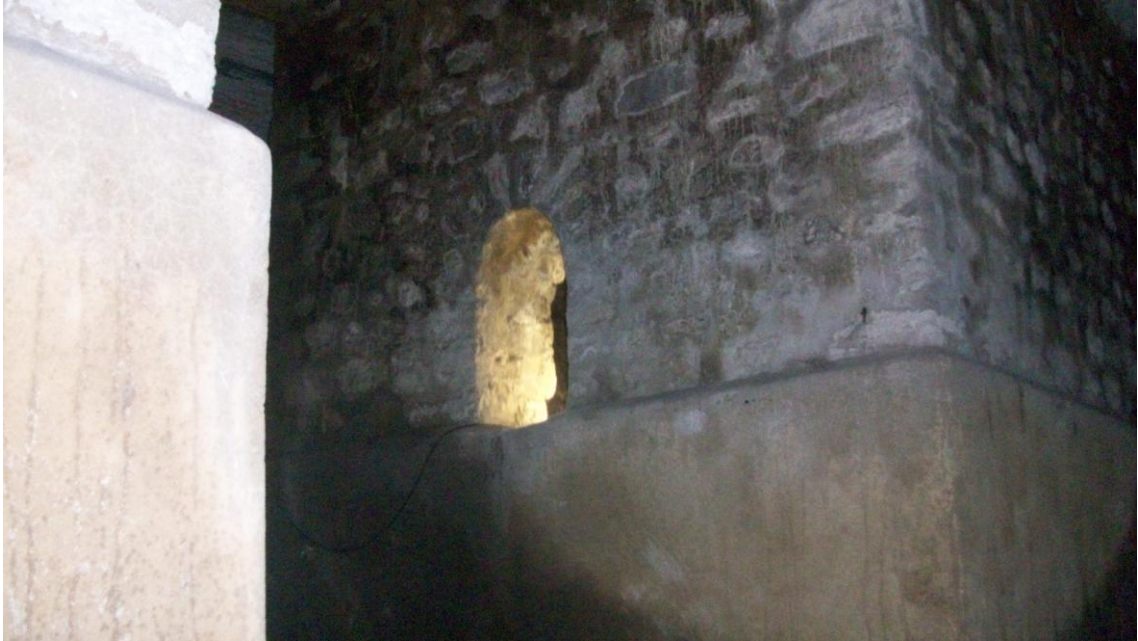
Şekil 4. 44 Dolu savak duvarlarındaki pencere (2010)
