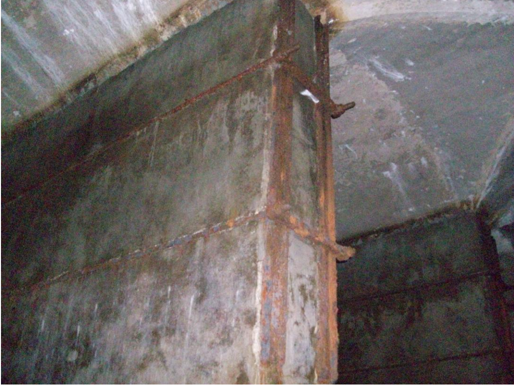
Şekil 3. 23 Feriköy Sarnıcı'nda ara duvar ve çevresindeki metal kuşaklama (2010)
