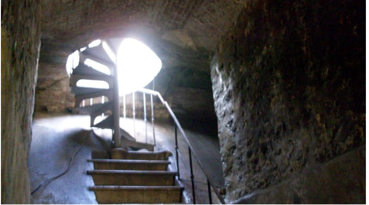
Şekil 4. 59 Metal döner merdivenin taş basamaklar ile bağlantısı (2010)
