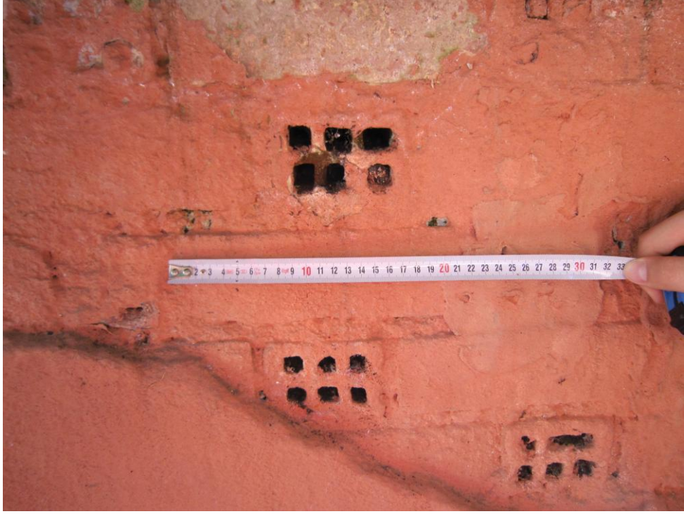
Şekil 4. 91 Edirnekapı Sarnıcı'nın ek bina bahçesine bakan duvarındaki tuğla boyu (2010)
