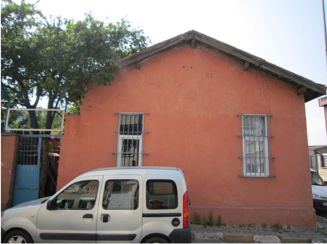
Şekil 4. 114 Ek binanın doğu cephesinin görünüşü (2010)
