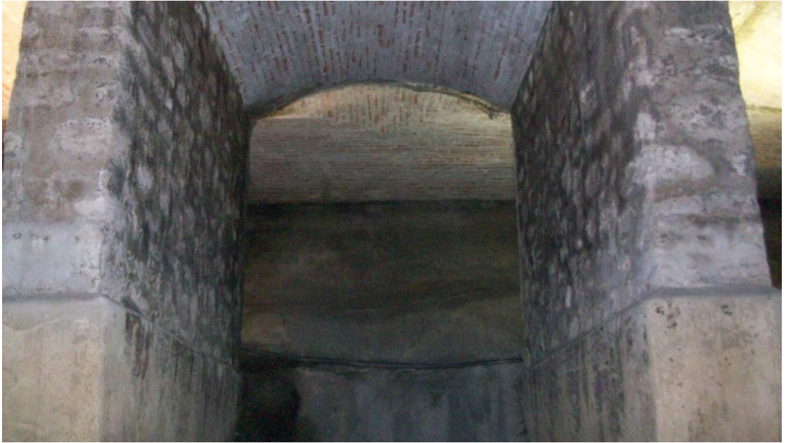
Şekil 4. 75 Ara duvarlardaki pahlı sıva bitişinin görünüşü (2010)
