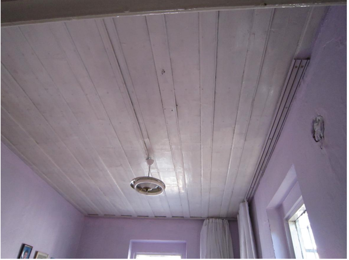
Şekil 4. 111 Ek bina oturma odası tavanının ahşap kaplaması (2010)
