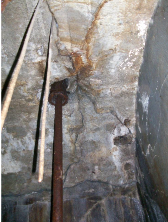
Şekil 4. 70 Vana mahallindeki tavanı delen Ø5 cm.lik metal boru (2010)
