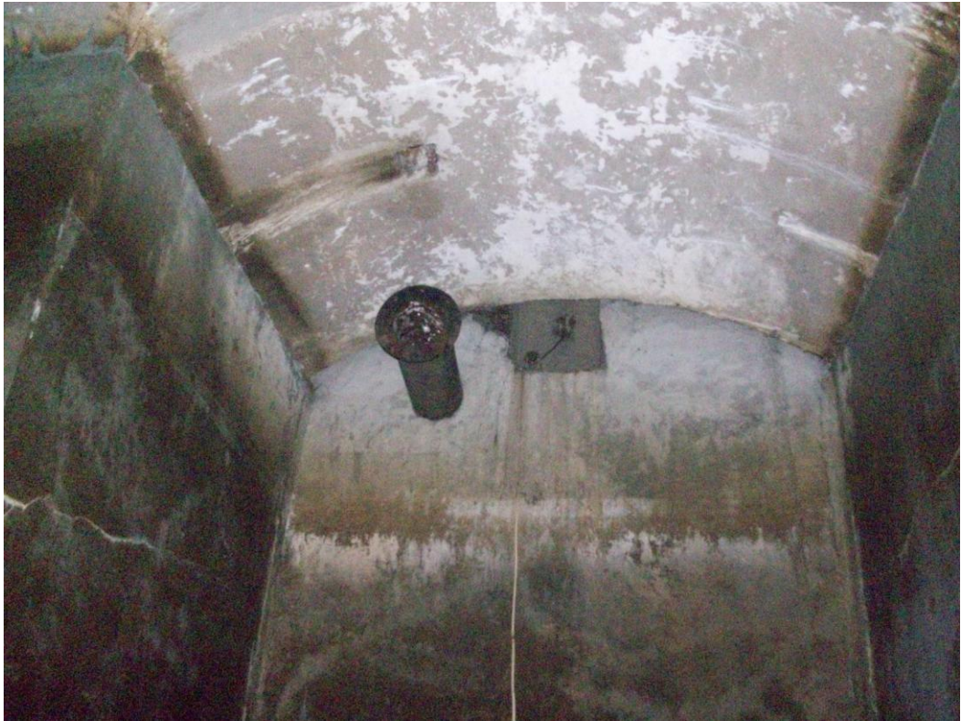
Şekil 3. 27 Feriköy Sarnıcı'ndaki işlevi anlaşılamayan borulardan birinin görünüşü (2010)
