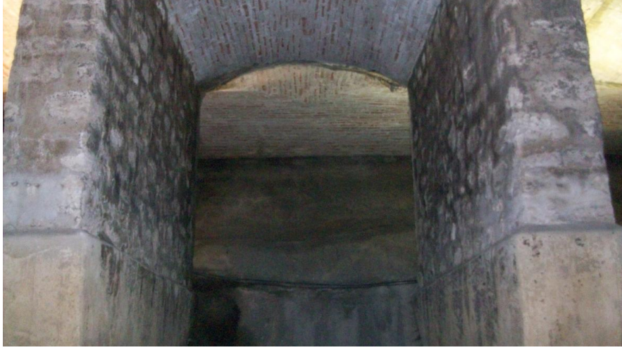
Şekil 4. 33 Sarnıcın kenarlarda ve ara duvar araları bölümünde kullanılan beşik tonoz çatı örtüsü (2010)
