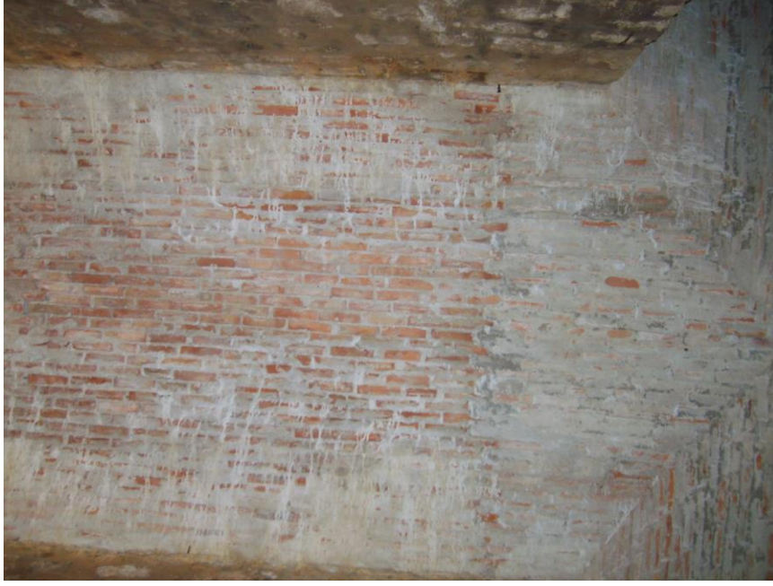
Şekil 4. 35 Beşik tonoz örgüsünde tuğla dizilimi (2010)
