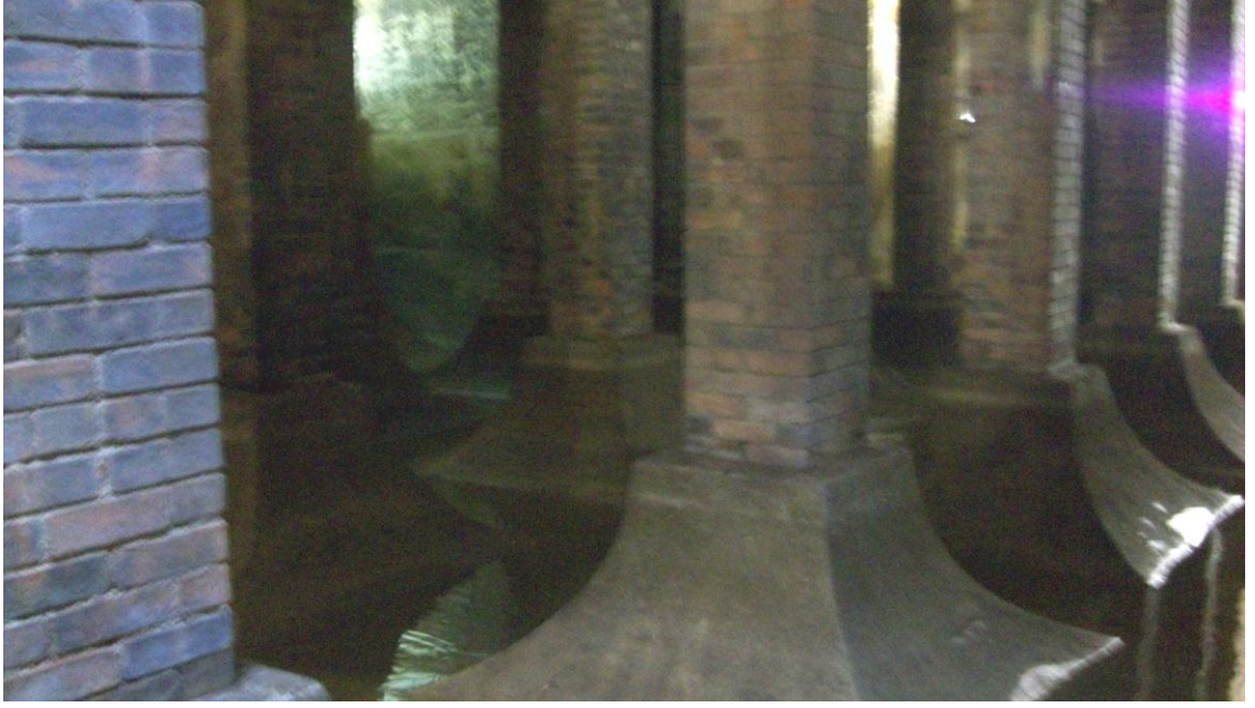
Şekil 4. 74 Ayak kaidelerindeki düz sıva bitişinin görünüşü (2010)
