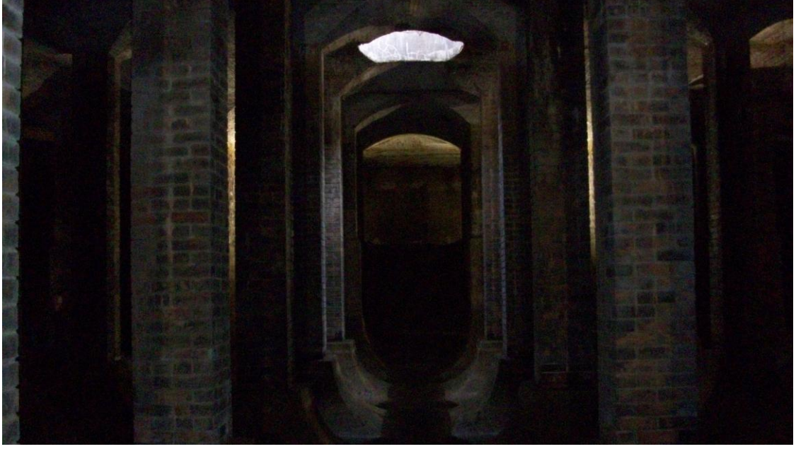
Şekil 4. 18 Zemin ve tavadaki çapraz tonoz yapım sistemi (2010)
