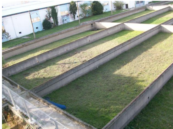
Şekil 3. 8 Kağıthane İçme Suyu Arıtma Tesis'i'nin bugünkü durumu (2010)
