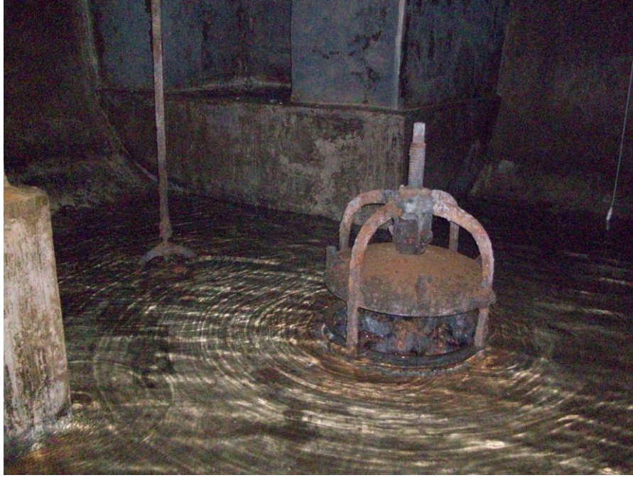
Şekil 3. 28 Feriköy Sarnıcı'ndaki dip savak ve vanası (2010)
