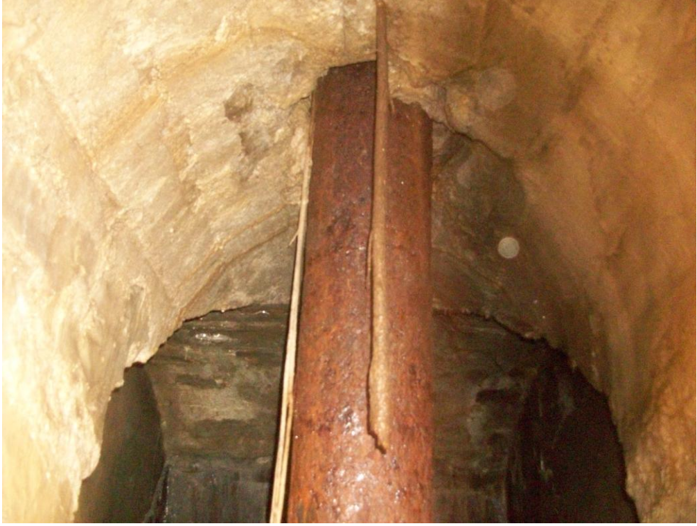
Şekil 4. 69 Vana mahallinde bulunan 45 cm çapındaki metal boru (2010)
