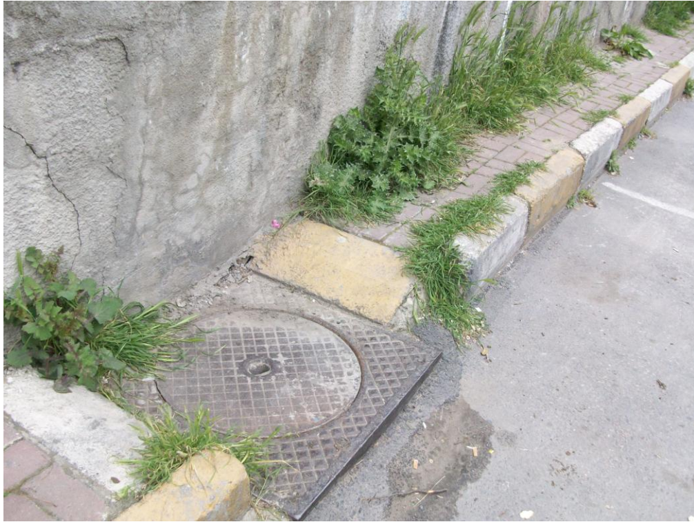
Şekil 4. 21 Vana mahalline girilen ve yaya kaldırımında yer alan kapak (2010)
